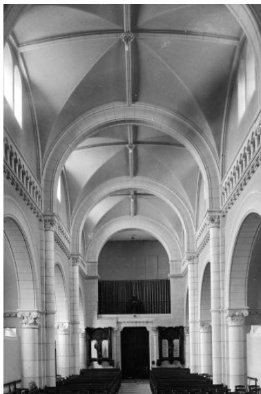
Nef, vue générale vers l'entrée. Phot. Guy Artur, Phot. Norbert Lambart IVR53_19863500555V
