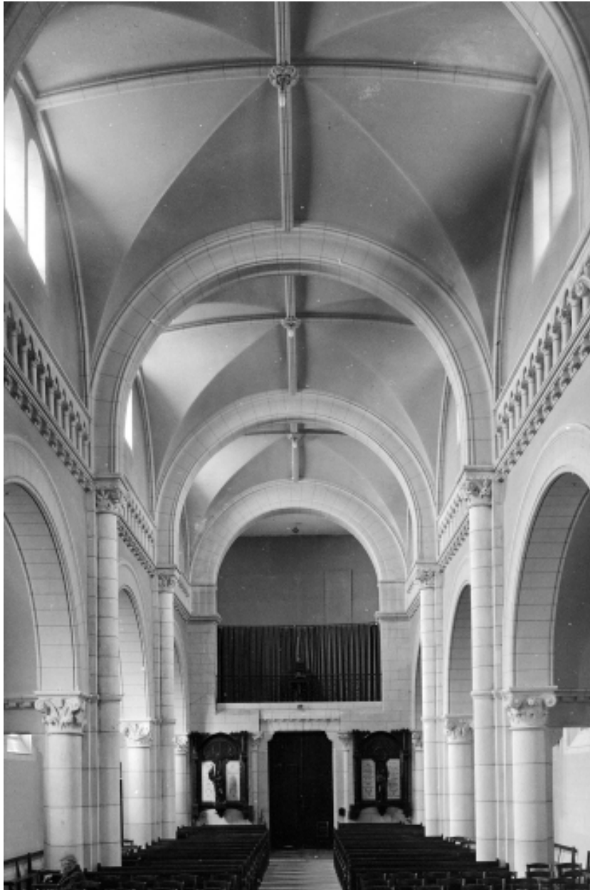
Nef, vue générale vers l'entrée.
