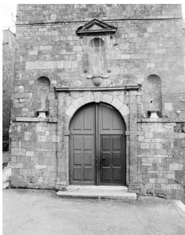
Elévation Ouest, portail : vue générale. Phot. L. Lamandé IVR53_19853501013X
