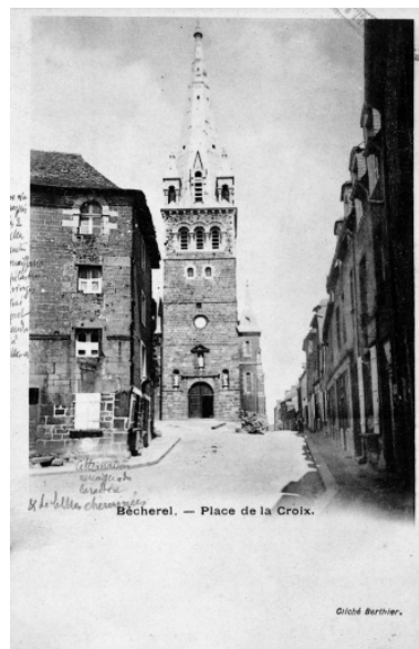
Elévation Ouest : vue générale, après 1900. Phot. Guy Artur, Phot. Norbert Lambart IVR53_19843501211V
