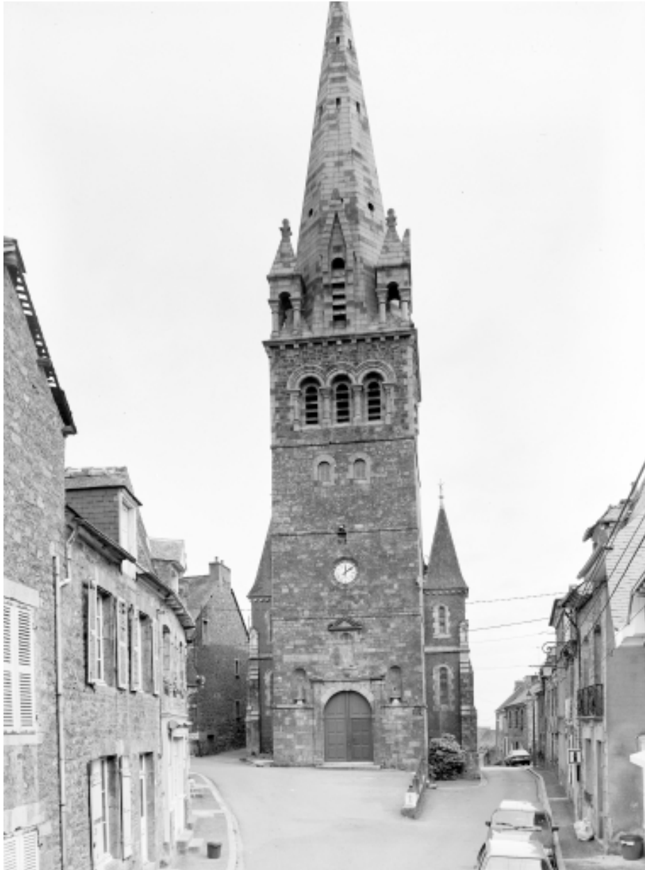
Elévation Ouest : vue générale
