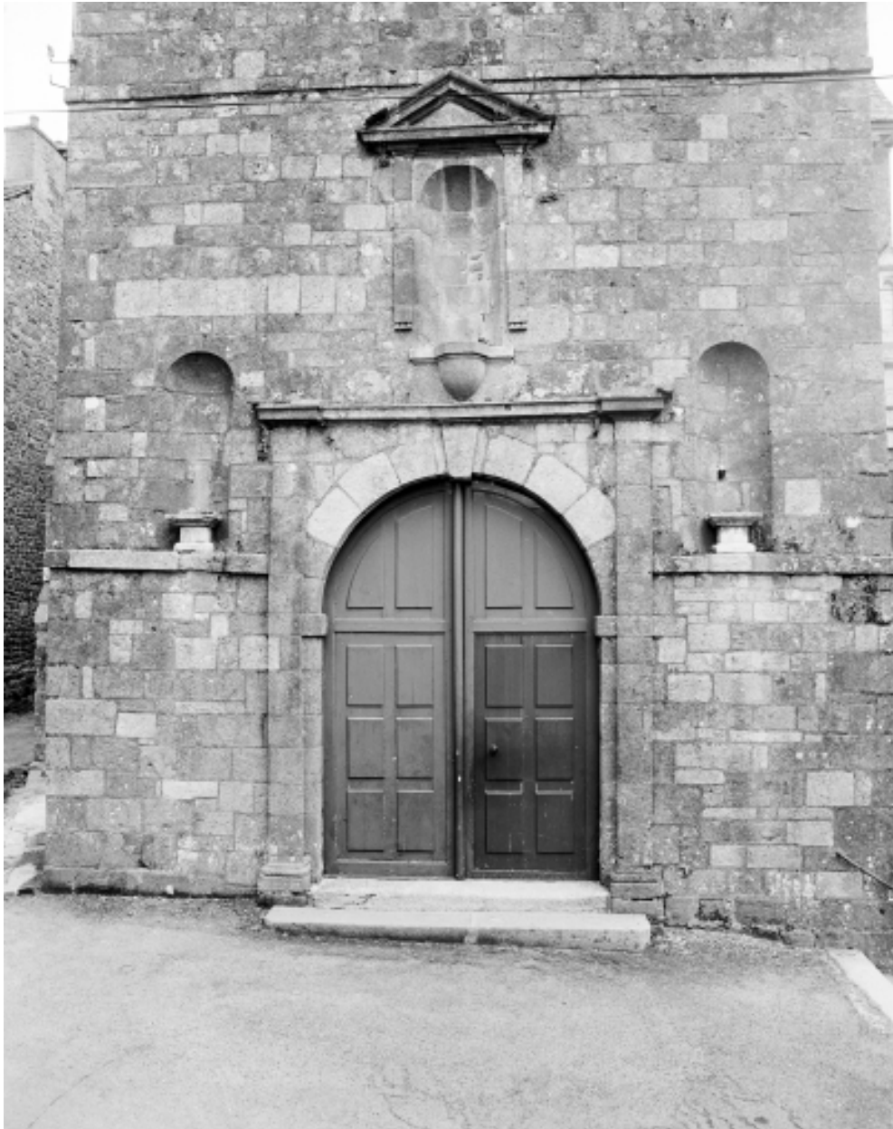
Elévation Ouest, portail : vue générale.
