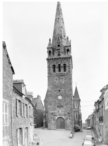
Elévation Ouest : vue générale Phot. L. Lamandé IVR53_19853501327V
