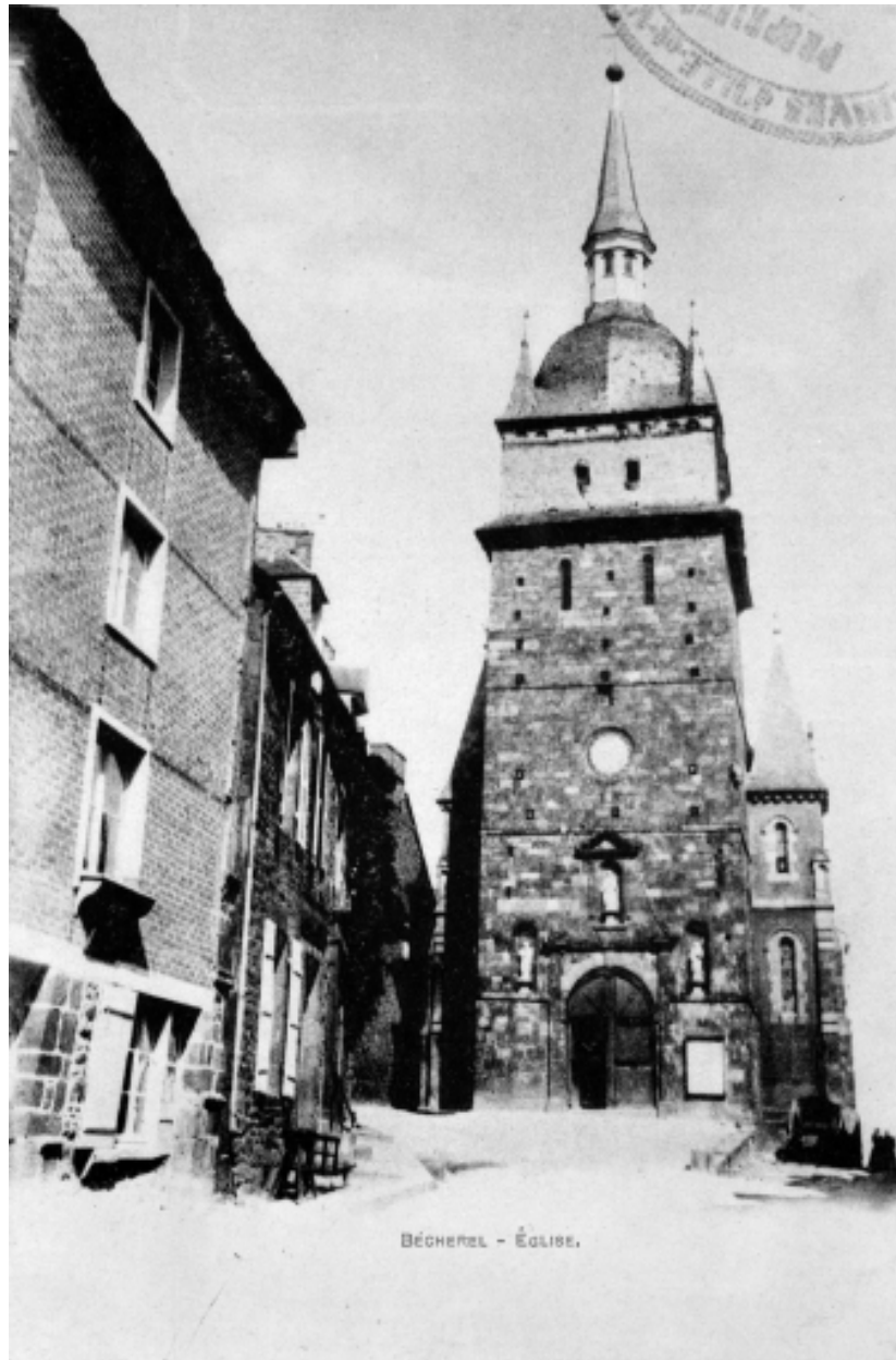
Elévation Ouest : vue générale. avant 1898.
