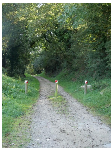
Voie verte ancienne voie ferrée Repro. Auteur inconnu IVR53_20242911487NUCA
