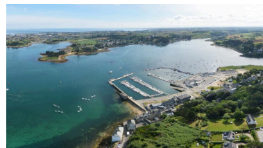
Port de l'Aber Wrac'h : vue aérienne Phot. INOVADYS IVR53_20242910550NUCA
