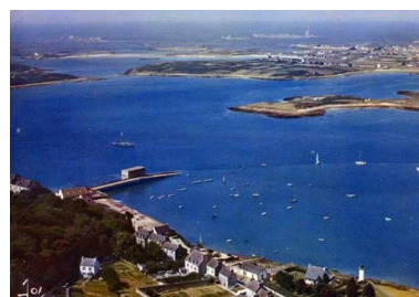
Port de l'Aber Wrac'h, vue aérienne avant les travaux Phot. Patrick Oulhen IVR53_20242910546NUCA
