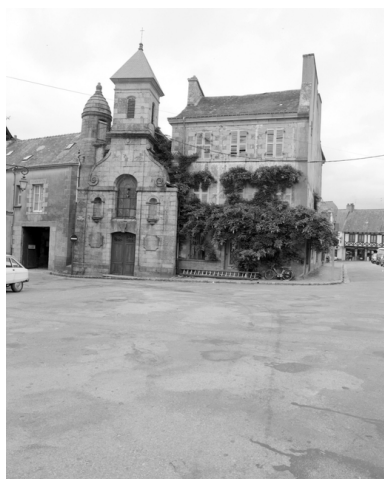
Vue générale de la façade principale sud. Phot. François Dagorn IVR53_19745600455X
