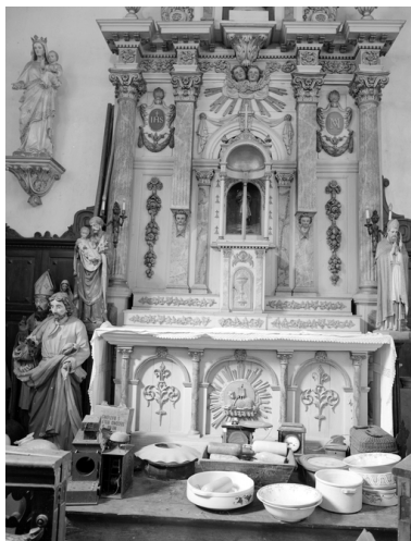
Autel, vue générale. Phot. François Dagorn IVR53_19745600463X
