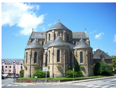
Le Relecq-Kerhuon, église Notre-Dame : élévation est Phot. Gwénaél Fauchille IVR53_20082905974NUCA
