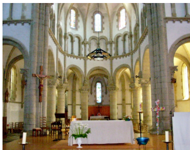
Le Relecq-Kerhuon, église Notre-Dame : chœur vue de la croisée du transept Phot. Gwénaél Fauchille IVR53_20082905977NUCA
