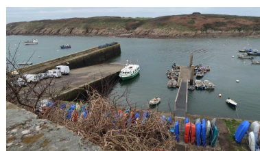
Môle et cale Saint- Christophe et ponton depuis le chemin d'accès au port Phot. Erwana L'Haridon IVR53_20242910178NUCA
