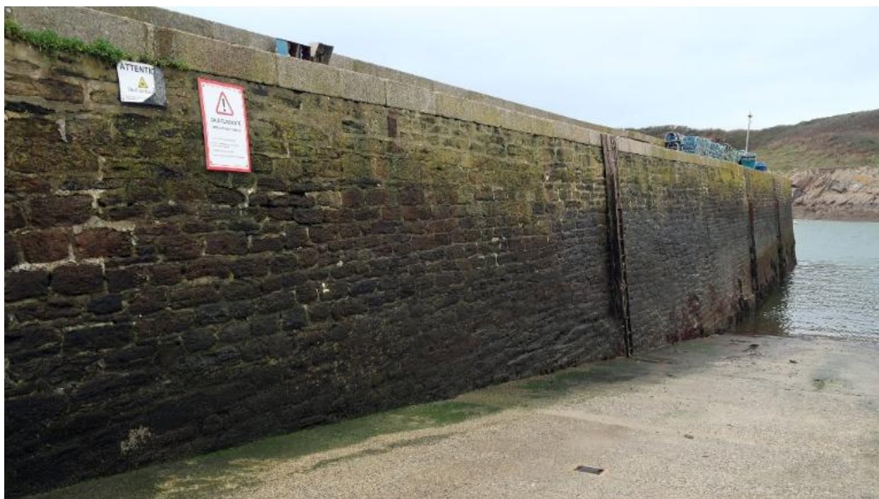
Môle Saint-Christophe : massif poids en maçonnerie (mortier de ciment et chaux), échelles
