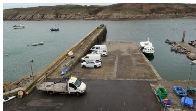
Môle et cale Saint-Christophe Phot. Erwana L'Haridon IVR53_20242910179NUCA
