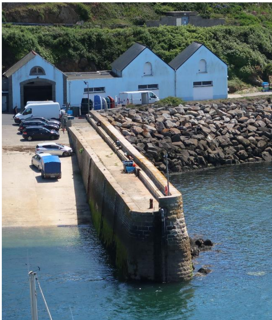
Môle Saint-Christophe, vue du couronnement et de la mise en œuvre des maçonneries
