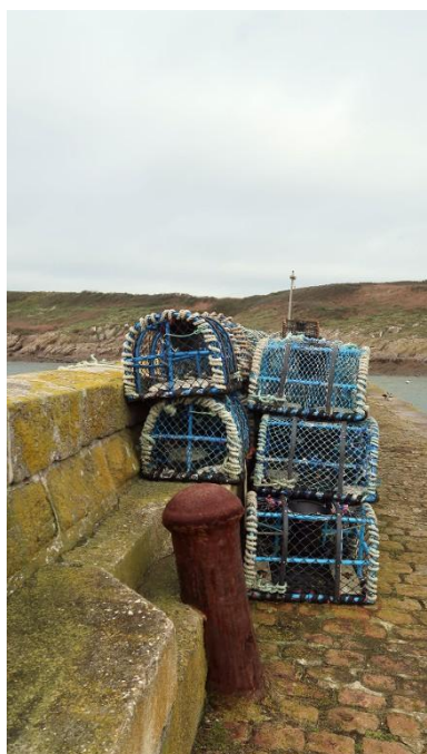
Môle Saint-Christophe : mises en oeuvre de la maçonnerie du parapet et de la plate-forme, bollard et usage de rangement des casiers Phot. Erwana L'Haridon IVR53_20242910182NUCA
