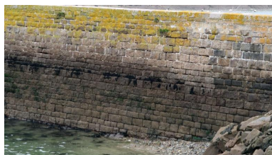
Môle Saint-Christophe : parement maçonné face ouest Phot. Erwana L'Haridon IVR53_20242910190NUCA
