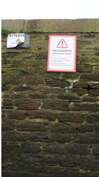
Môle Saint-Christophe : panneaux de sécurité Phot. Erwana L'Haridon IVR53_20242910187NUCA
