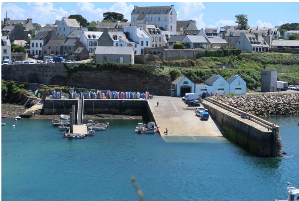
Môle Saint-Christophe, cale et terre-plein
