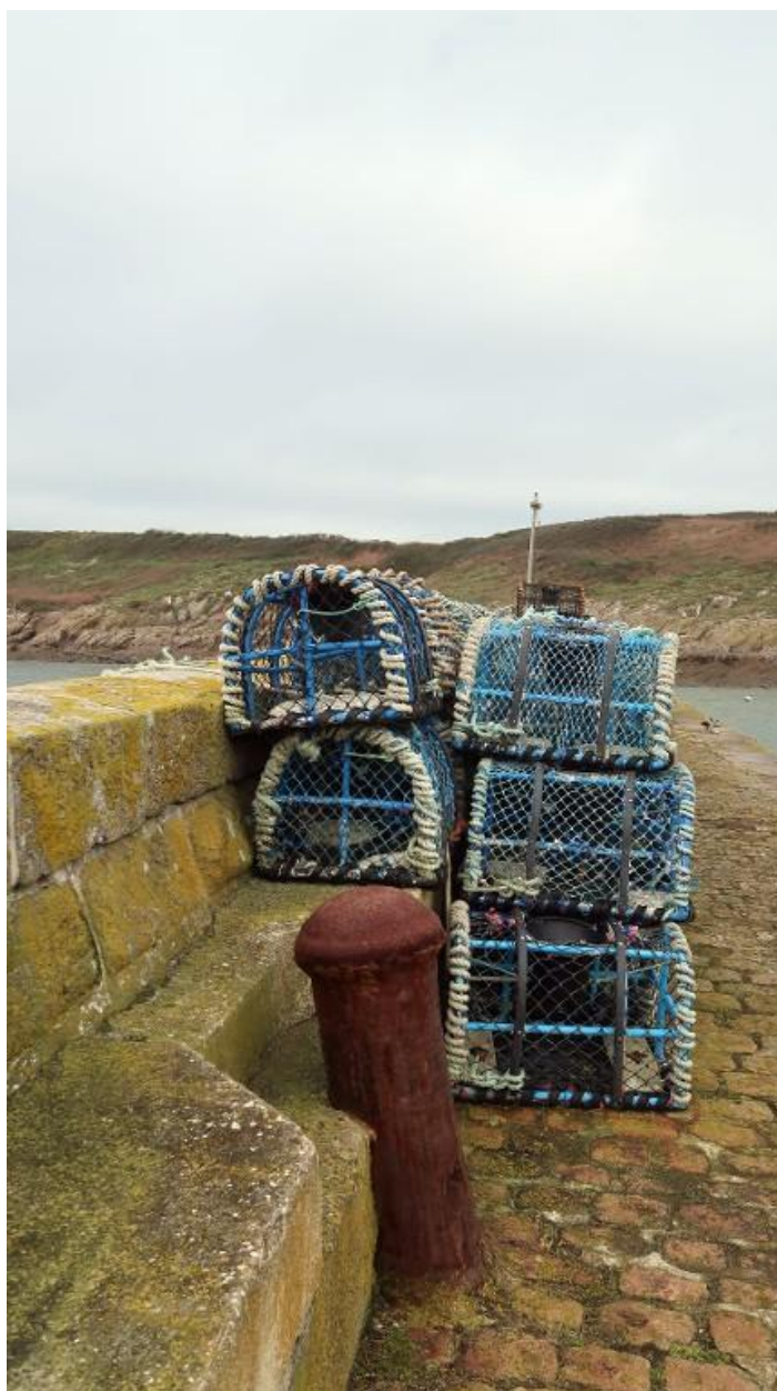
Môle Saint-Christophe : mises en oeuvre de la maçonnerie du parapet et de la plate-forme, bollard et usage de rangement des casiers
