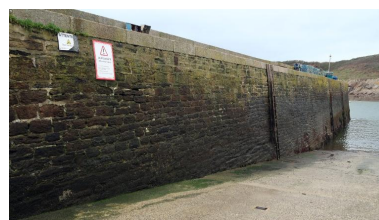
Môle Saint-Christophe : massif poids en maçonnerie (mortier de ciment et chaux), échelles Phot. Erwana L'Haridon IVR53_20242910186NUCA
