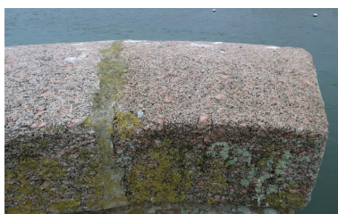
Môle Saint-Christophe : pierre de taille du parapet (provenance Aber Ildut) Phot. Erwana L'Haridon IVR53_20242910184NUCA
