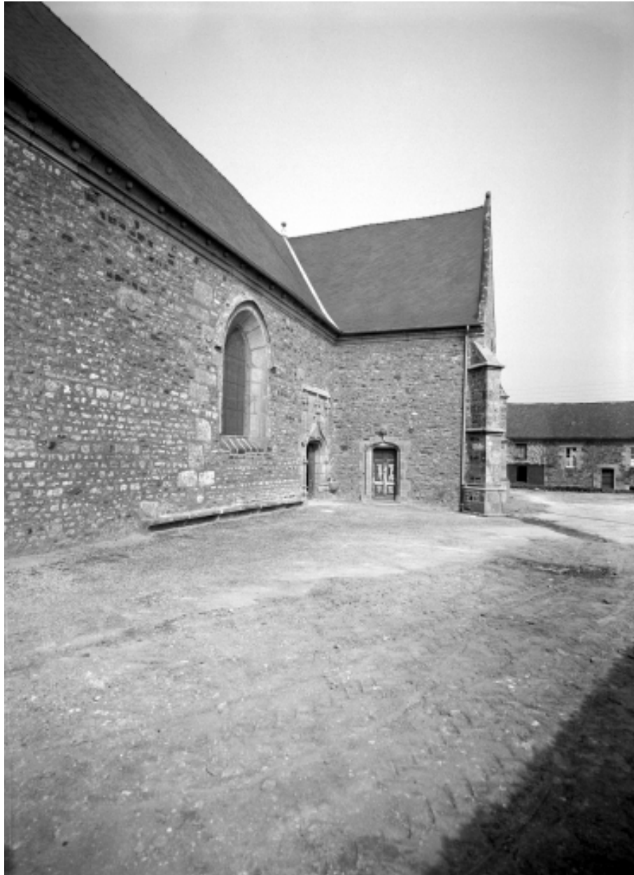
Elévation Sud, porte Ouest : vue générale
