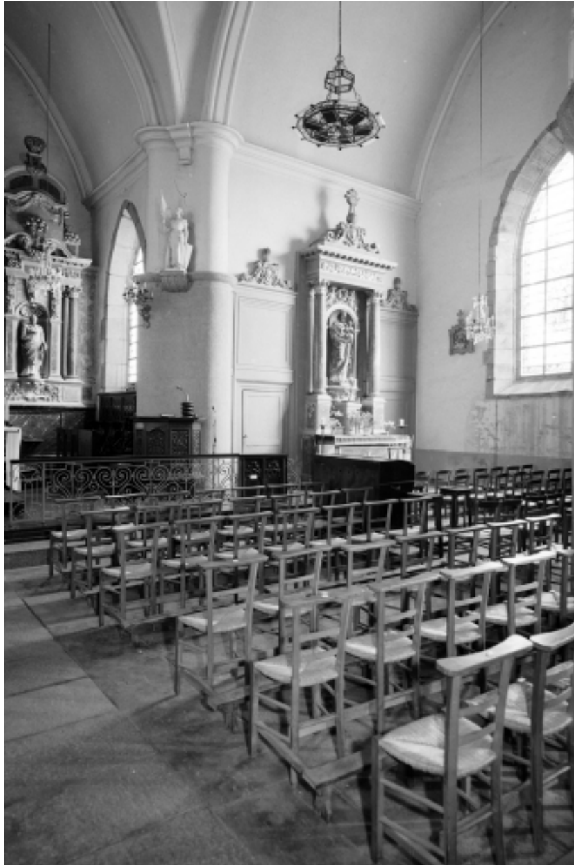
Bras sud du transept, vue générale.
