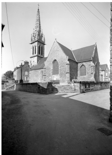
El vation Sud : vue g n rale Phot. Guy Artur, Phot. Norbert Lambart IVR53_19723500242V
