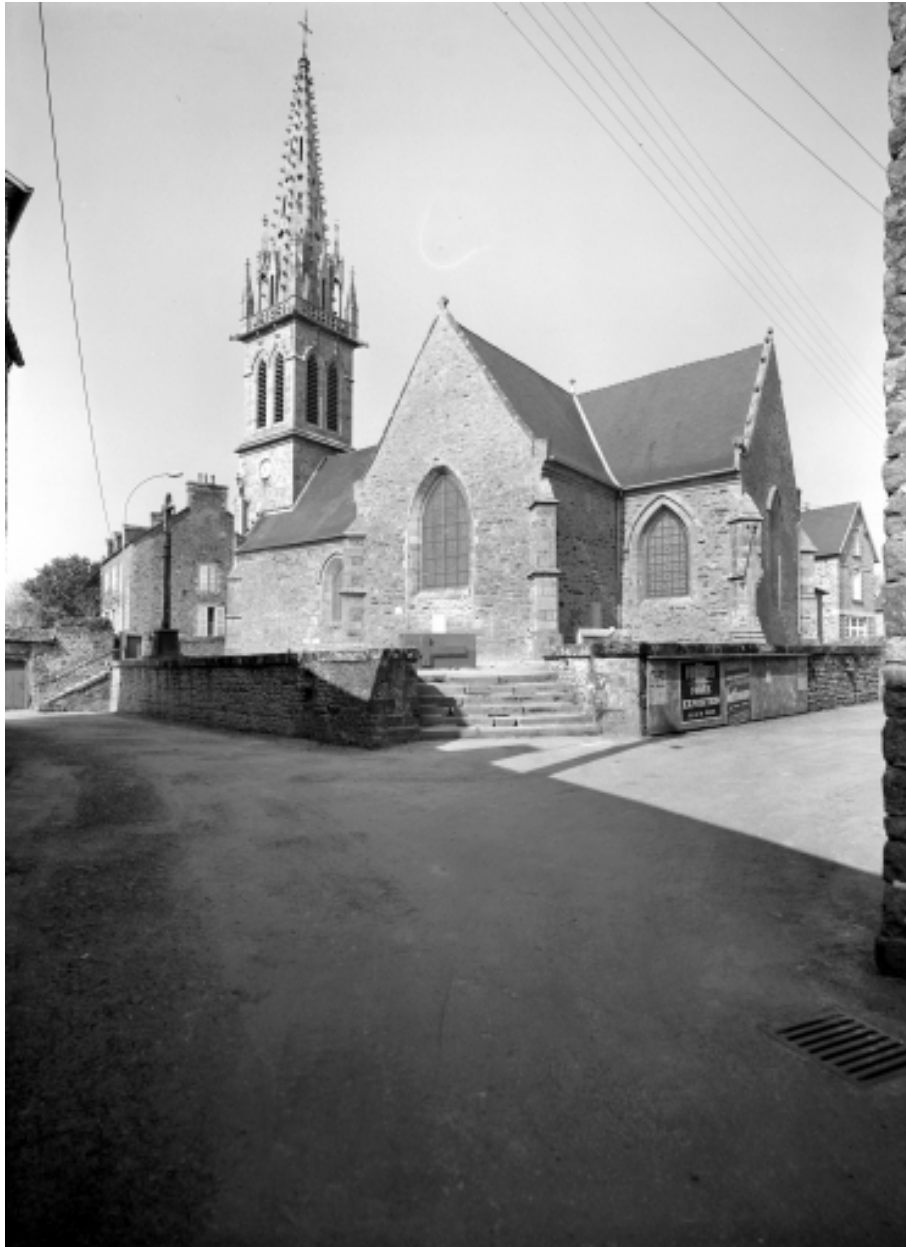
Elévation Sud : vue générale
