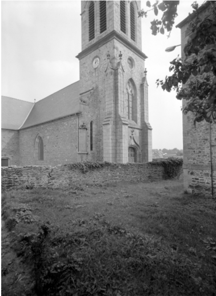
Elévation nord-ouest : vue générale
