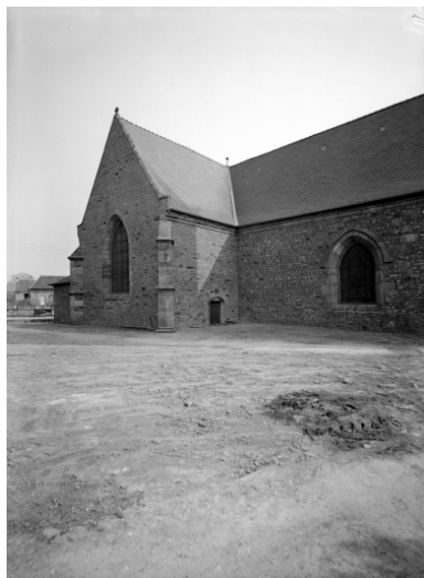
Elévation Nord, partie Est : vue générale Phot. Guy Artur, Phot. Norbert Lambart IVR53_19723500206V
