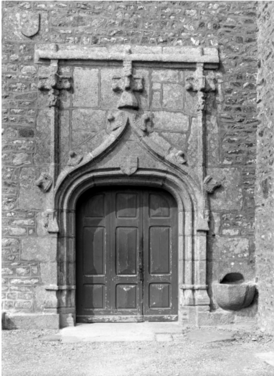
Elévation Sud, porte : vue générale
