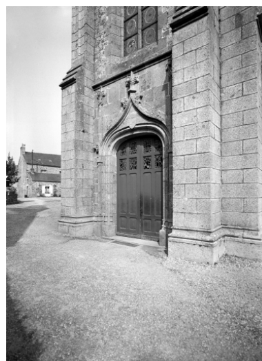
Elévation Ouest, porte : vue générale Phot. Guy Artur, Phot. Norbert Lambart IVR53_19723500208V
