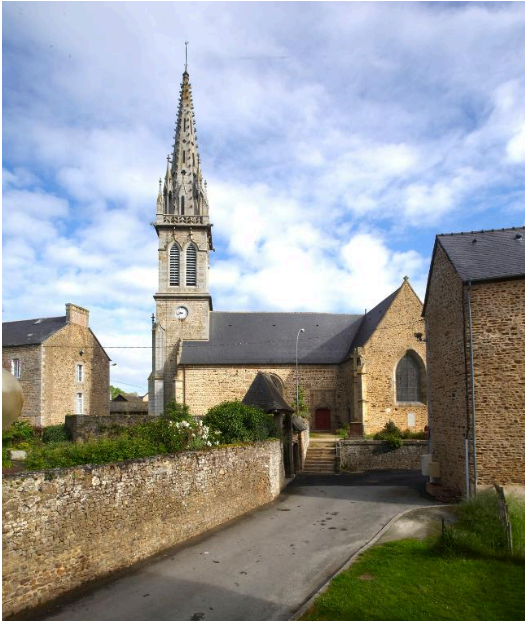
Vue générale : côté Sud-Ouest (rue du Porche)
