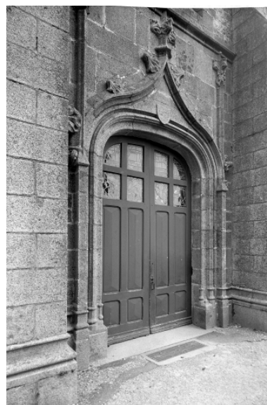
Façade ouest, porte.
