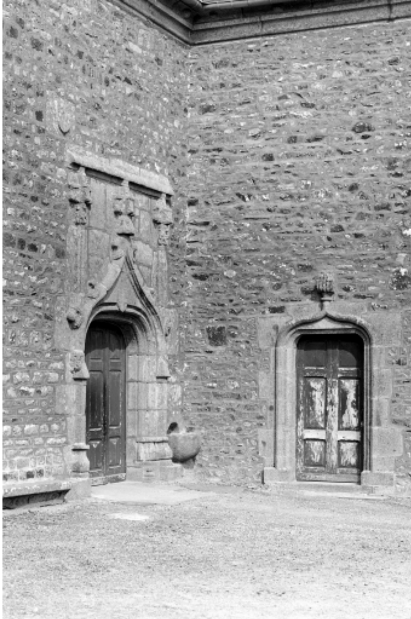
Façade sud, angle de la nef et du bras du transept.
