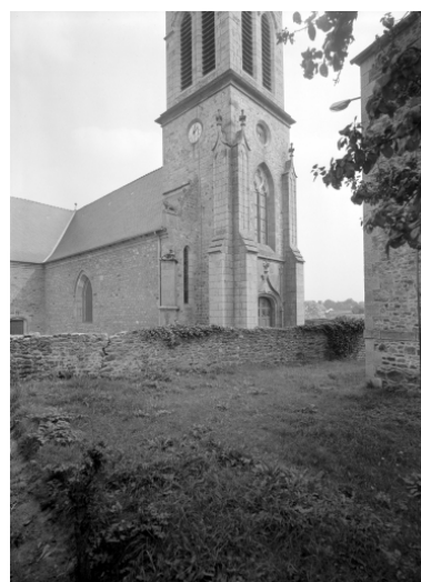
Elévation nord-ouest : vue générale
