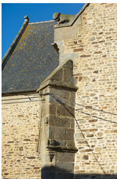
Contrefort et crossette (chevet, côté sud) Phot. Norbert Lambart IVR53_20143500266NUCA
