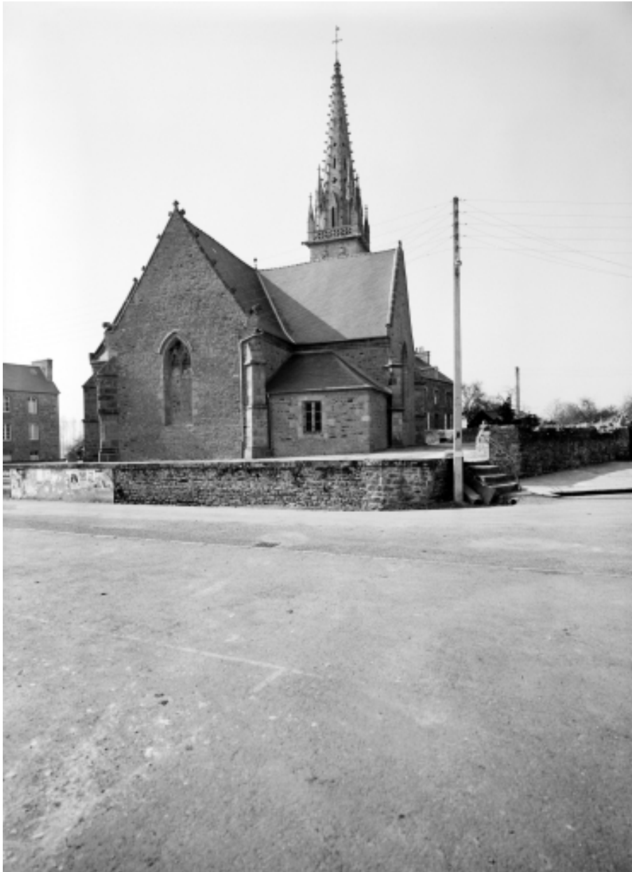
Elévation Est : vue générale
