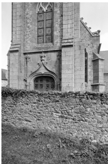
Façade ouest, vue générale.
