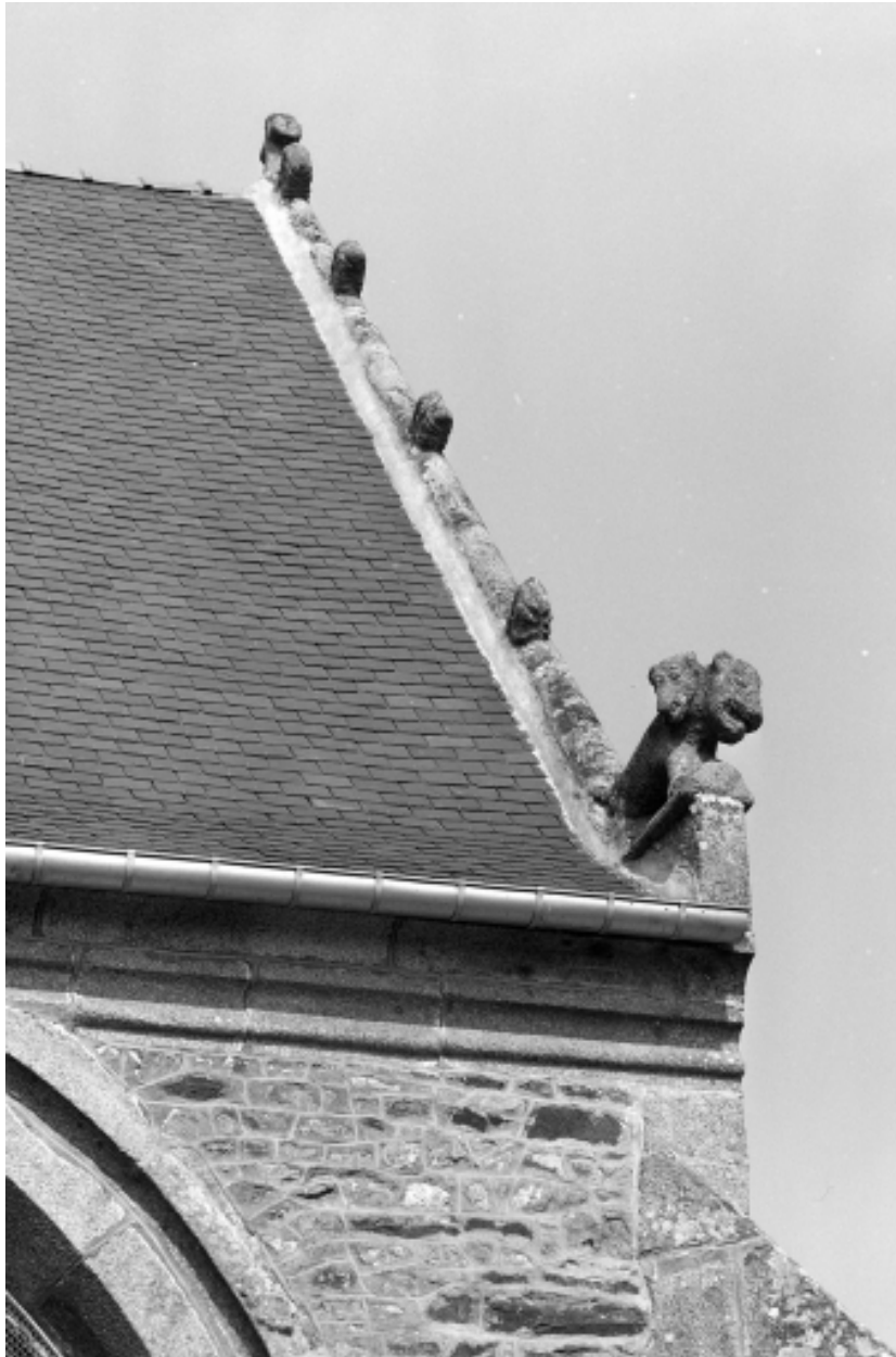
Façade est, détail crossette sud.
