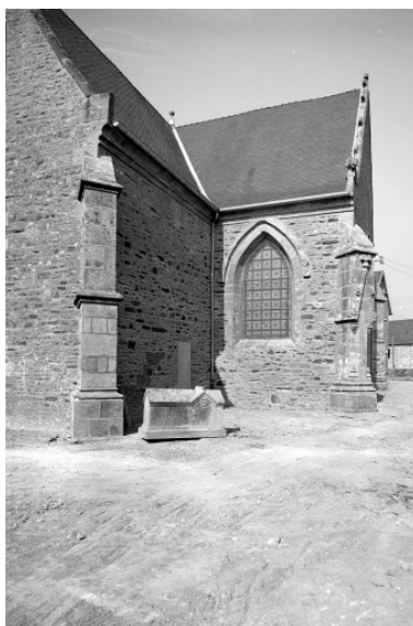
Façade sud, mur sud du choeur. Phot. Guy Artur IVR53_19723500247V
