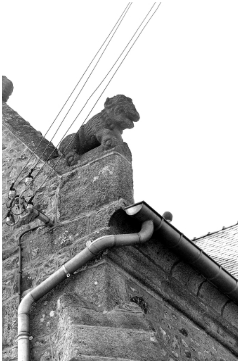
Façade est, détail crossette nord.
