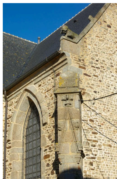
Contrefort et crossette (chevet, côté sud) Phot. Norbert Lambart IVR53_20143500267NUCA
