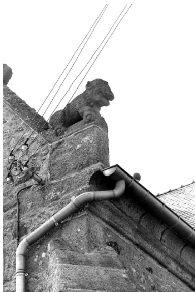
Façade est, détail crossette nord.
