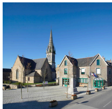
Vue générale : côté Nord- Est (mairie au premier plan) Phot. Norbert Lambart IVR53_20143500272NUCA
