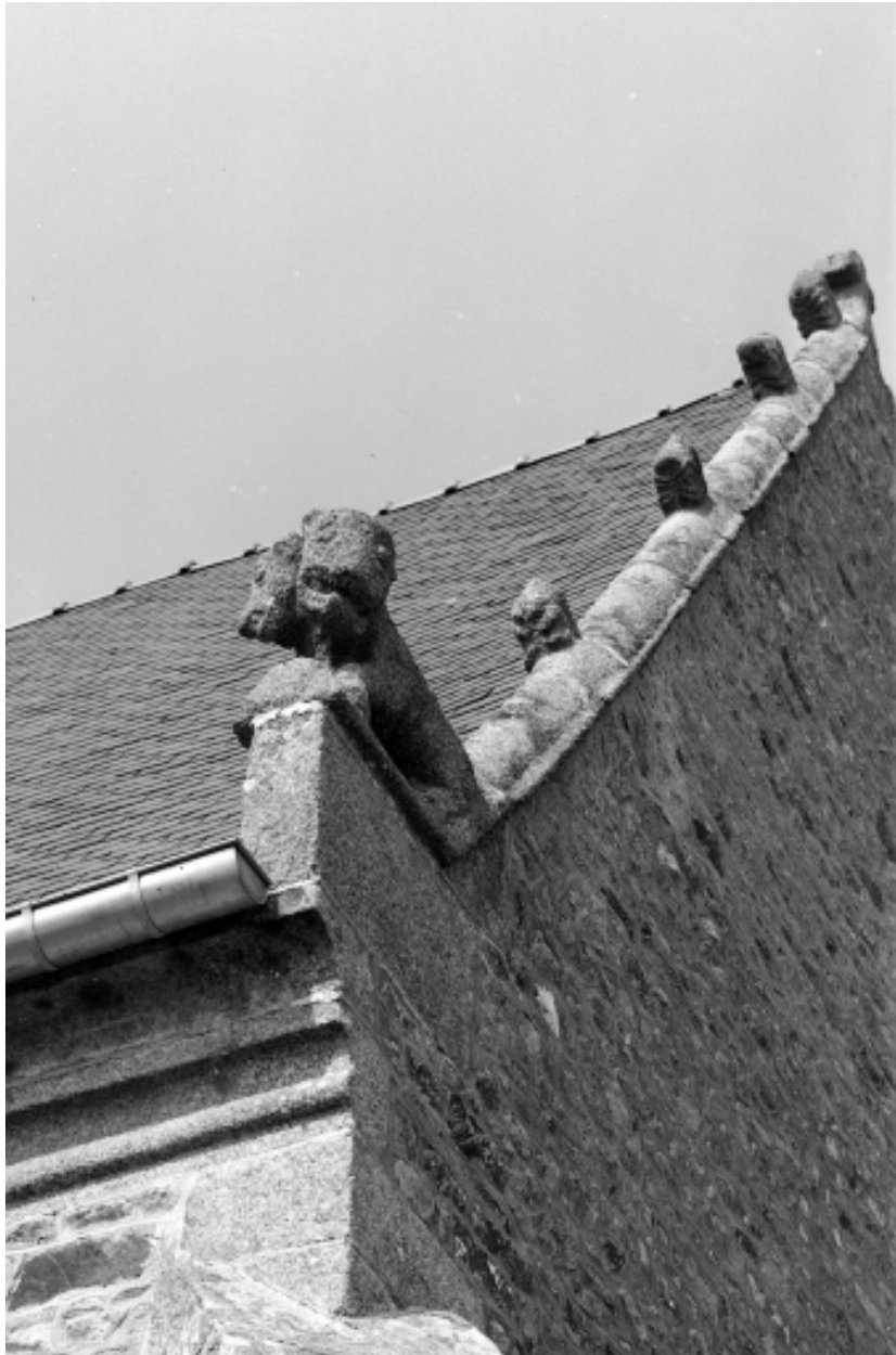
Façade est, détail crossette sud.
