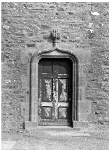
Elévation Sud, bras du transept, porte : vue générale Phot. Guy Artur, Phot. Norbert Lambart IVR53_19723500210V
