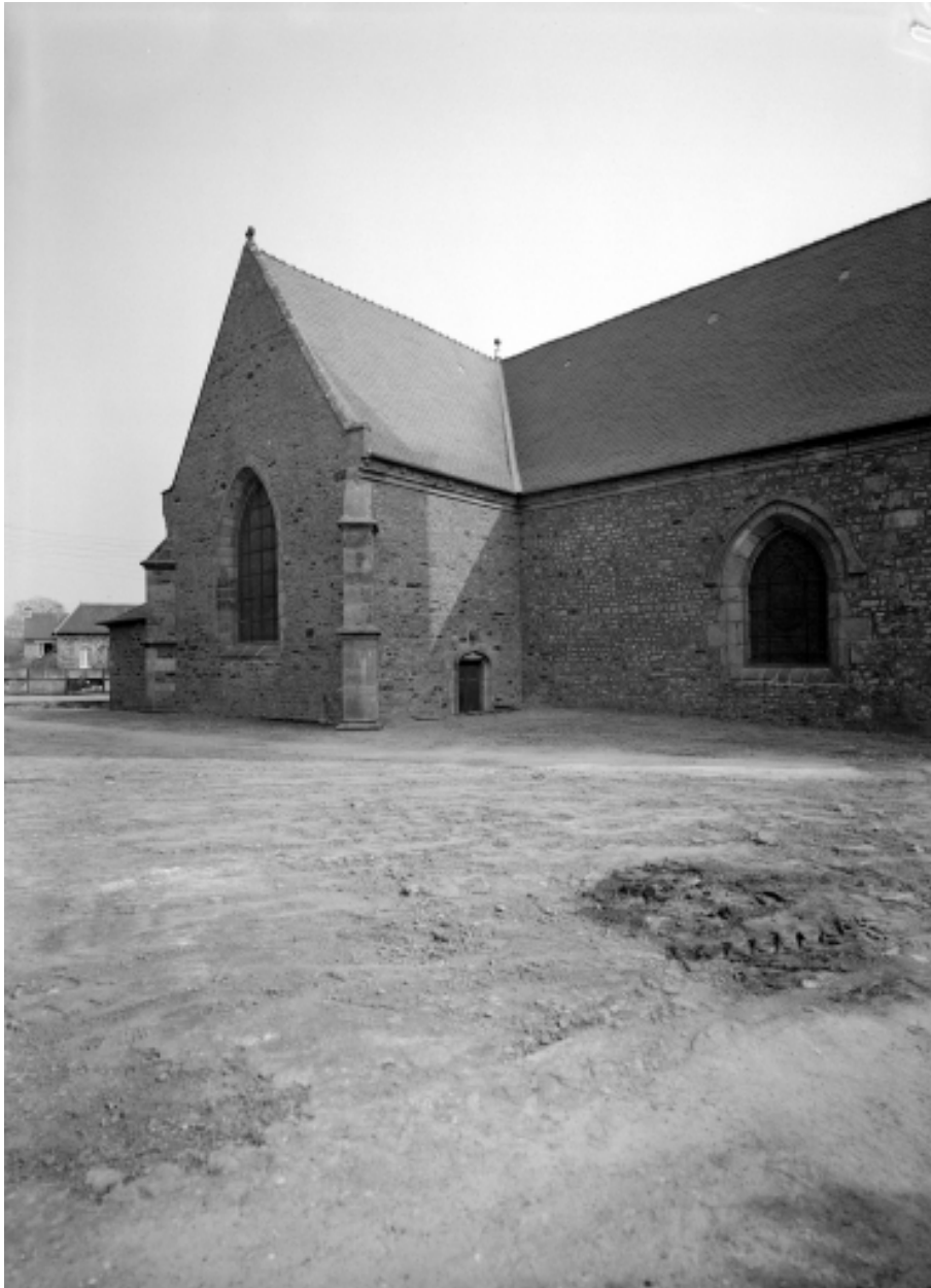
Elévation Nord, partie Est : vue générale
