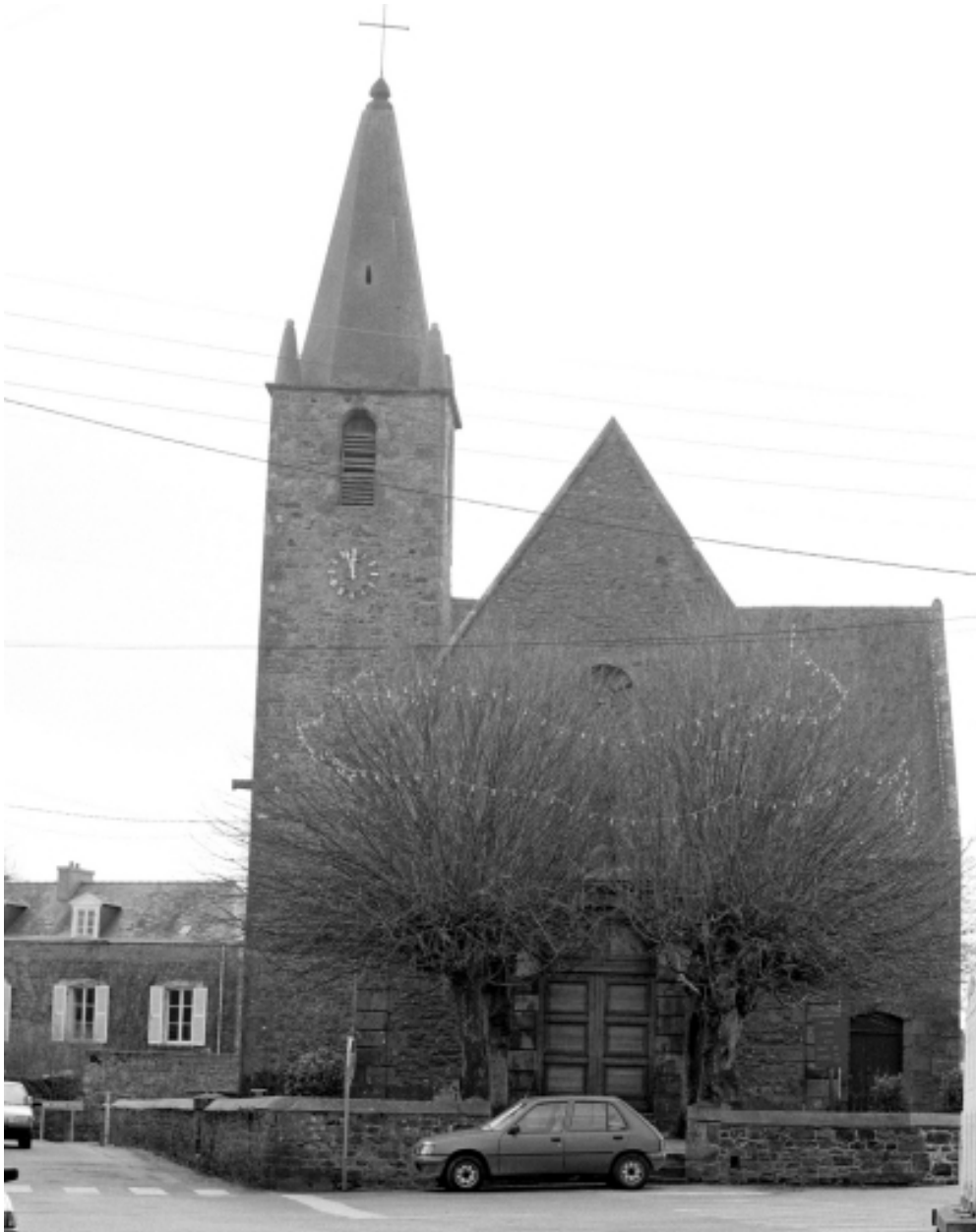
Elévation Ouest : vue générale
