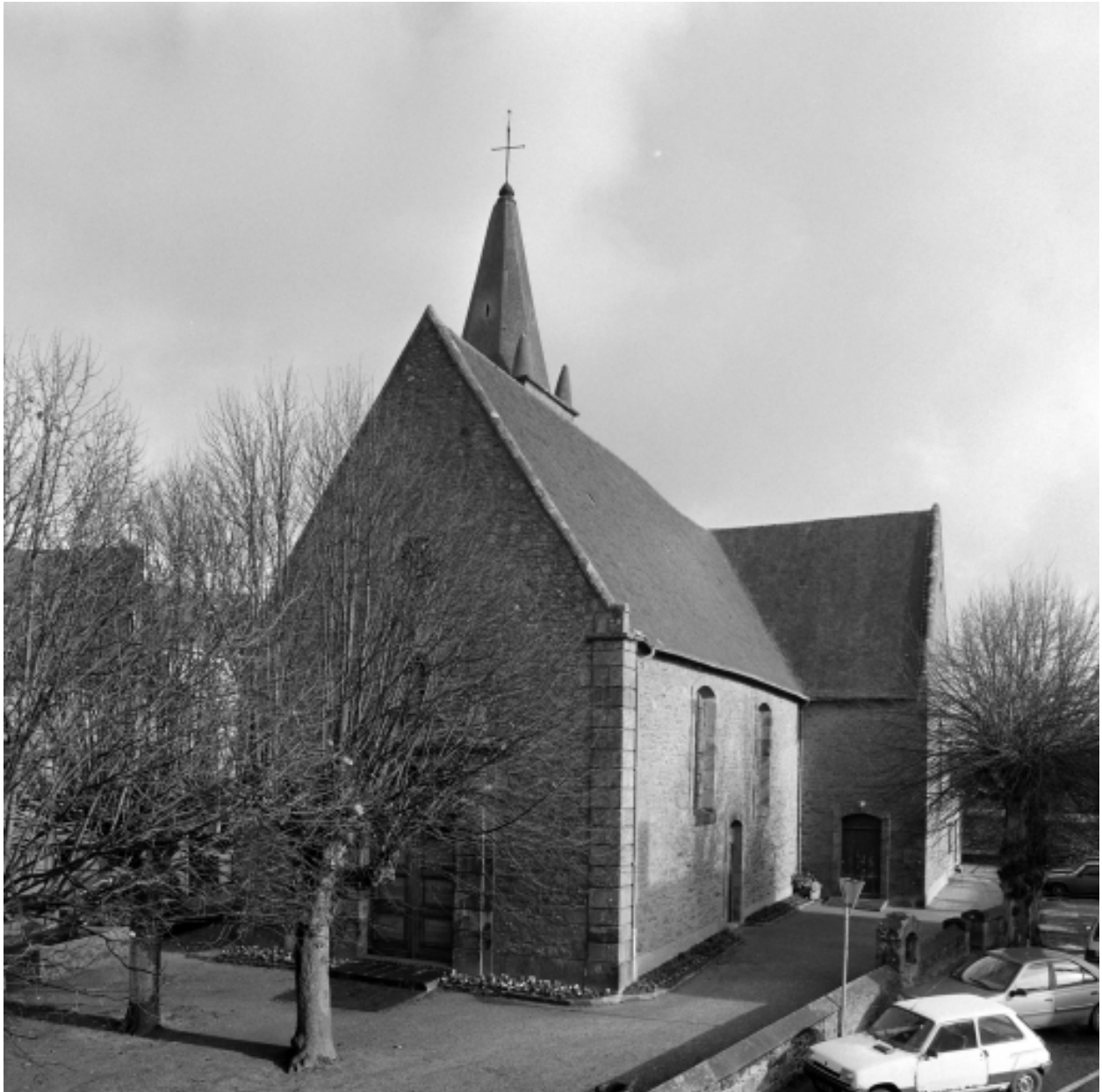
Elévation Sud-Ouest : vue générale
