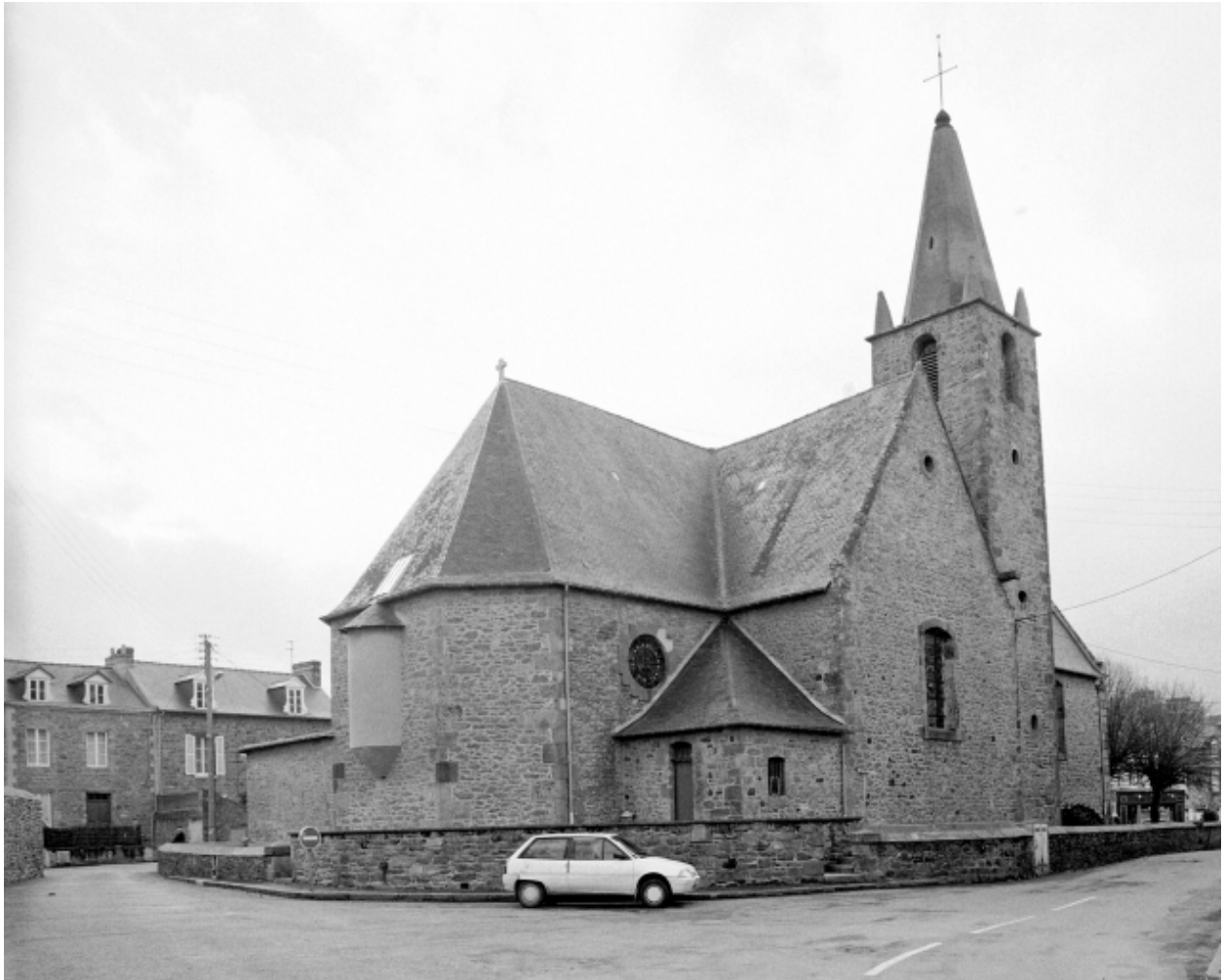
Elévation Nord-Est : vue générale
