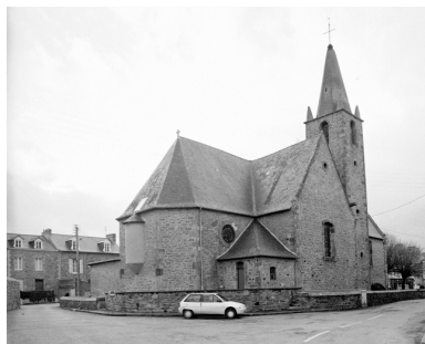
Elévation Nord-Est : vue générale Phot. Bernard Bègne, Phot. M. Loyon IVR53_19943500165X
