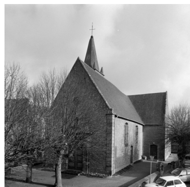
Elévation Sud-Ouest : vue générale Phot. Bernard Bègne, Phot. M. Loyon IVR53_19943502408X
