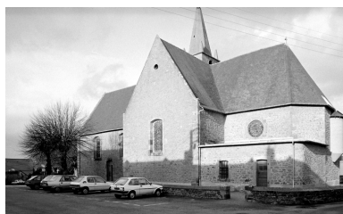
Elévation Sud : vue de situation Phot. Bernard Bègne, Phot. M. Loyon IVR53_19943500163X
