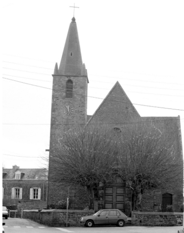
Elévation Ouest : vue générale Phot. Bernard Bègne, Phot. M. Loyon IVR53_19943500166X
