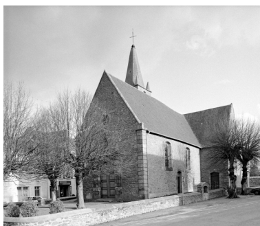
Elévation Sud-Ouest : vue générale Phot. Bernard Bègne, Phot. M. Loyon IVR53_19943500162X
