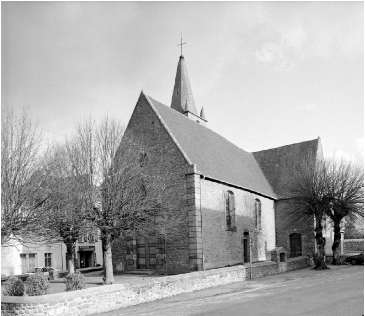
Elévation Sud-Ouest : vue générale
