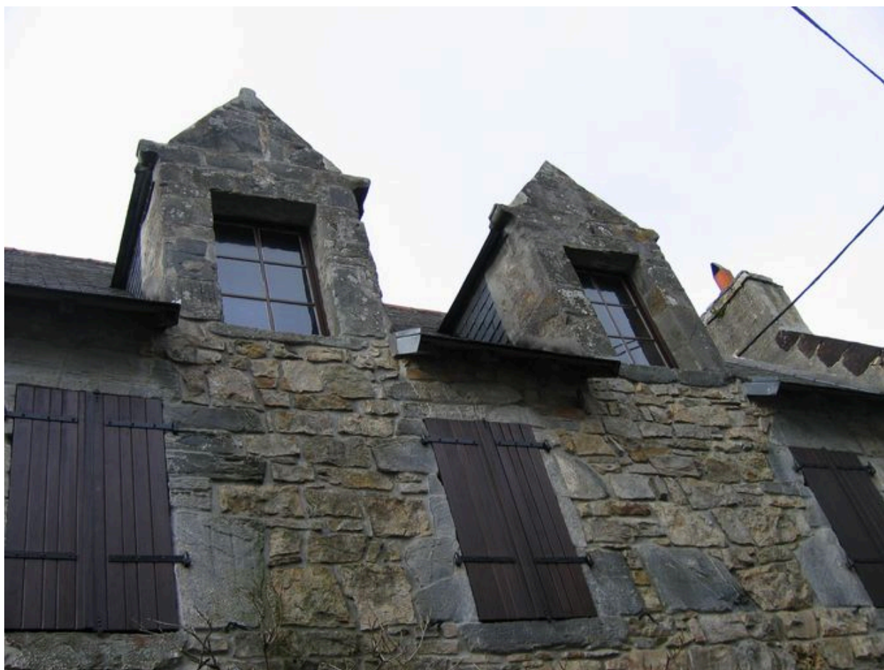
Elévation antérieure, détail de la lucarnes
