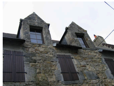
Elévation antérieure, détail de la lucarnes Phot. Françoise Péron IVR53_20062908468NUCA
