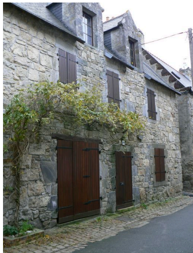
Elévation antérieure Phot. Lénaïg L'Aot IVR53_20062908489NUCA
