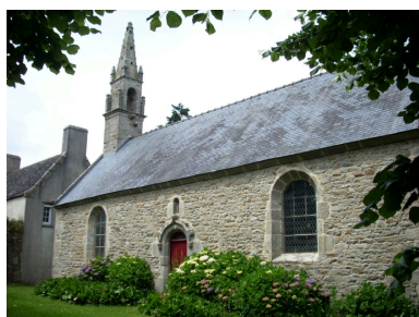
Plouguerneau, chapelle Saint-Laurent : vue générale sud Phot. Gwénaél Fauchille IVR53_20082906113NUCA
