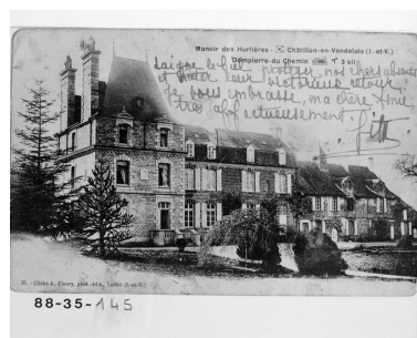
Fonds Lagrée - Carte postale ancienne - Manoir des Hurlières - Châtillon-en-Vendelais - Façade principale.
