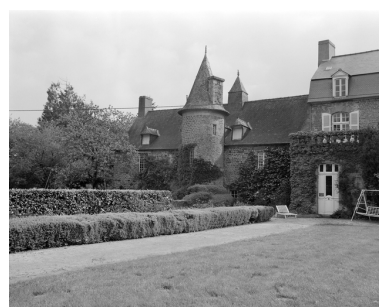
Façade postérieure : vue générale. Phot. Guy Artur, Phot. Norbert Lambart IVR53_19963501067X
