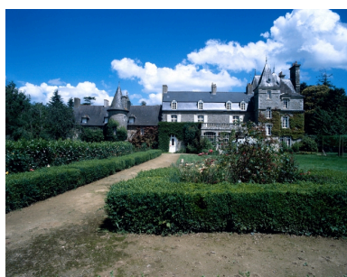
Façade postérieure : vue rapprochée. Phot. Guy Artur, Phot. Norbert Lambart IVR53_19973500804XA
