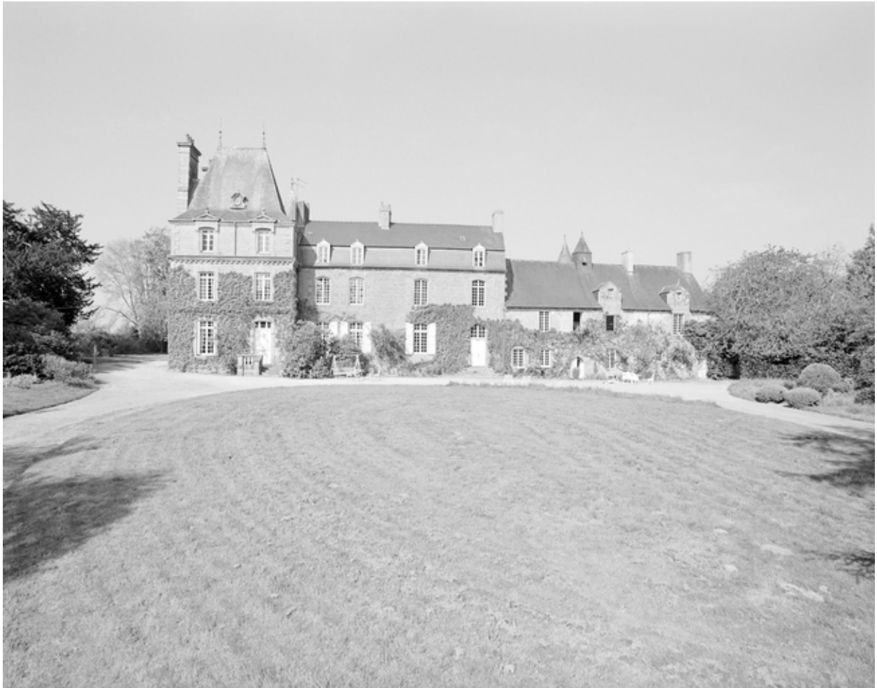
Façade principale, vue générale.
