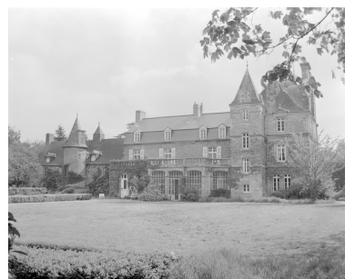
Façade postérieure : vue rapprochée.. Phot. Guy Artur, Phot. Norbert Lambart IVR53_19963501068X
