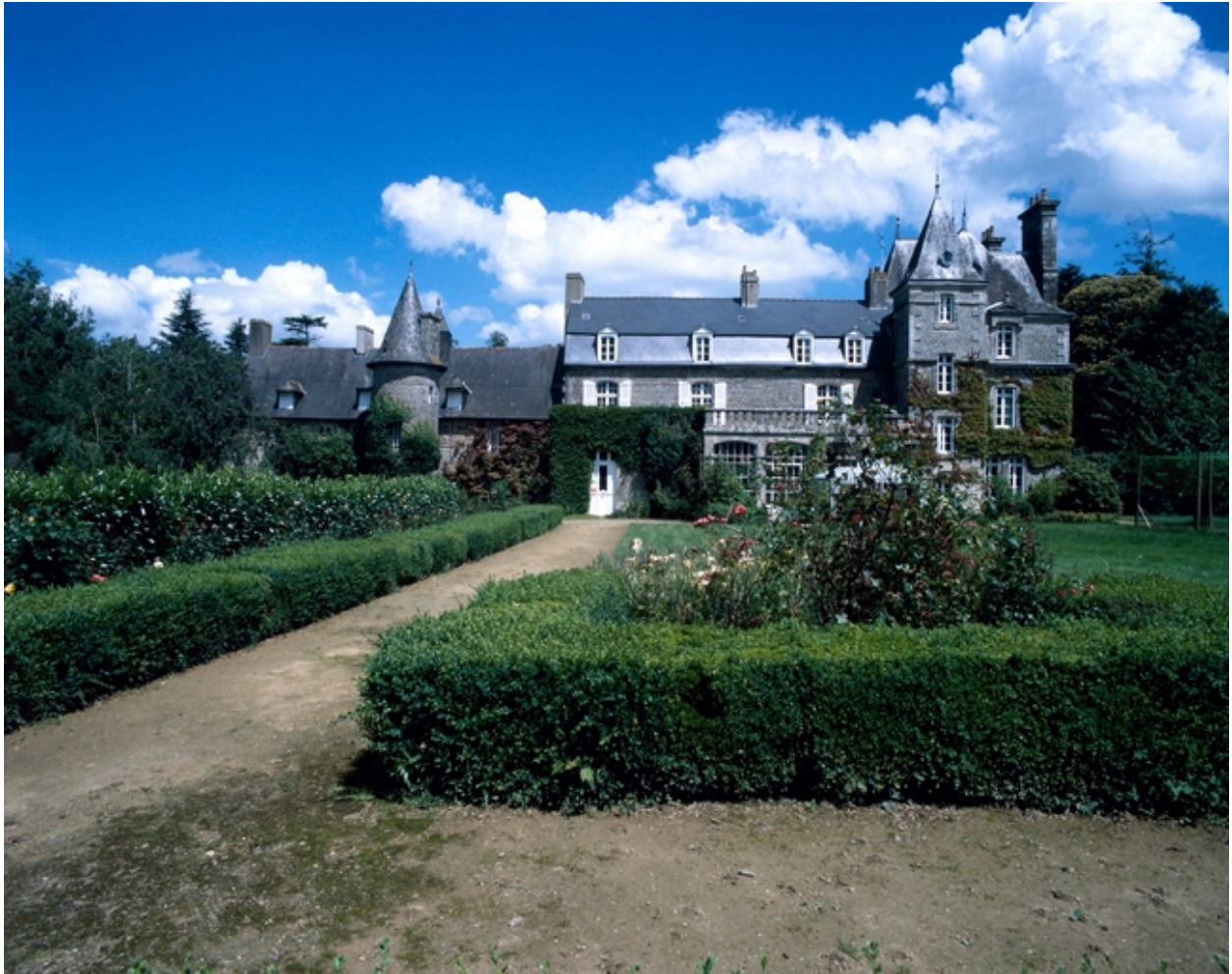
Façade postérieure : vue rapprochée.
