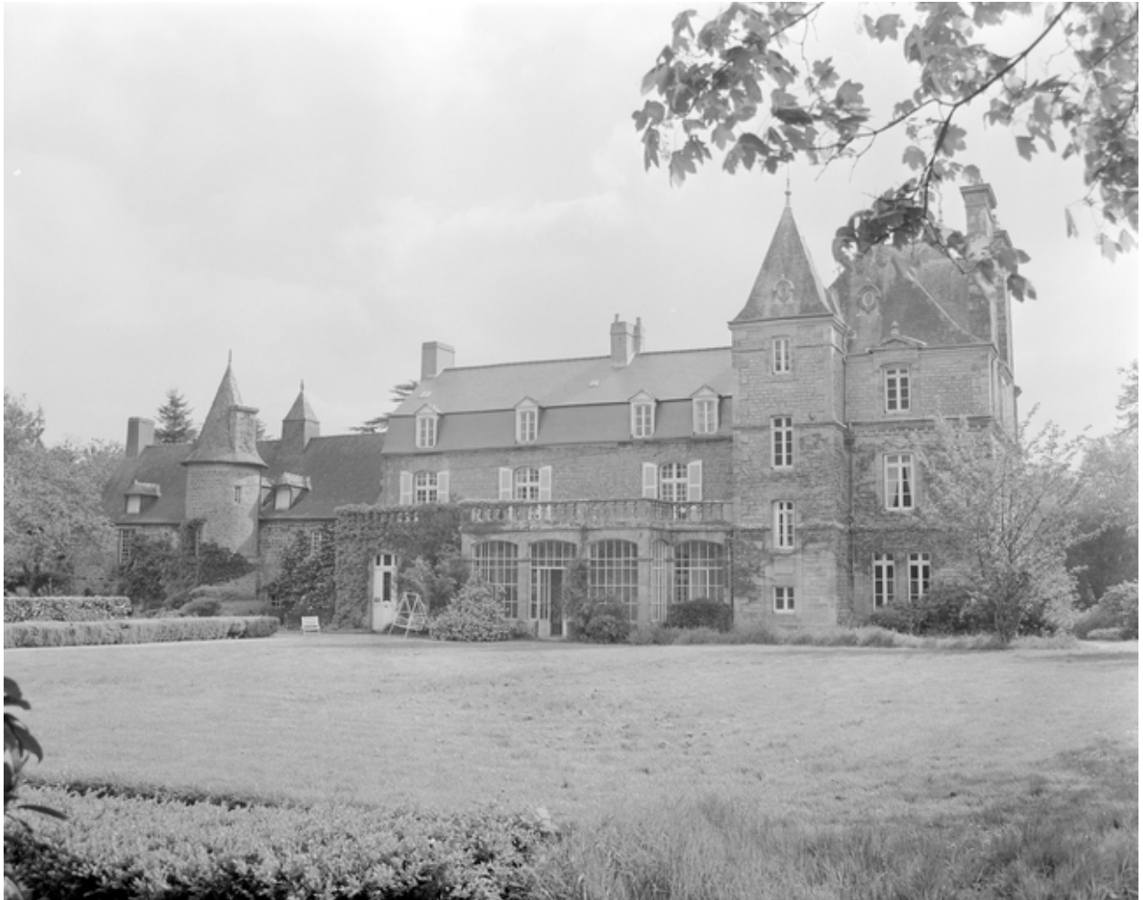
Façade postérieure : vue rapprochée..
