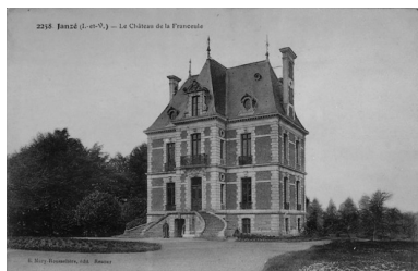
Vue générale Phot. Auteur inconnu IVR53_19883500315XB
