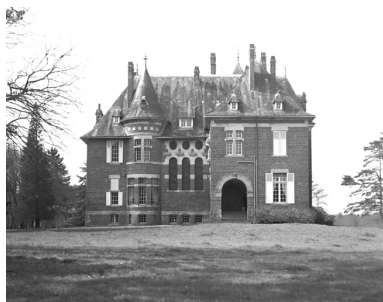
Vue générale est
