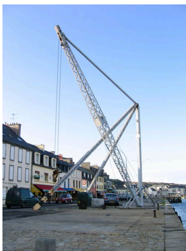
Grue à mâter du front portuaire toudouze
