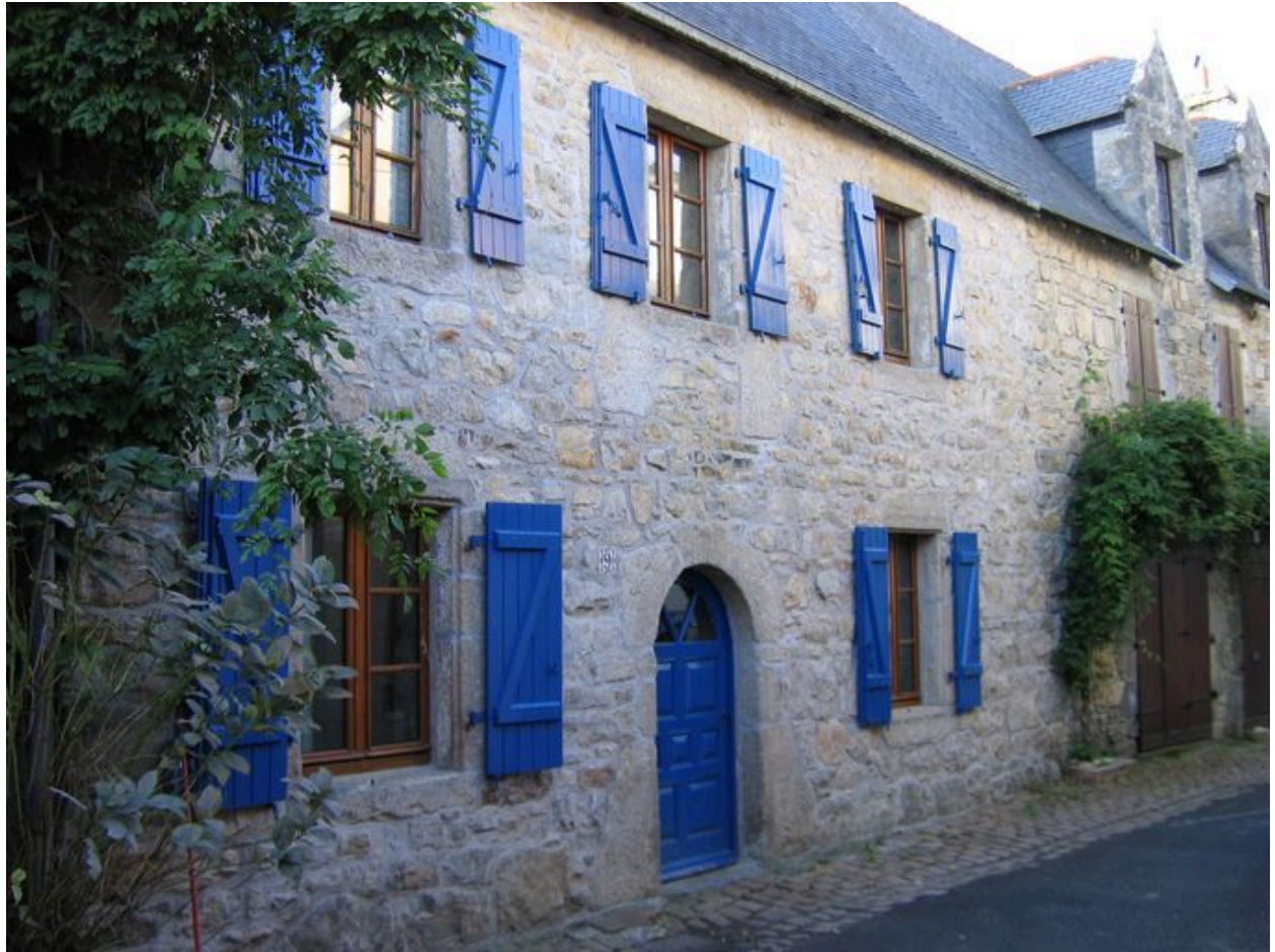
Maison du 9 rue de Dixmude
