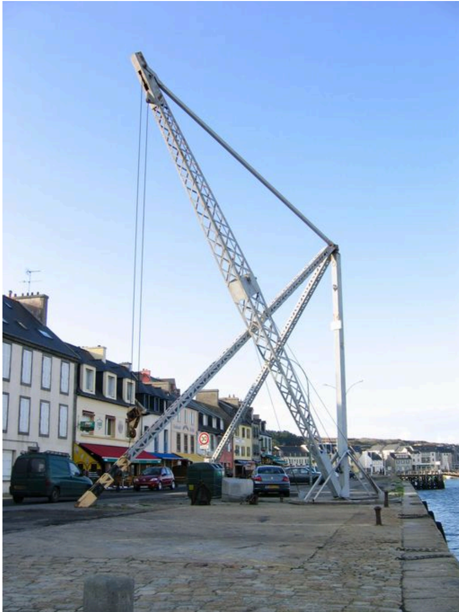
Grue à mâter du front portuaire toudouze
