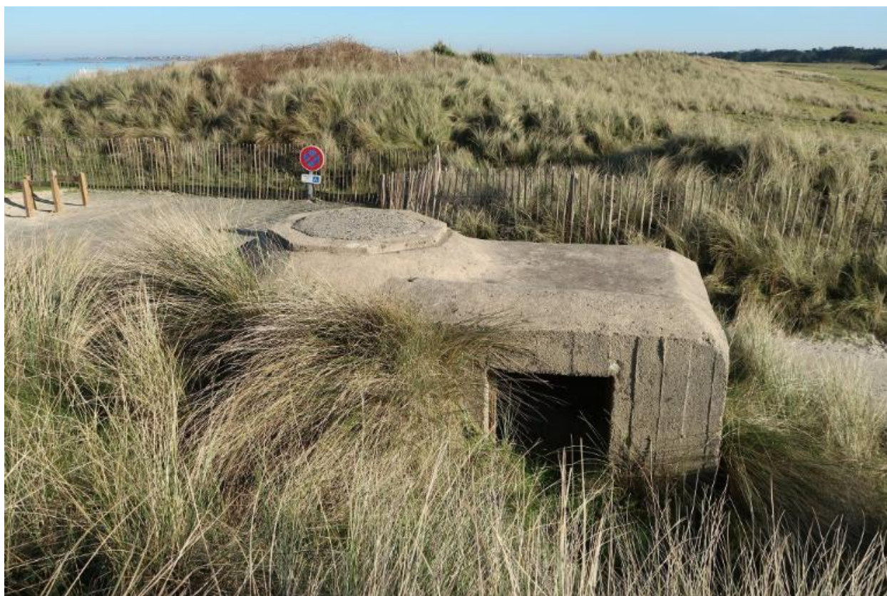
Vue générale depuis l'ouest. De ce côté se trouve l'entrée du bunker
