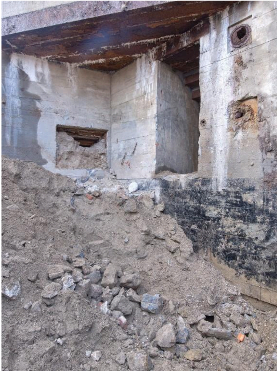
Vue de détail de l'élévation est : entrée sud flanquée par la caponnière (couverture photographique du 22 janvier 2026). L'ouverture de tir blindée de la caponnière est masquée par le remblai
