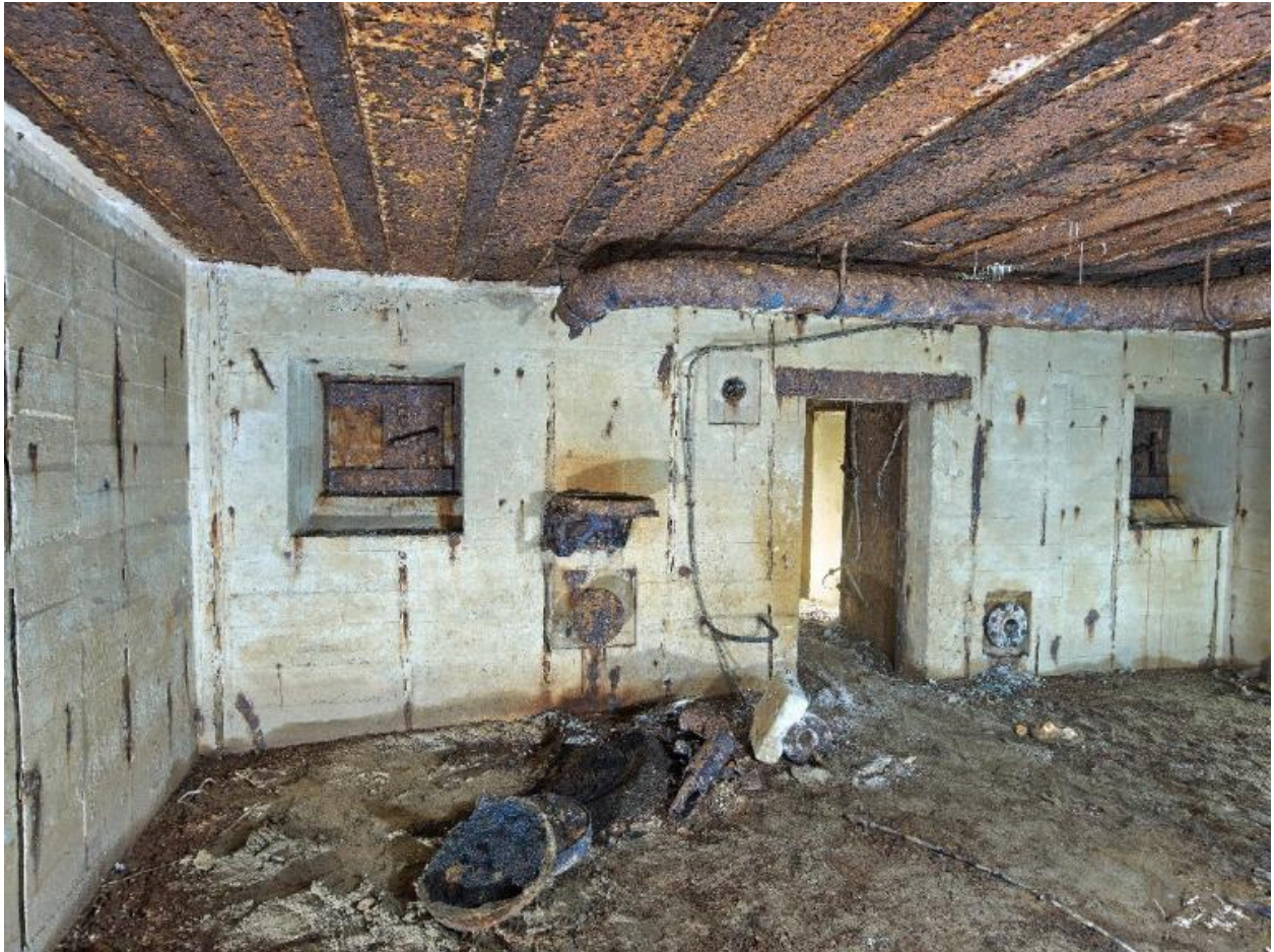
Vue de la salle de garde. De part et d'autre de la pièce, les ouvertures de tir blindées ; au centre, la porte étanche d'accès, à gauche de la porte l'emplacement du système de ventilation ; à droite de la porte, bouche de surpression à clapet
