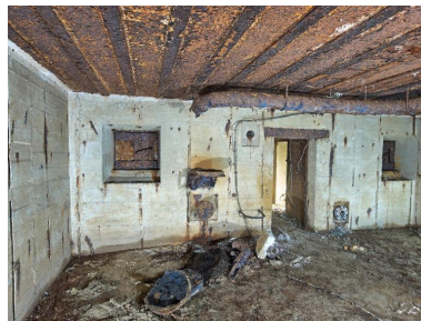
Vue de la salle de garde. De part et d'autre de la pièce, les ouvertures de tir blindées ; au centre, la porte étanche d'accès, à gauche de la porte l'emplacement du système de ventilation ; à droite de la porte, bouche de surpression à clapet Phot. Bernard Bègne IVR53_20253501382NUCA
