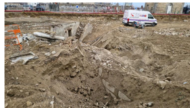
Vue de situation depuis le sud-est (couverture photographique du 17 décembre 2025). Au premier plan au centre, partiellement remblayés, les vestiges du quai de l'avant-port de Saint-Servan : il est construit en maçonnerie de pierre de taille de granite Phot. Guillaume Lécueillier IVR53_20263510059NUCA
