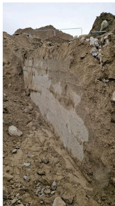
Vue des vestiges du quai de l'avant-port de Saint-Servan vers le sud-est (couverture photographique du 17 décembre 2025). Le quai est construit en maçonnerie de pierre de taille de granite Phot. Guillaume Lécueillier IVR53_20263510061NUCA
