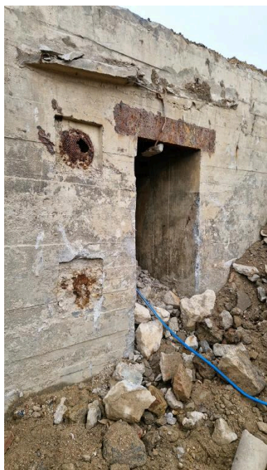
Vue de détail de l'entrée nord (couverture photographique du 17 décembre 2025). Cette entrée était également défendue par la caponnière implantée au sud Phot. Guillaume Lécueillier IVR53_20263510062NUCA
