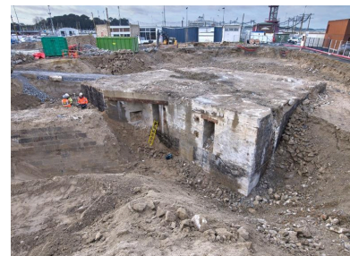
Vue générale depuis le nord-est (couverture photographique du 22 janvier 2026). A gauche, les vestiges du quai de l'avant-port de Saint-Servan Phot. Bernard Bègne IVR53_20263500071NUCA
