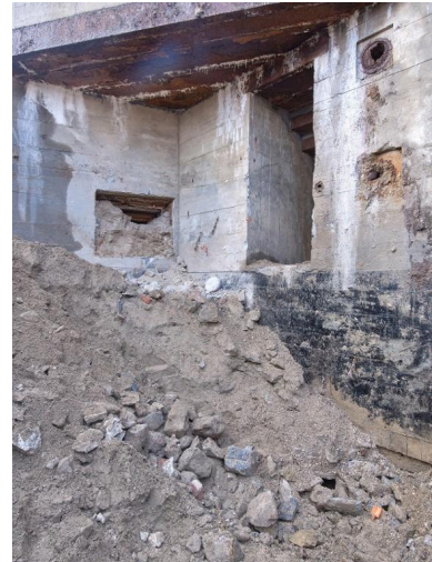
Vue de détail de l'élévation est : entrée sud flanquée par la caponnière (couverture photographique du 22 janvier 2026). L'ouverture de tir blindée de la caponnière est masquée par le remblai
