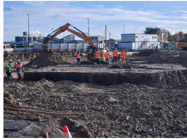
Vue générale depuis le nord-ouest : dalle de couverture (couverture photographique du 22 janvier 2026)
