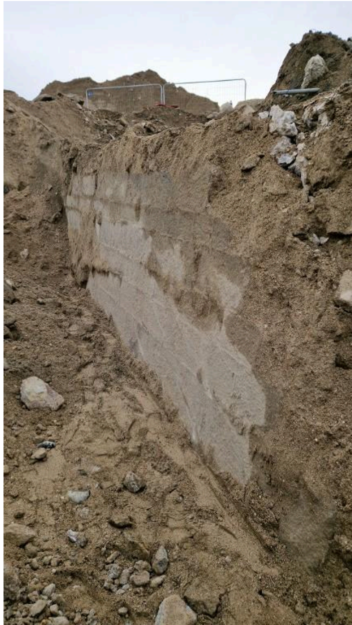
Vue des vestiges du quai de l'avant-port de Saint-Servan vers le sud-est (couverture photographique du 17 décembre 2025). Le quai est construit en maçonnerie de pierre de taille de granite
