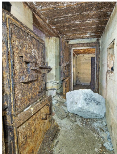
Vue du débouché du couloir de l'entrée sud : il est encombré de gravas. Au premier plan à gauche, porte blindée à deux vantaux du sas de la salle de garde. Au fond, la porte blindée du sas de la caponnière et du magasin à munitions Phot. Bernard Bègne IVR53_20253501390NUCA
