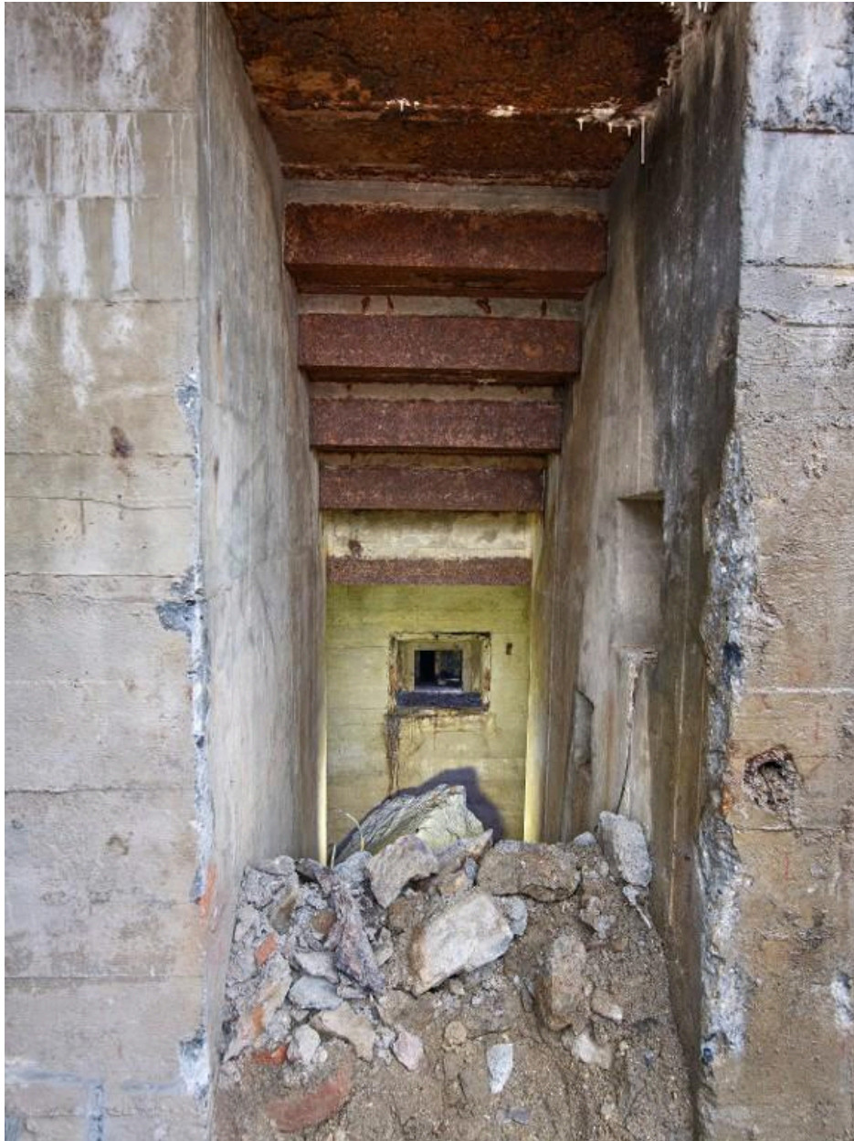
Vue de l'entrée sud : l'escalier d'accès est partiellement remblayé. Au fond, l'ouverture de tir blindée (coffrage en bois est en place)
