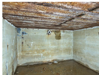
Vue du magasin à munitions situé au sud. Sur le mur du fond : bouche de ventilation Phot. Bernard Bègne IVR53_20253501375NUCA
