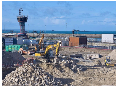
Vue de situation depuis le sud-est (couverture photographique du 22 janvier 2026). En arrière-plan, la vigie de la capitainerie du port de Saint-Malo (à gauche) et le transformateur électrique (au centre) Phot. Bernard Bègne IVR53_20263500093NUCA
