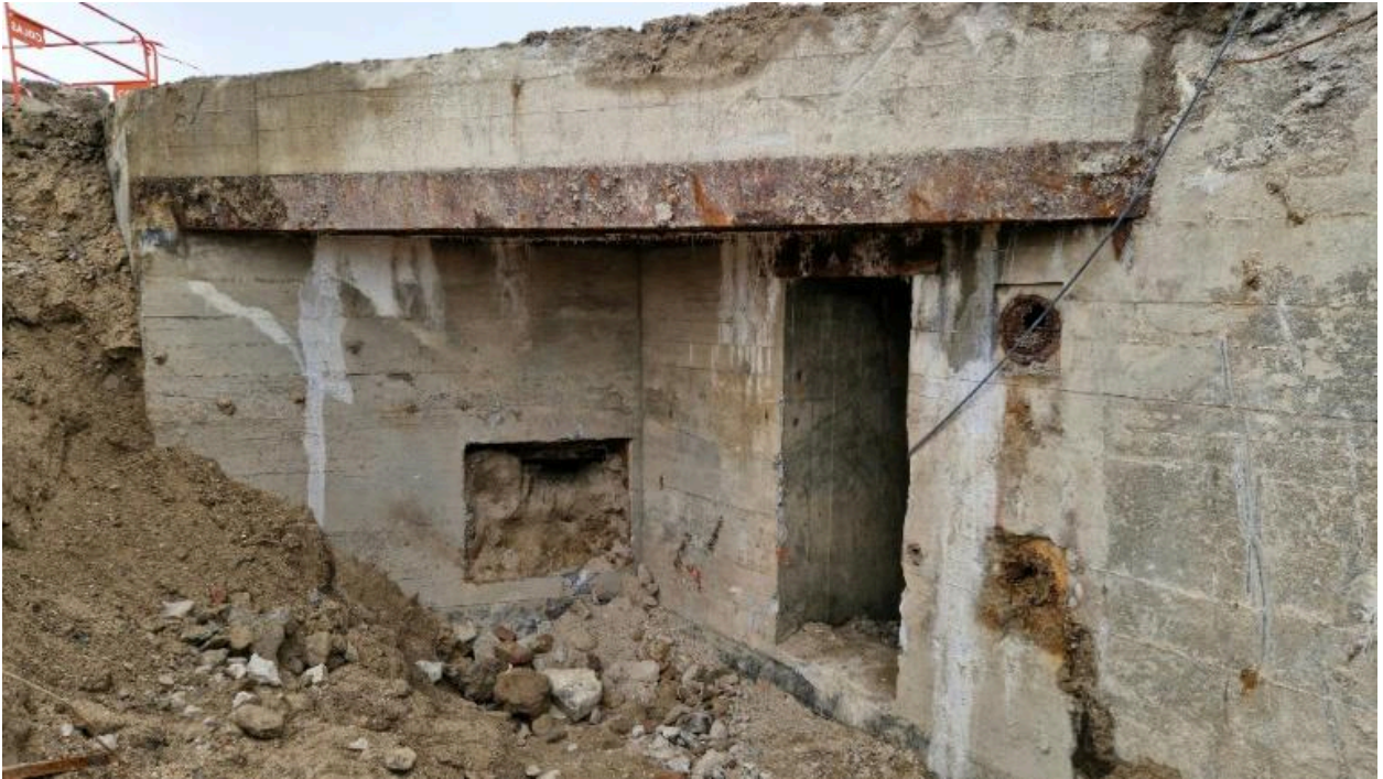
Vue de détail de l'élévation est : entrée sud flanquée par la caponnière (couverture photographique du 17 décembre 2025). L'ouverture de tir blindée de la caponnière est masquée par le remblai
