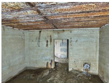
Vue du magasin à munitions situé au sud. Sur le mur du fond : câblage électrique pour l'alimentation des plafonniers et à droite, bouche de surpression à clapet à contrepoids Phot. Bernard Bègne IVR53_20253501374NUCA
