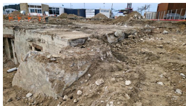
Vue de l'escalier tournant construit contre l'angle nord-est (couverture photographique du 17 décembre 2025). Cet escalier permettait à l'origine de desservir la cuve pour canon antiaérien (la cuve a été arasée avant 1961) Phot. Guillaume Lécueillier IVR53_20263510057NUCA
