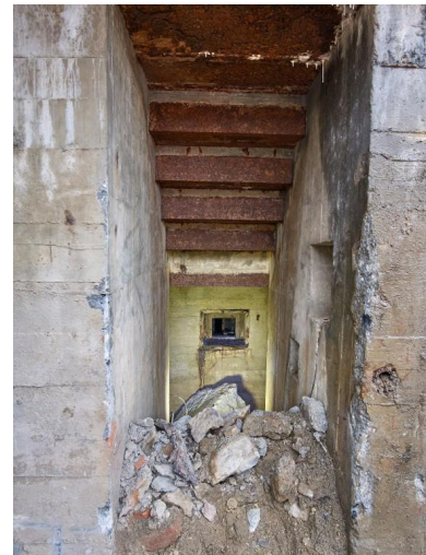
Vue de l'entrée sud : l'escalier d'accès est partiellement remblayé. Au fond, l'ouverture de tir blindée (coffrage en bois est en place) Phot. Bernard Bègne IVR53_20253501373NUCA
