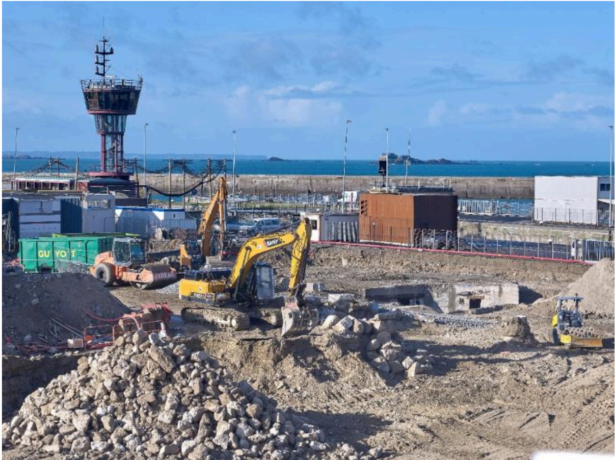
Vue de situation depuis le sud-est (couverture photographique du 22 janvier 2026). En arrière-plan, la vigie de la capitainerie du port de Saint-Malo (à gauche) et le transformateur électrique (au centre)
