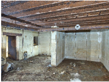
Vue de la salle de garde : elle est partiellement divisée par un mur de refend. A gauche, porte étanche d'accès et bouche de surpression à clapet. Au plafond, tuyauterie du système de ventilation Phot. Bernard Bègne IVR53_20253501383NUCA
