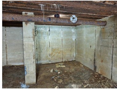
Vue de détail de la salle de garde : elle est partiellement divisée par un mur de refend. Au plafond, tuyauterie du système de ventilation Phot. Bernard Bègne IVR53_20253501387NUCA
