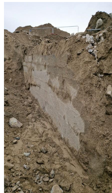
Vue des vestiges du quai de l'avant-port de Saint-Servan vers le sud-est (couverture photographique du 17 décembre 2025). Le quai est construit en maçonnerie de pierre de taille de granite Phot. Guillaume Lécueillier IVR53_20263510061NUCA
