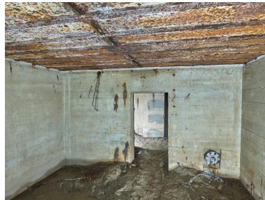
Vue du magasin à munitions situé au sud. Sur le mur du fond : câblage électrique pour l'alimentation des plafonniers et à droite, bouche de surpression à clapet à contrepoids Phot. Bernard Bègne IVR53_20253501374NUCA
