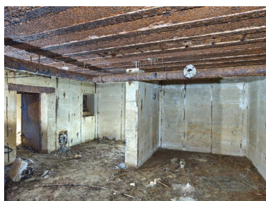
Vue de la salle de garde : elle est partiellement divisée par un mur de refend. A gauche, porte étanche d'accès et bouche de surpression à clapet. Au plafond, tuyauterie du système de ventilation
