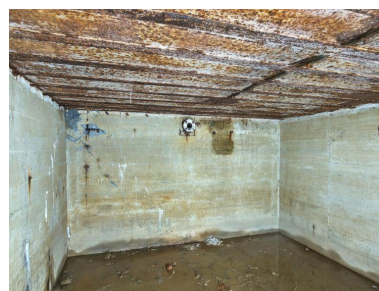
Vue du magasin à munitions situé au sud. Sur le mur du fond : bouche de ventilation
