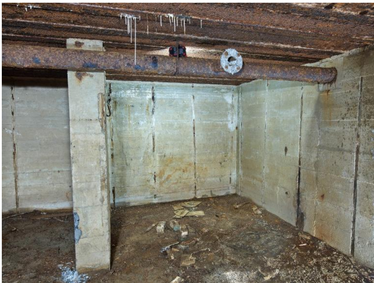
Vue de détail de la salle de garde : elle est partiellement divisée par un mur de refend. Au plafond, tuyauterie du système de ventilation
