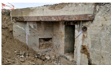
Vue de détail de l'élévation est : entrée sud flanquée par la caponnière (couverture photographique du 17 décembre 2025). L'ouverture de tir blindée de la caponnière est masquée par le remblai Phot. Guillaume Lécueillier IVR53_20263510063NUCA
