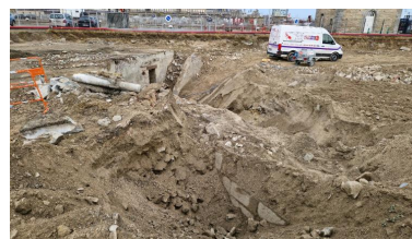
Vue de situation depuis le sud-est (couverture photographique du 17 décembre 2025). Au premier plan au centre, partiellement remblayés, les vestiges de la digue de l'avant-port de Saint-Servan : il est construit en maçonnerie de pierre de taille de granite Phot. Guillaume Lécullier IVR53_20263510059NUCA
