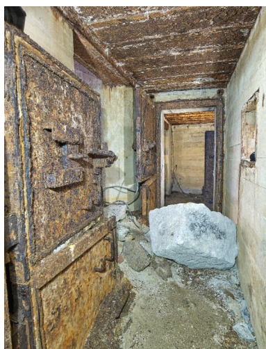
Vue du débouché du couloir de l'entrée sud : il est encombré de gravas. Au premier plan à gauche, porte blindée à deux vantaux du sas de la salle de garde. Au fond, la porte blindée du sas de la caponnière et du magasin à munitions
