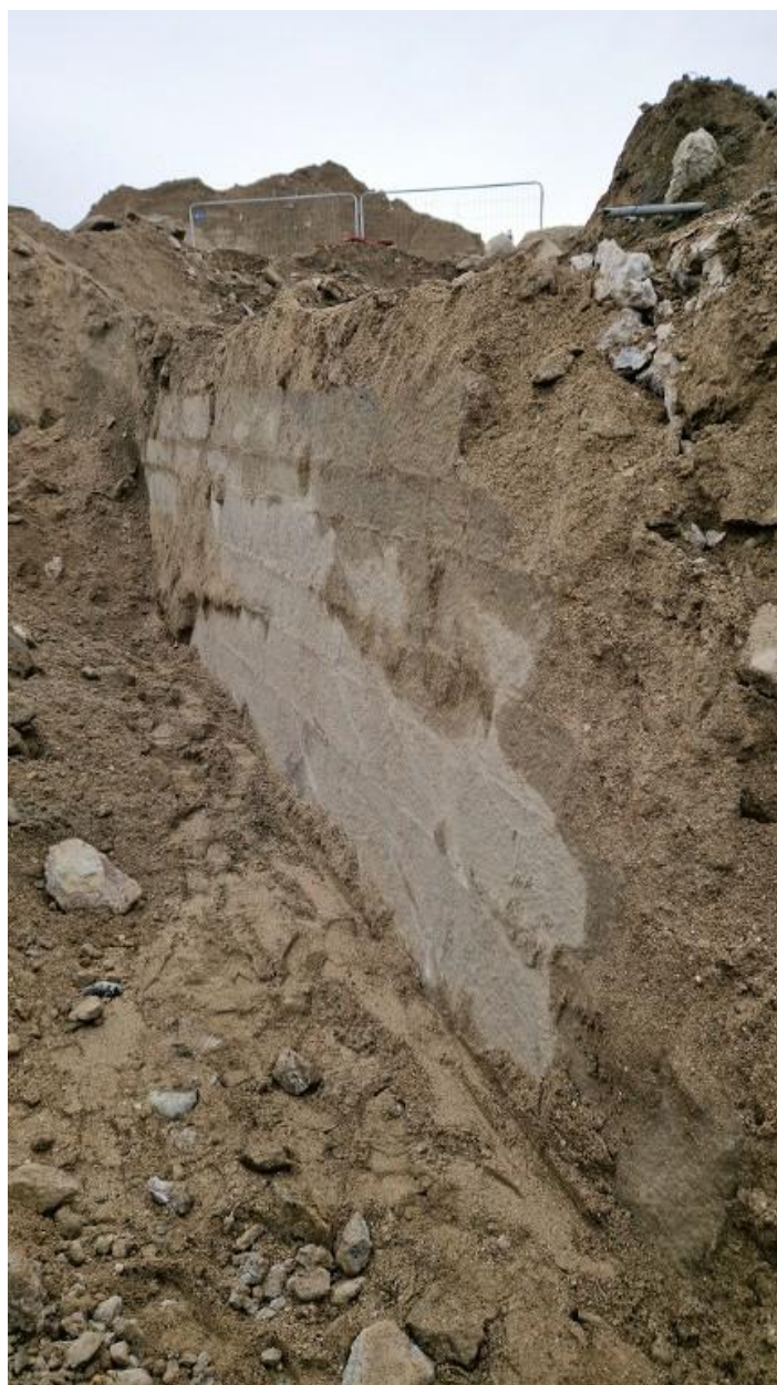
Vue des vestiges de la digue de l'avant-port de Saint-Servan vers le sud-est (couverture photographique du 17 décembre 2025). La digue est construit en maçonnerie de pierre de taille de granite
