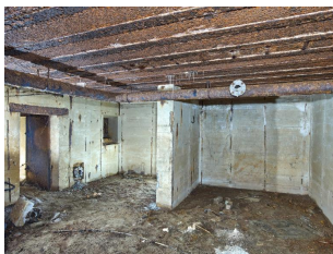
Vue de la salle de garde : elle est partiellement divisée par un mur de refend. A gauche, porte étanche d'accès et bouche de surpression à clapet. Au plafond, tuyauterie du système de ventilation
