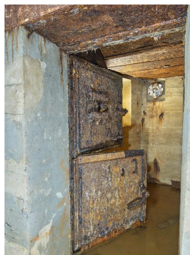
Vue de l'entrée de la caponnière avec sa porte blindée à deux vantaux.
