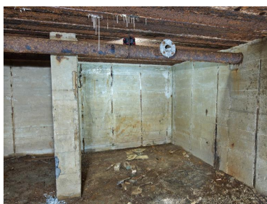
Vue de détail de la salle de garde : elle est partiellement divisée par un mur de refend. Au plafond, tuyauterie du système de ventilation
