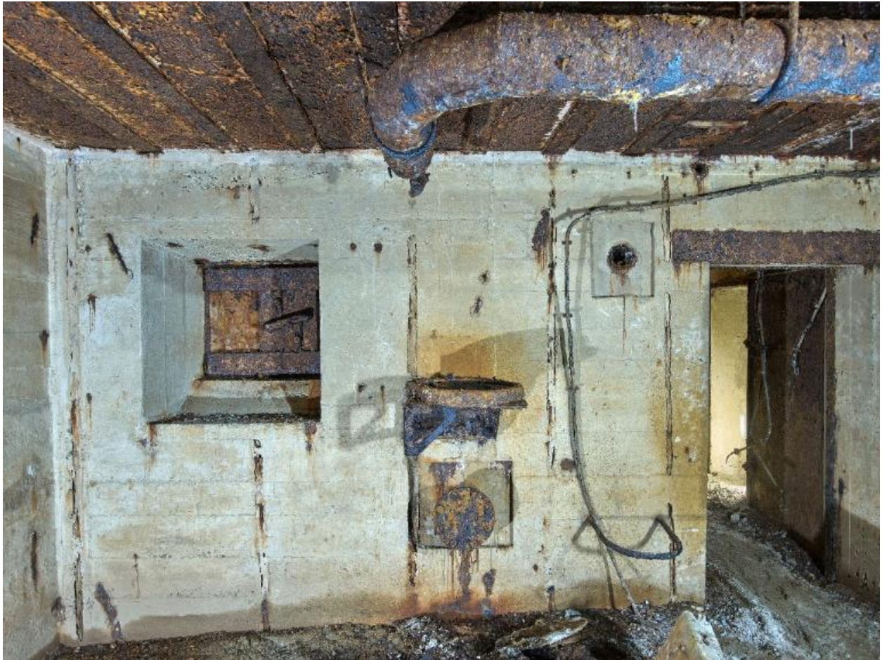
Vue de détail de la salle de garde : de gauche à droite, ouverture de tir blindée de l'entrée nord ; emplacement du système de ventilation avec arceau pour les filtres à charbon et tuyauterie au plafond ; à droite, porte étanche d'accès
