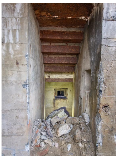
Vue de l'entrée sud : l'escalier d'accès est partiellement remblayé. Au fond, l'ouverture de tir blindée (coffrage en bois est en place) Phot. Bernard Bègne IVR53_20253501373NUCA
