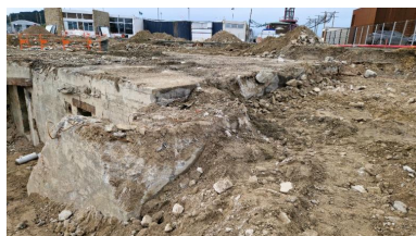
Vue de l'escalier tournant construit contre l'angle nord-est (couverture photographique du 17 décembre 2025). Cet escalier permettait à l'origine de desservir la cuve pour canon antiaérien (la cuve a été arasée avant 1961)
