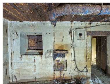
Vue de détail de la salle de garde : de gauche à droite, ouverture de tir blindée de l'entrée nord ; emplacement du système de ventilation avec arceau pour les filtres à charbon et tuyauterie au plafond ; à droite, porte étanche d'accès
