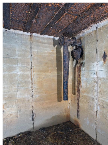
Vue de détail de l'angle nord-ouest de la salle de garde : conduit de cheminée (en haut) et conduit de ramonage (en bas) du poêle
