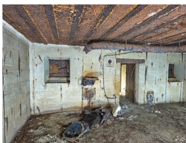
Vue de la salle de garde. De part et d'autre de la pièce, les ouvertures de tir blindées ; au centre, la porte étanche d'accès, à gauche de la porte l'emplacement du système de ventilation ; à droite de la porte, bouche de surpression à clapet
