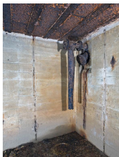
Vue de détail de l'angle nord-ouest de la salle de garde : conduit de cheminée (en haut) et conduit de ramonage (en bas) du poêle
