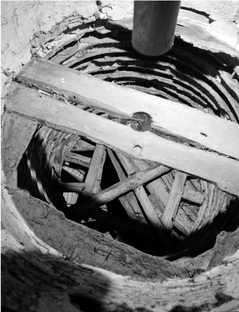
Charpente de la tourelle.
