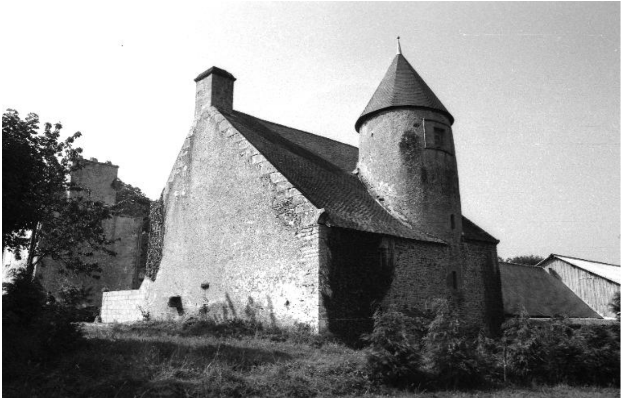
Vue d'ensemble du pignon est et de la façade nord.
