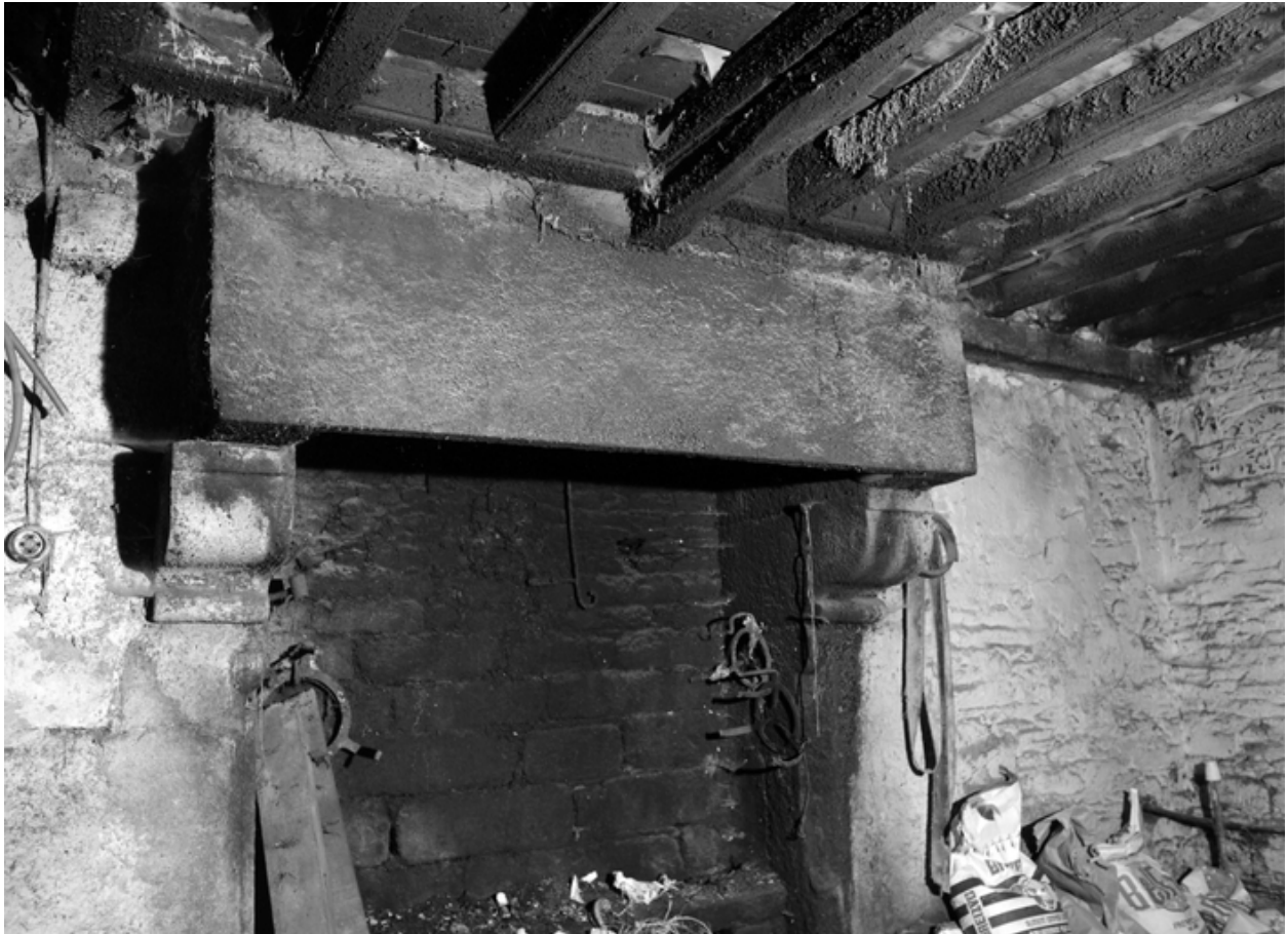
Cheminée, vue générale.
