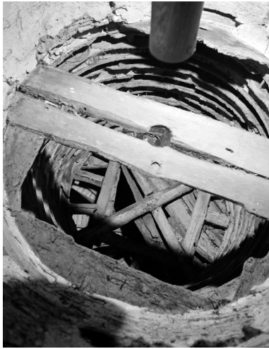
Charpente de la tourelle. Phot. François Dagorn IVR53_19745600486X
