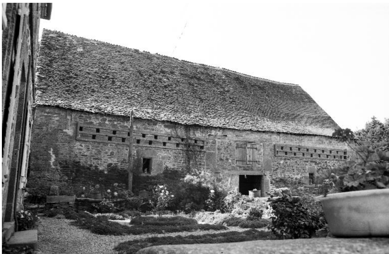
Communs, vue d'ensemble de la façade nord.
