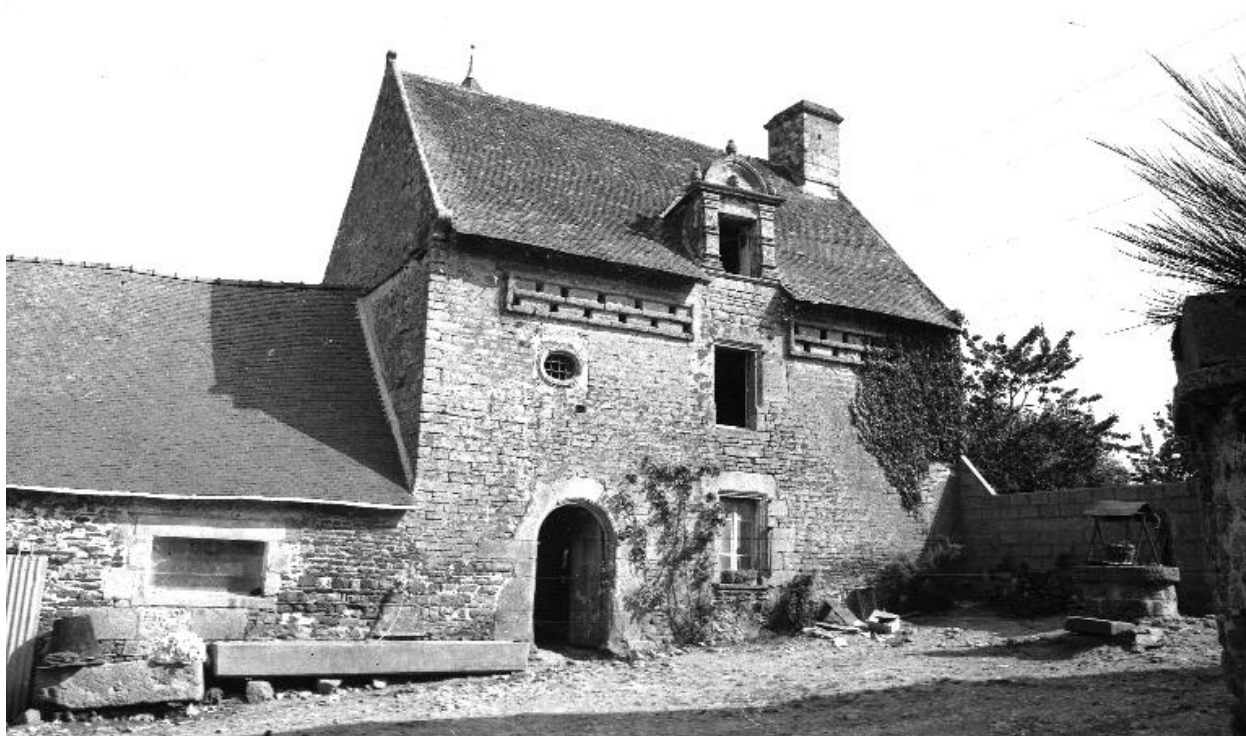
Vue générale de la façade sud.
