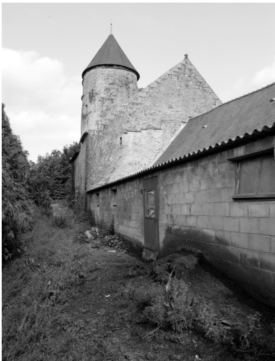
Vue générale de la façade postérieure.
