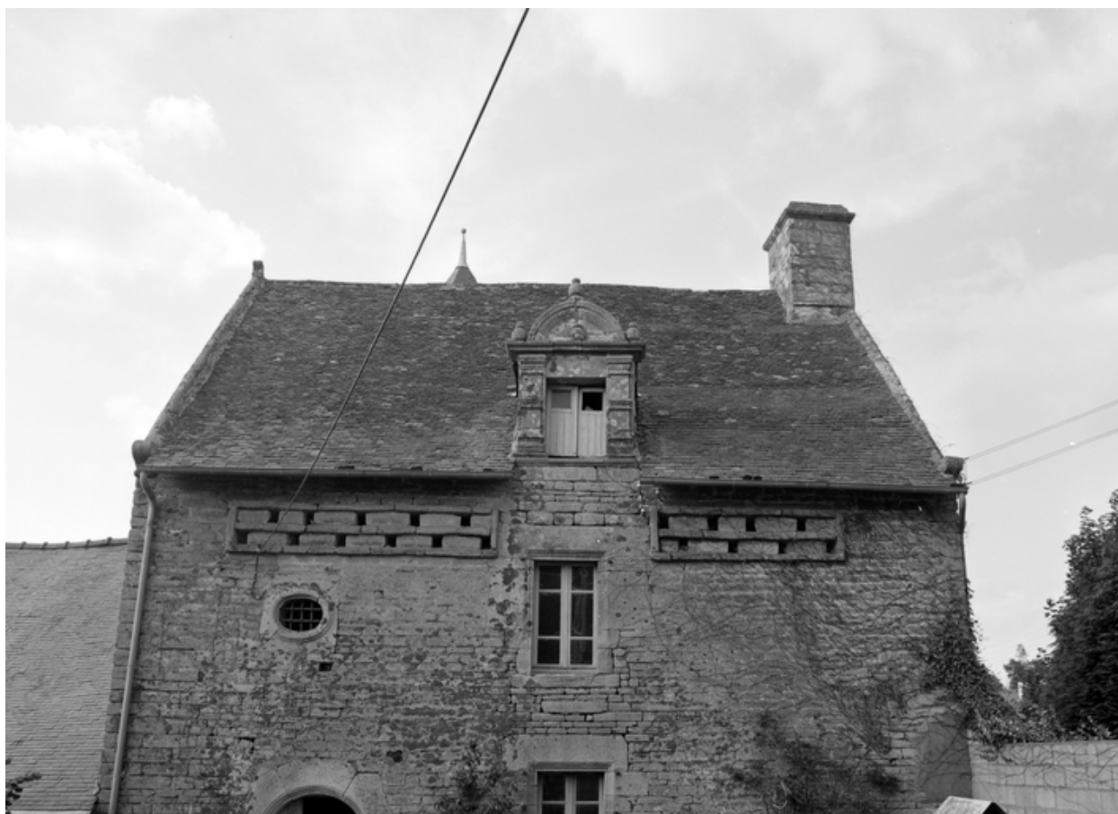
Détail de la façade.
