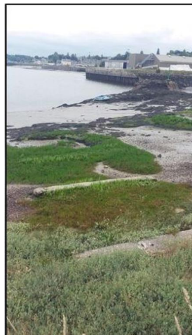
Ces barres en béton de la rampe d'accès à l'eau sont les seuls vestiges du centre d'aviation maritime de Tréguier Phot. Alain Bohée IVR53_20182207552NUCA
