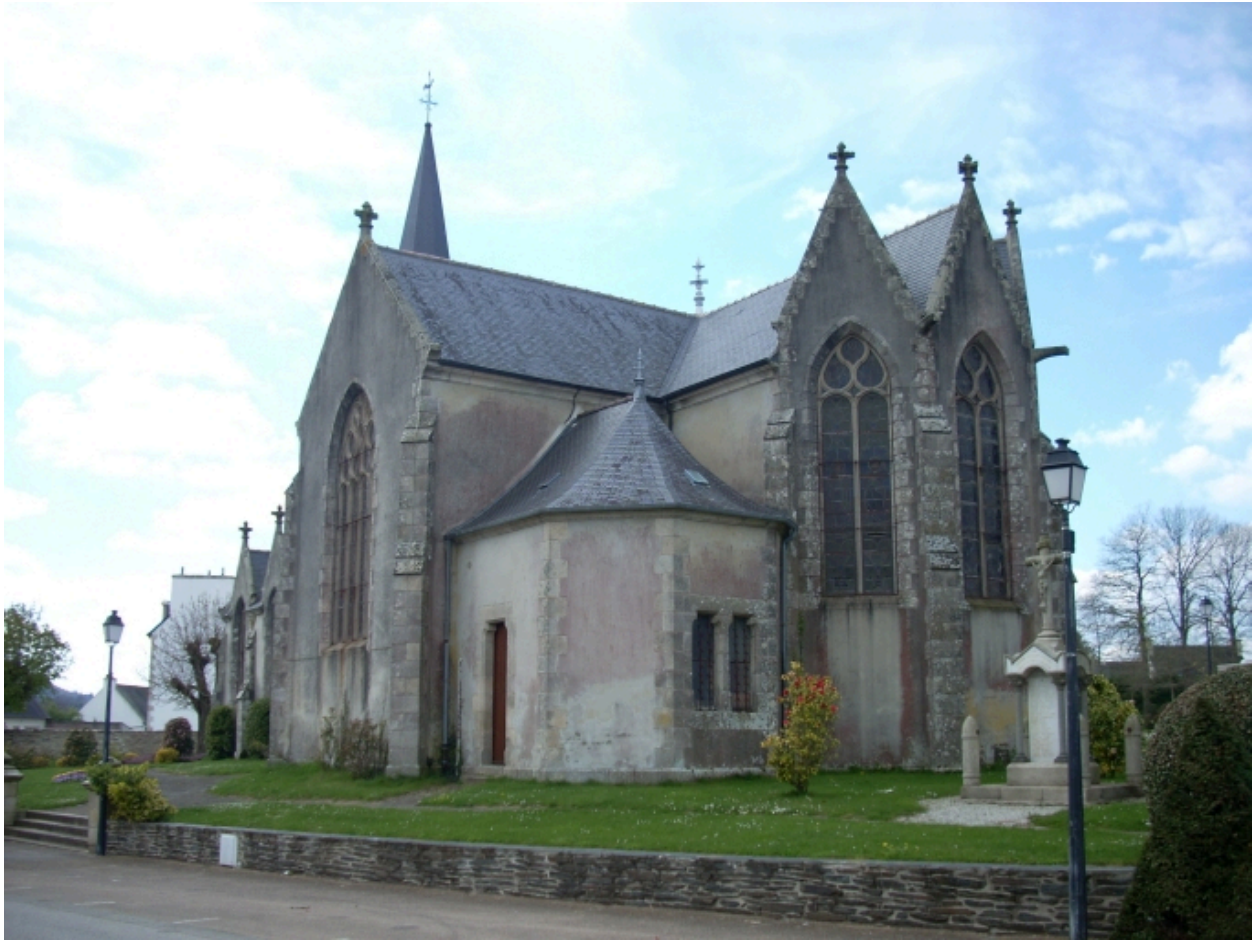
Vue générale sud-est, état en 2008.
