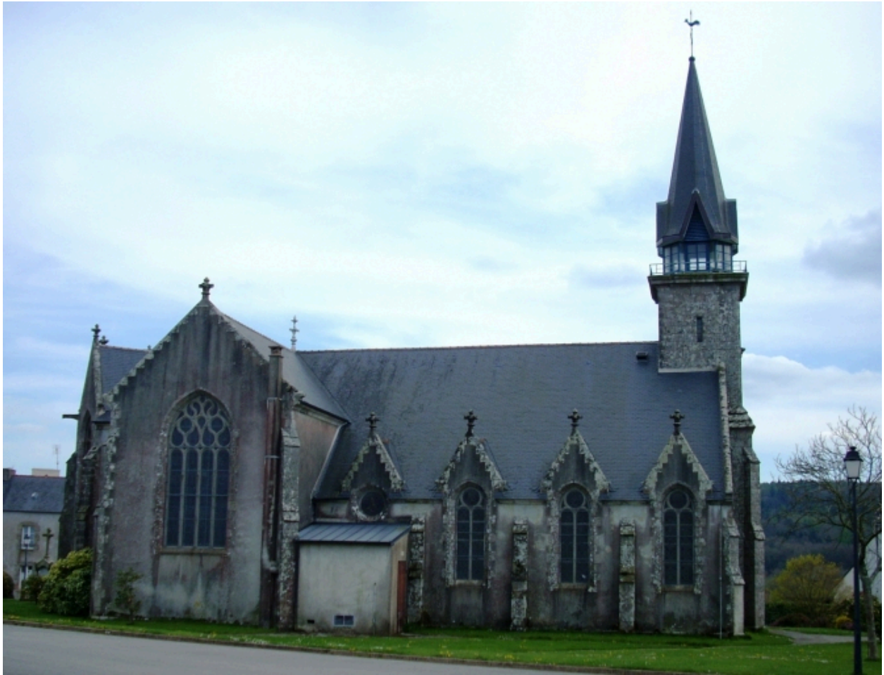
Vue générale nord, état en 2008.
