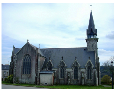
Vue générale nord, état en 2008. Phot. Gwénaél Fauchille IVR53_20082905552NUCA
