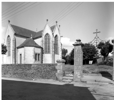
Vue générale sud-est, état en 1966. Phot. François Dagorn IVR53_19662900279V
