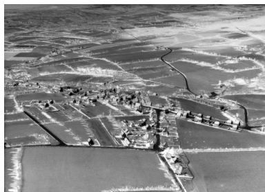
Vue aérienne prise de l'ouest Phot. G.A.L.A.T. IVR53_19732900016V
