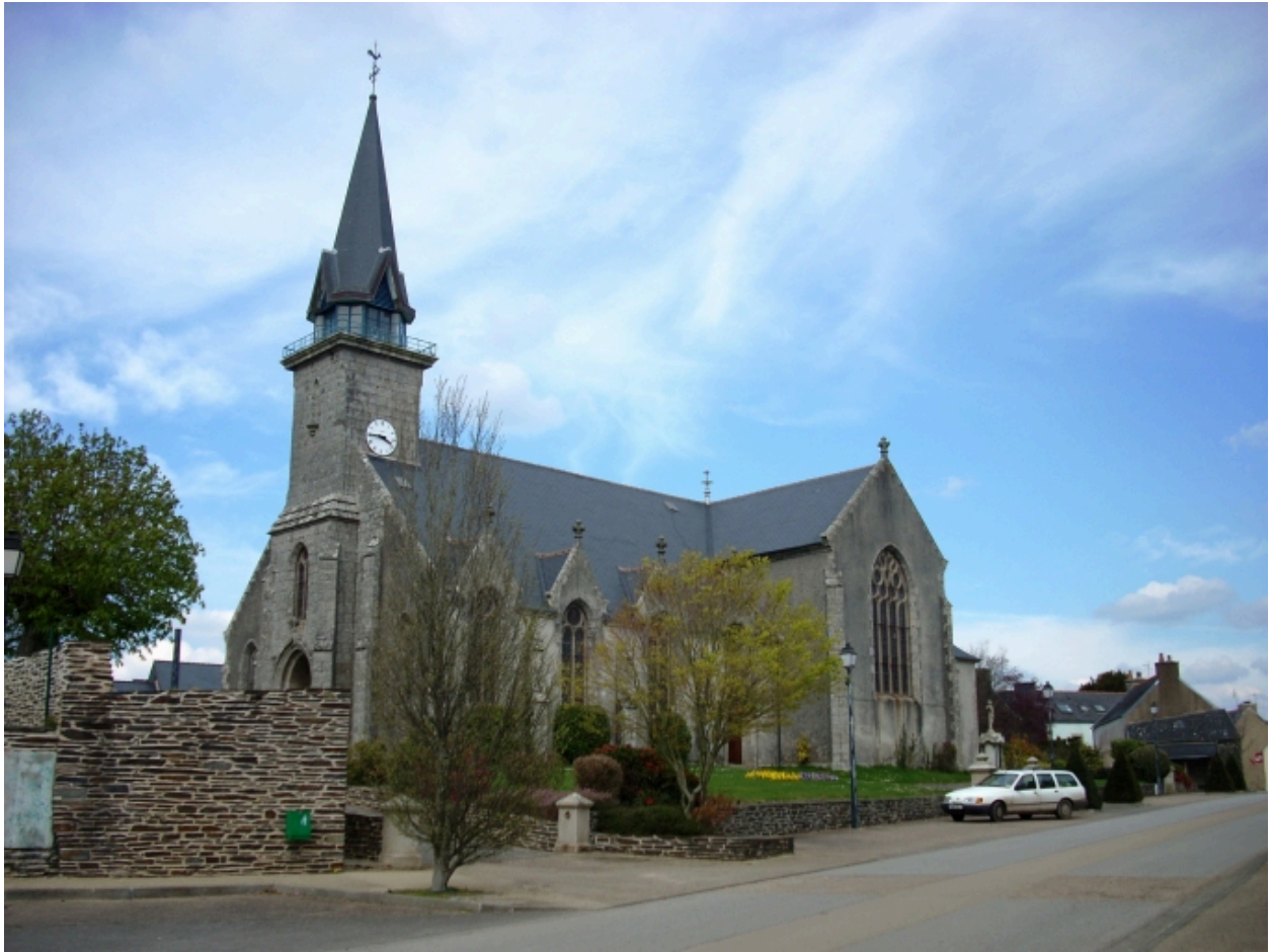
Vue générale sud-ouest, état en 2008.
