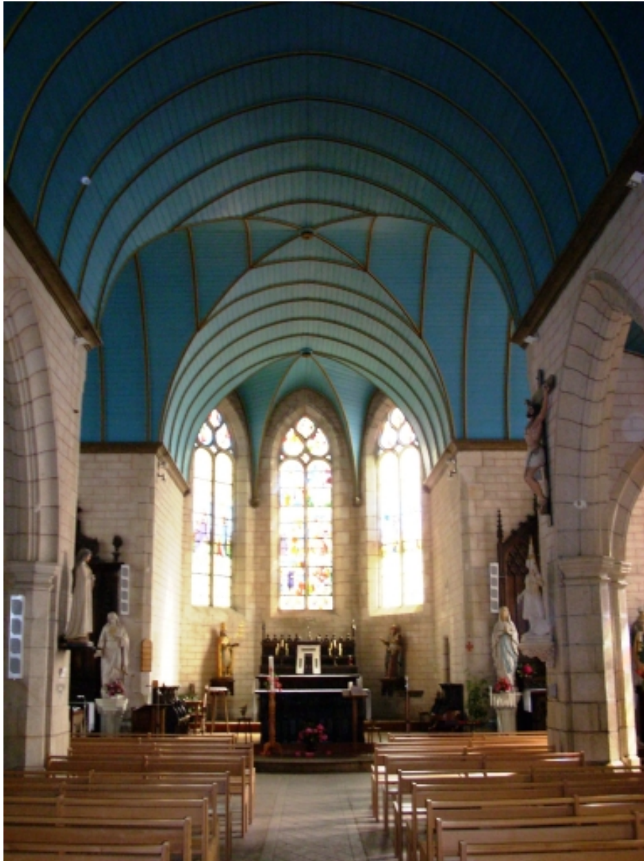
Vue axiale est, état en 2008.
