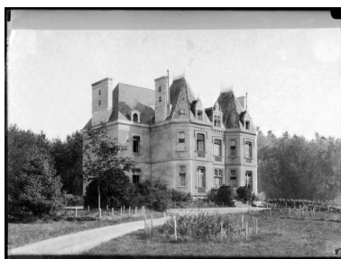
Château : élévation sud-est (état entre 1900-1920) Phot. Gustave William Lemaire IVR53_20155606066NUCB
