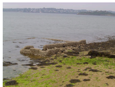
Bassin de décantation à huîtres Phot. Clotilde Buhot IVR53_20062908524NUCA
