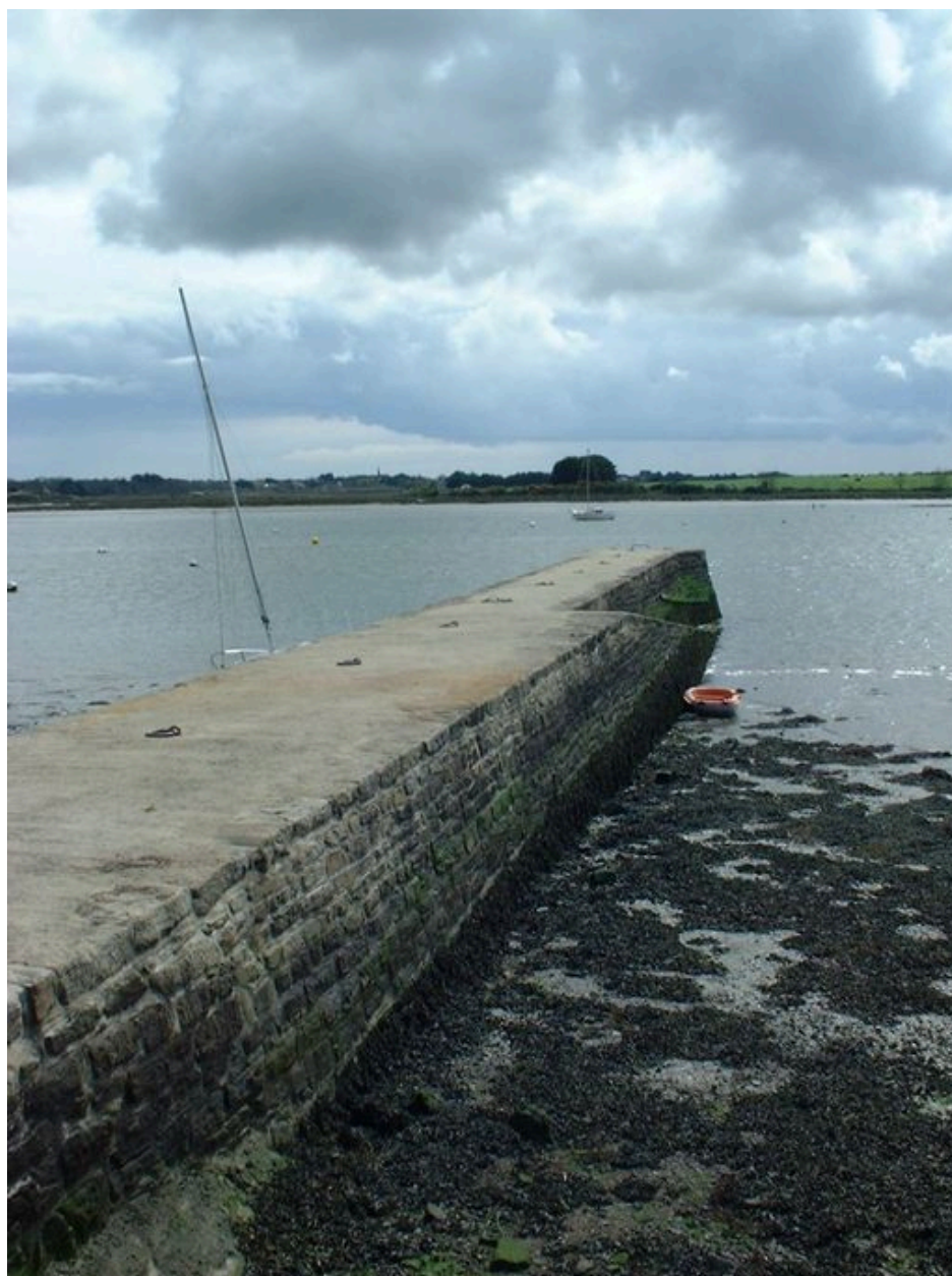
Vue générale de la jetée de la Garenne
