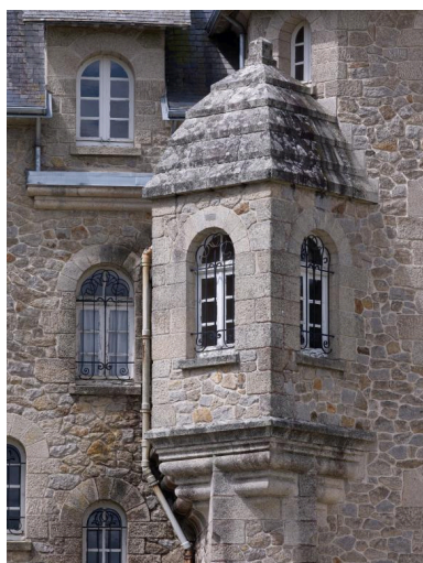
Vue de l'échauguette. Phot. Bernard Bègne IVR53_20115600738NUCA
