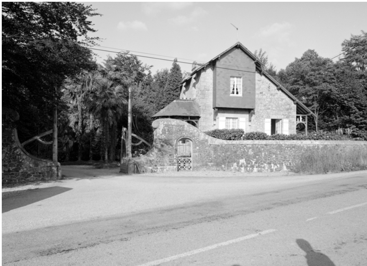
Pavillon d'entrée, vue générale.
