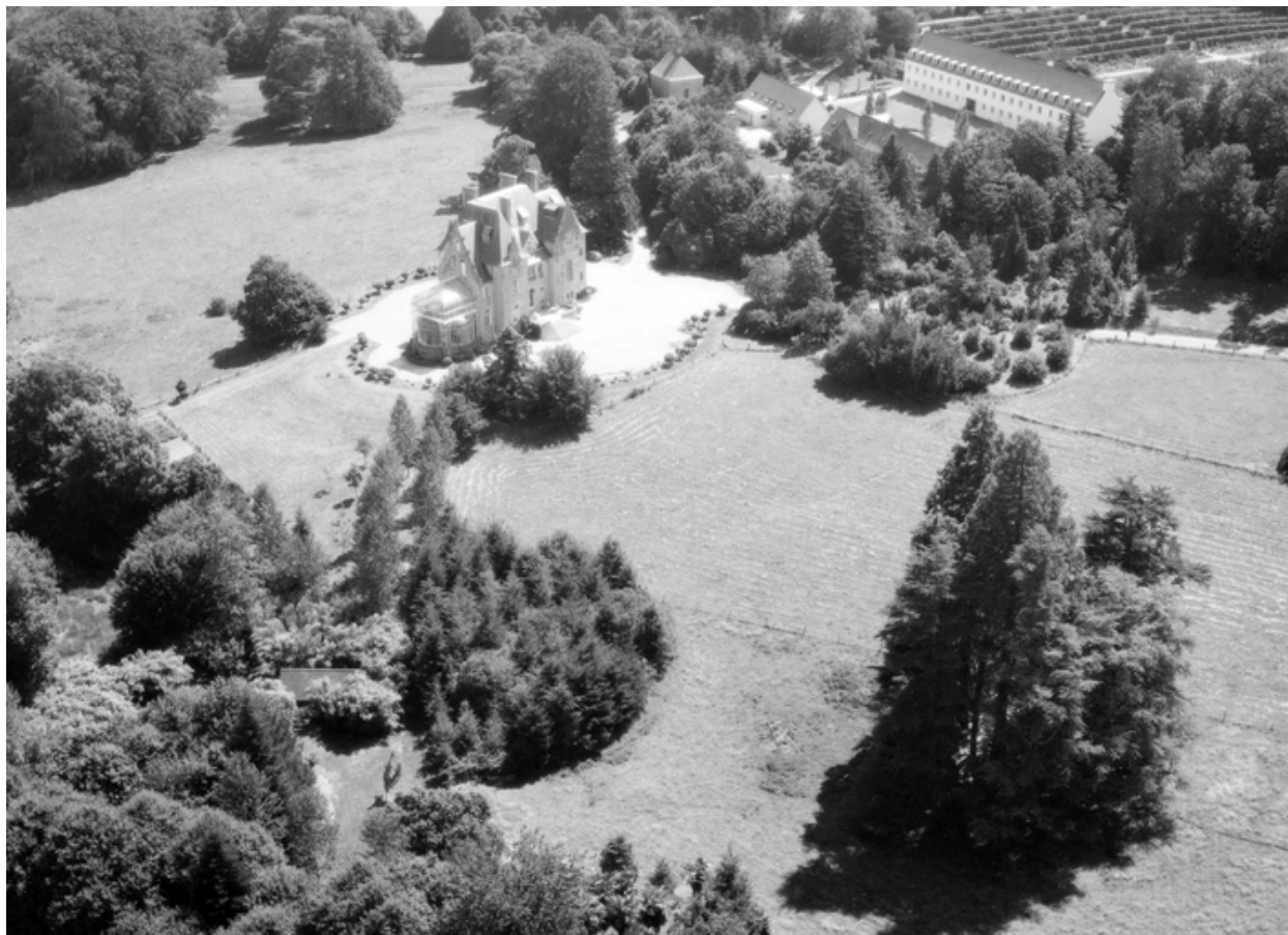
Vue aérienne sud-ouest.
