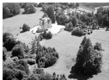
Vue aérienne sud-ouest.
