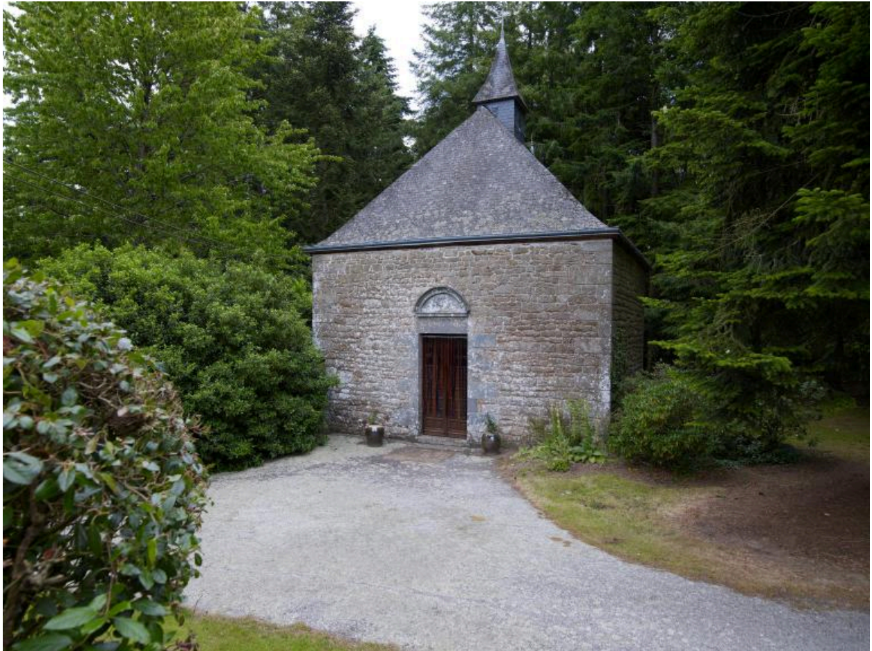
Vue générale de la chapelle.
