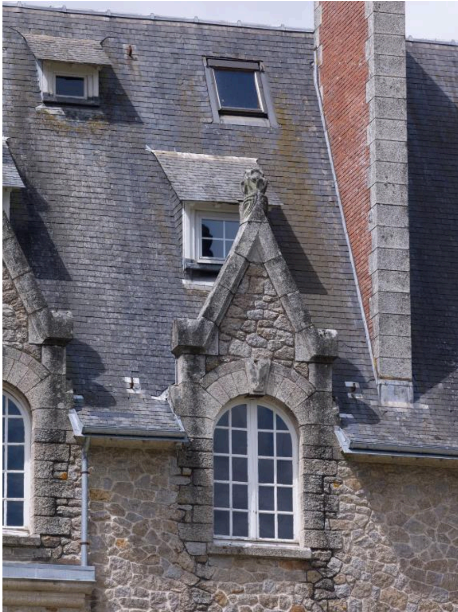
Vue de la fenêtre haute sur la façade est.
