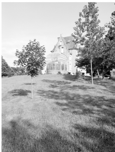
Élévation ouest, serre. Phot. Guy Artur, Phot. Norbert Lambart IVR53_19835601276X
