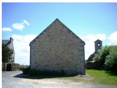
Brignogan, chapelle- Pol : élévation est Phot. Gwénaél Fauchille IVR53_20082906310NUCA
