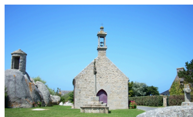
Brignogan, chapelle- Pol : élévation ouest Phot. Gwénaél Fauchille IVR53_20082906309NUCA
