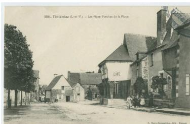
On aperçoit le corps de passage en pan de bois soutenu par un poteau et un aisselier à droite de l'image. Plus loin, un porche subsiste.
