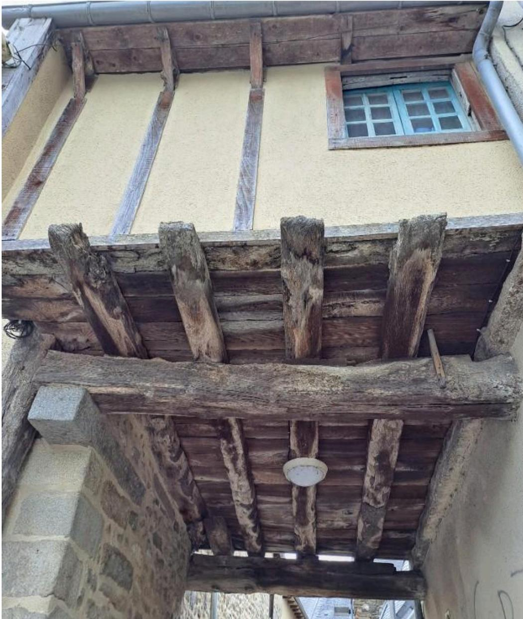
Le plancher repose sur des solives qui s'appuient sur deux poutres ancrées dans les bâtiments de part et d'autre de la ruelle.
