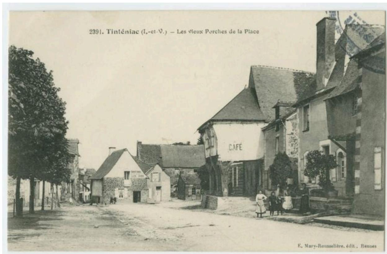
On aperçoit le corps de passage en pan de bois soutenu par un poteau et un aisselier à droite de l'image. Plus loin, un porche subsiste.
