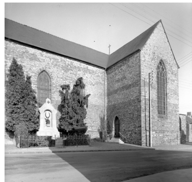
Elévation Sud, bras Sud du transept : vue générale Phot. Auteur inconnu IVR53_19703500013V
