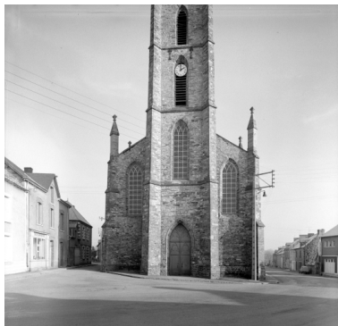
Elévation Ouest : vue générale Phot. Auteur inconnu IVR53_19703500011V
