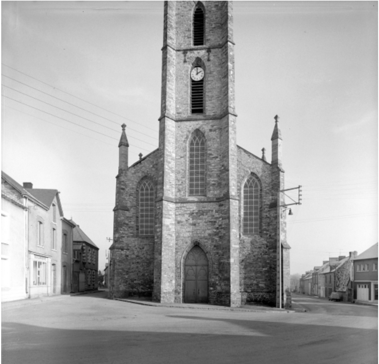
Elévation Ouest : vue générale
