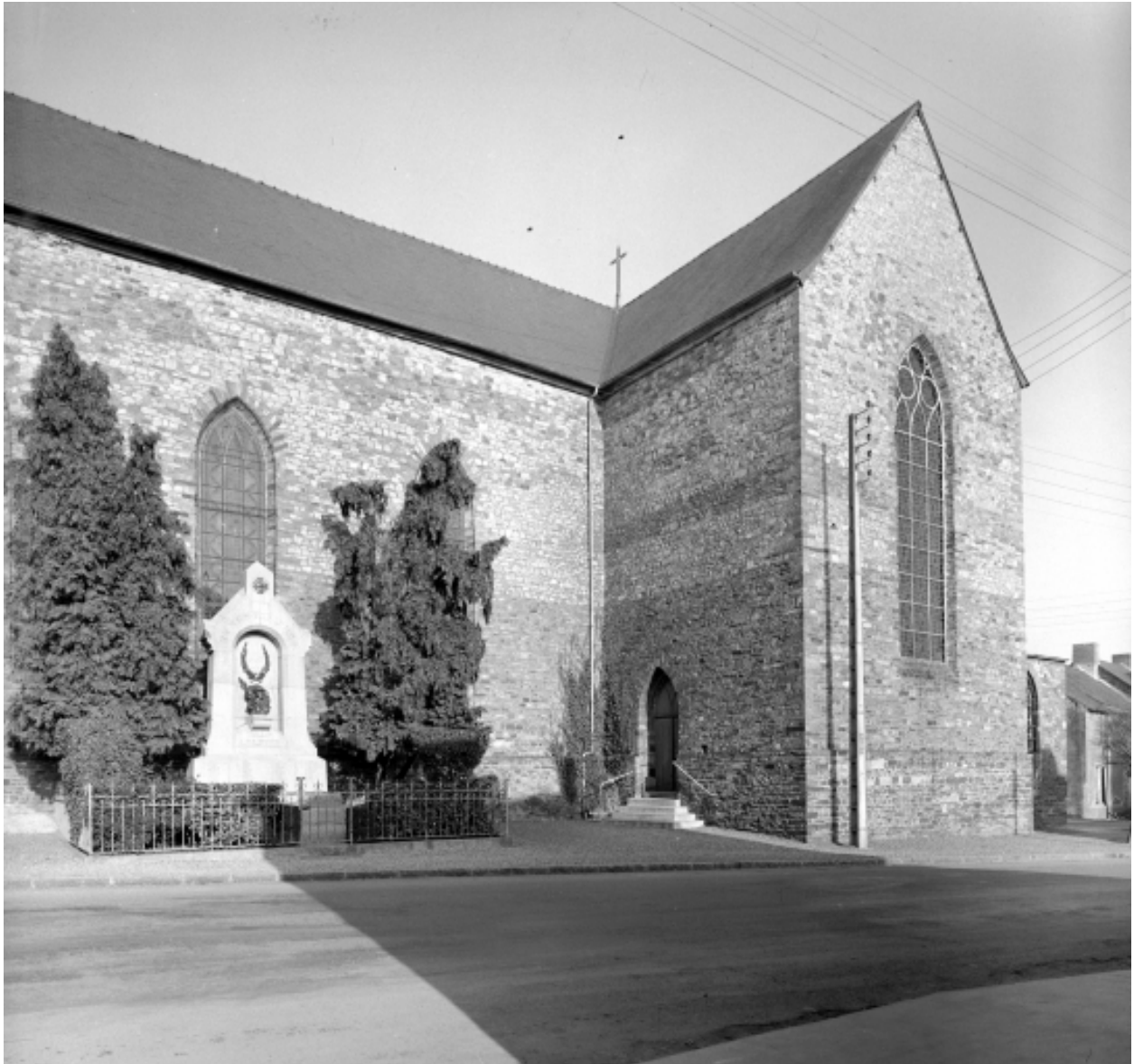
Elévation Sud, bras Sud du transept : vue générale
