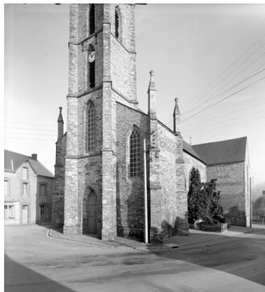
Elévation Sud-Ouest : vue générale Phot. Auteur inconnu IVR53_19703500010V
