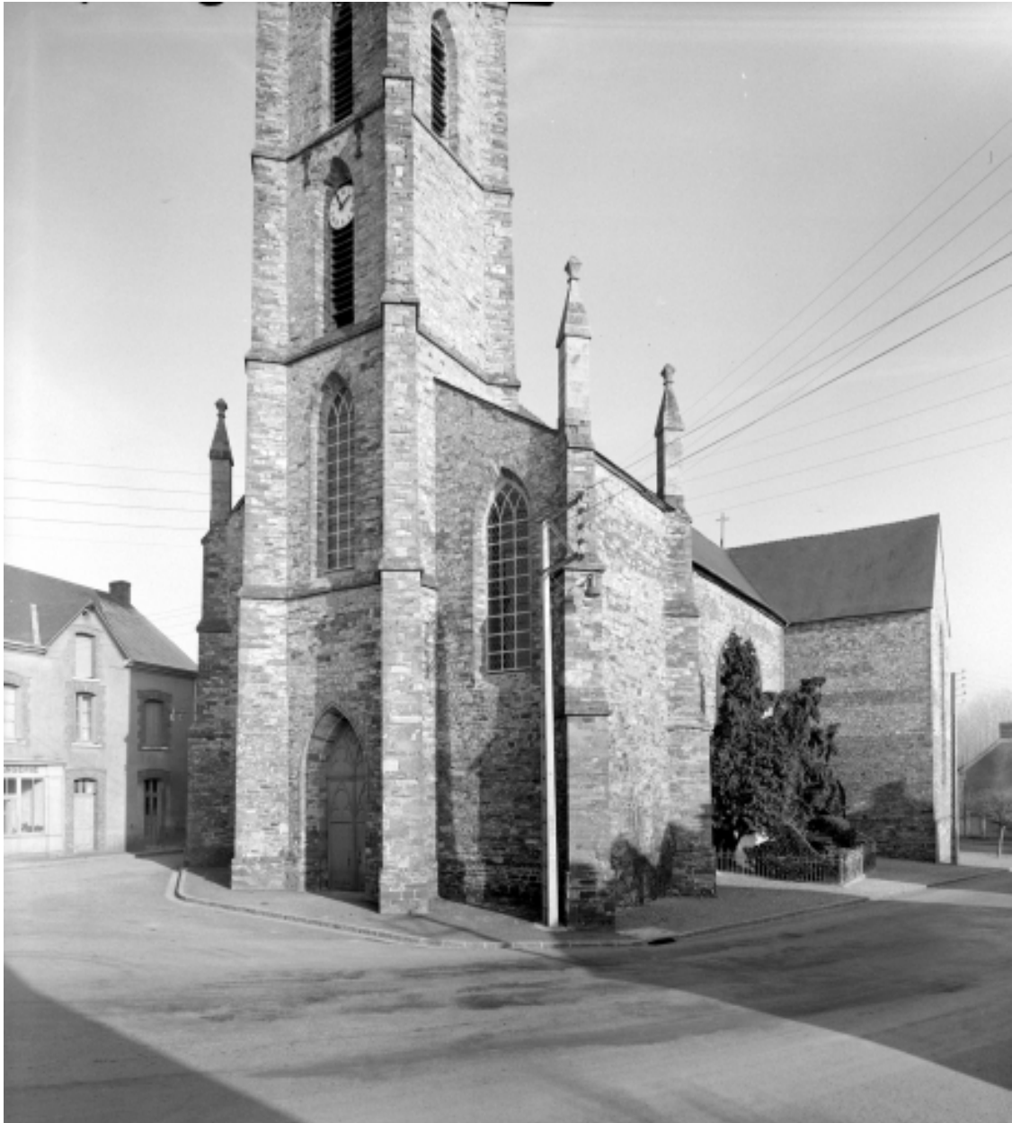
Elévation Sud-Ouest : vue générale
