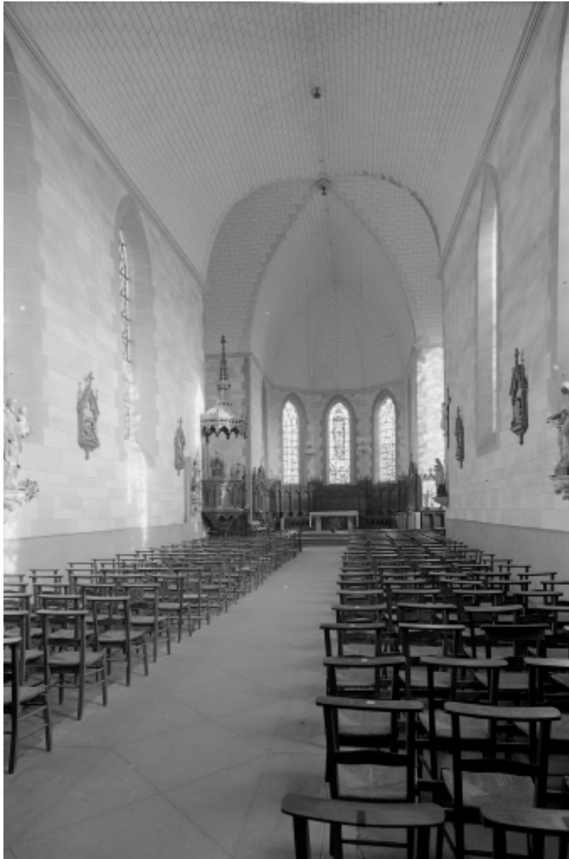
Intérieur : vue générale vers le chœur.
