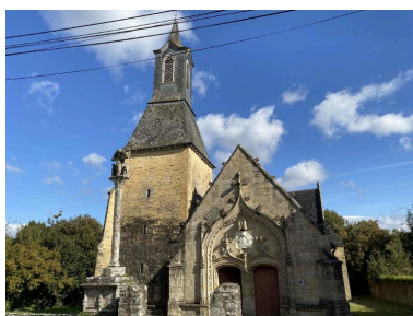
Vue générale sud
