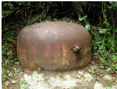
Vue générale de la cloche blindée de type 486P2 (état en 2002) Phot. Guillaume Lécueillier IVR53_20022902927NUCA
