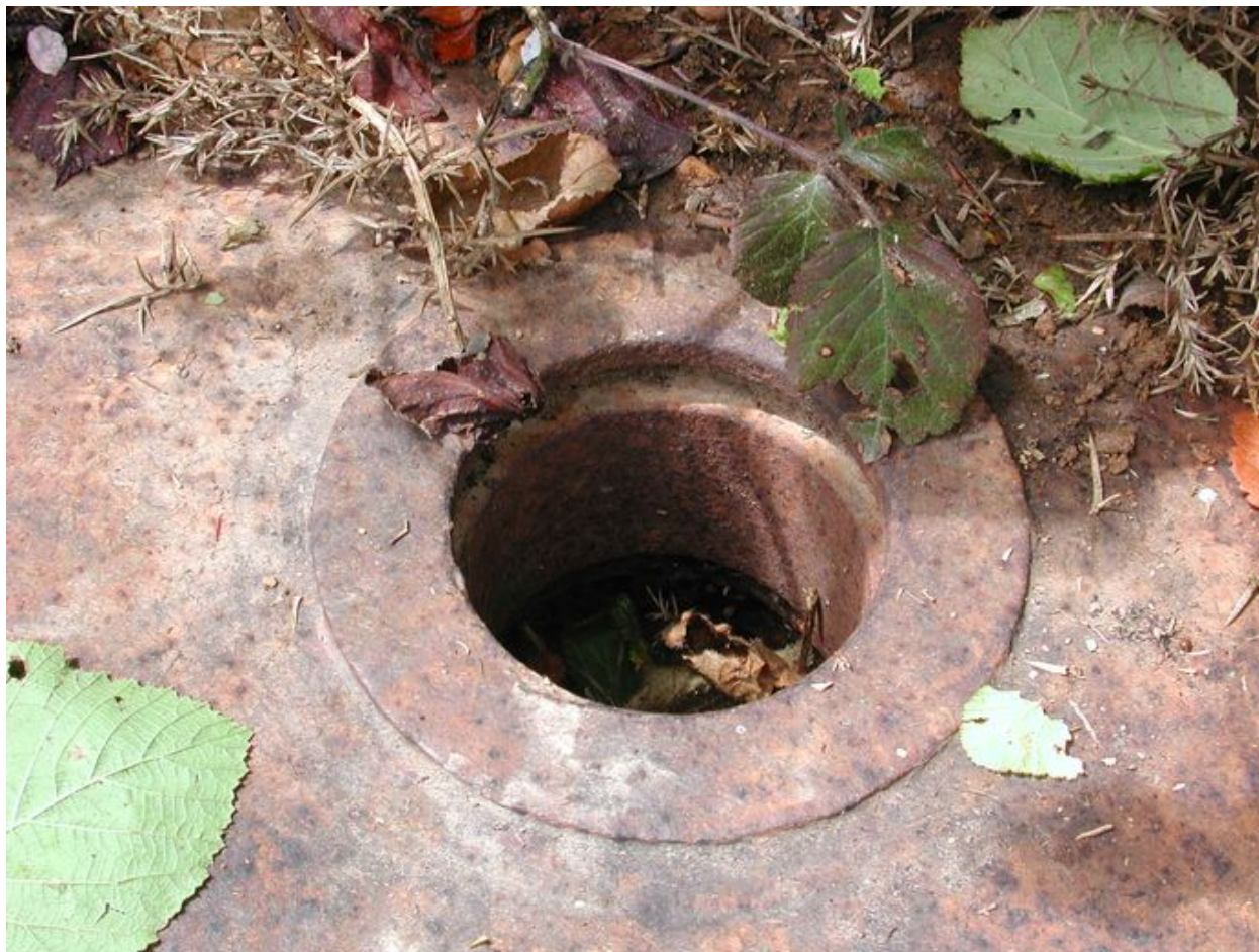
Vue de détail de la cloche blindée de type 486P2 : orifice du périscope (état en 2002)
