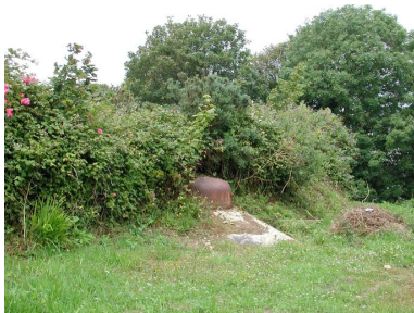
Vue générale de la cloche blindée de type 486P2 (état en 2002) Phot. Guillaume Lécueillier IVR53_20022902926NUCA
