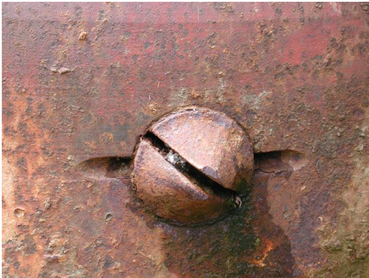
Vue de détail de la cloche blindée de type 486P2 (état en 2002)
