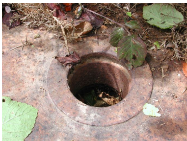
Vue de détail de la cloche blindée de type 486P2 : orifice du périscopes (état en 2002) Phot. Guillaume Lécueillier IVR53_20022902929NUCA
