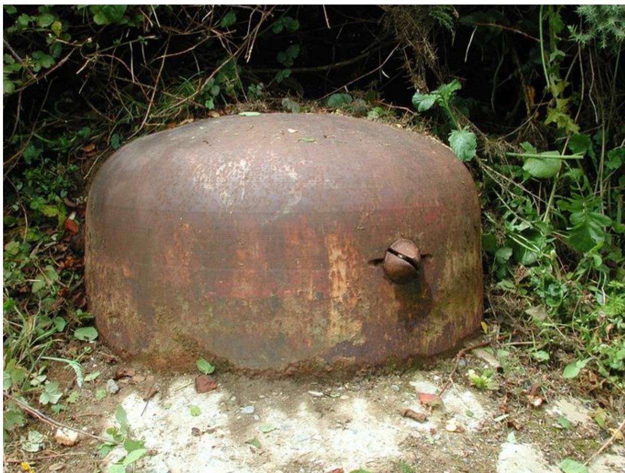
Vue générale de la cloche blindée de type 486P2 (état en 2002)
