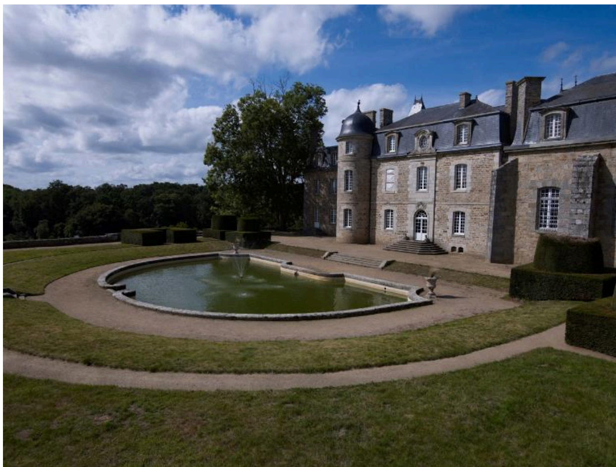
Vue de l'élévation orientée vers le sud-est. Au premier plan, le miroir d'eau. A droite, le chartrier encadré de contreforts
