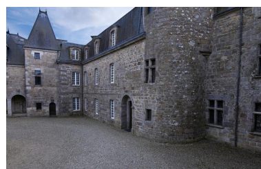
Vue de l'élévation ouest Phot. Bernard Bègne IVR53_20122201143NUCA
