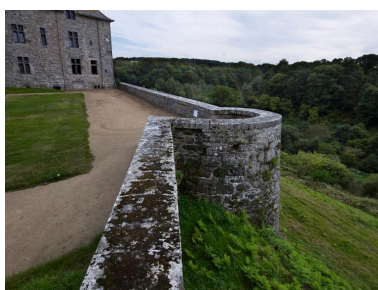
Vue de la terrasse du château dominant la vallée et le Dour Elégo Phot. Bernard Bègne IVR53_20122201153NUCA
