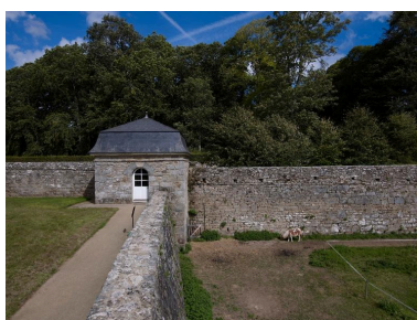
Vue du pavillon de jardin de l'angle sud-est aménagé sur le mur de clôture retenant également la terre des terrasses Phot. Bernard Bègne IVR53_20122201110NUCA
