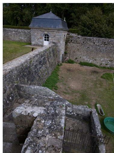
Vue du pavillon de jardin de l'angle sud-est aménagé sur le mur de clôture retenant également la terre des terrasses Phot. Bernard Bègne IVR53_20122201095NUCA
