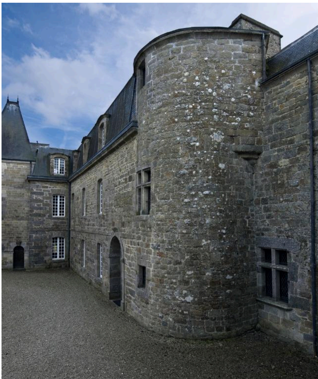
Vue de l'élévation ouest : tour d'escalier arasée
