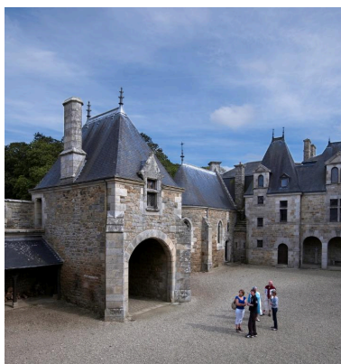
Vue du pavillon abritant la porte charretière (logis-porche) Phot. Bernard Bègne IVR53_20122201135NUCA
