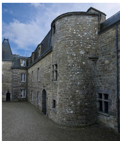
Vue de l'élévation ouest : tour d'escalier arasée Phot. Bernard Bègne IVR53_20122201141NUCA
