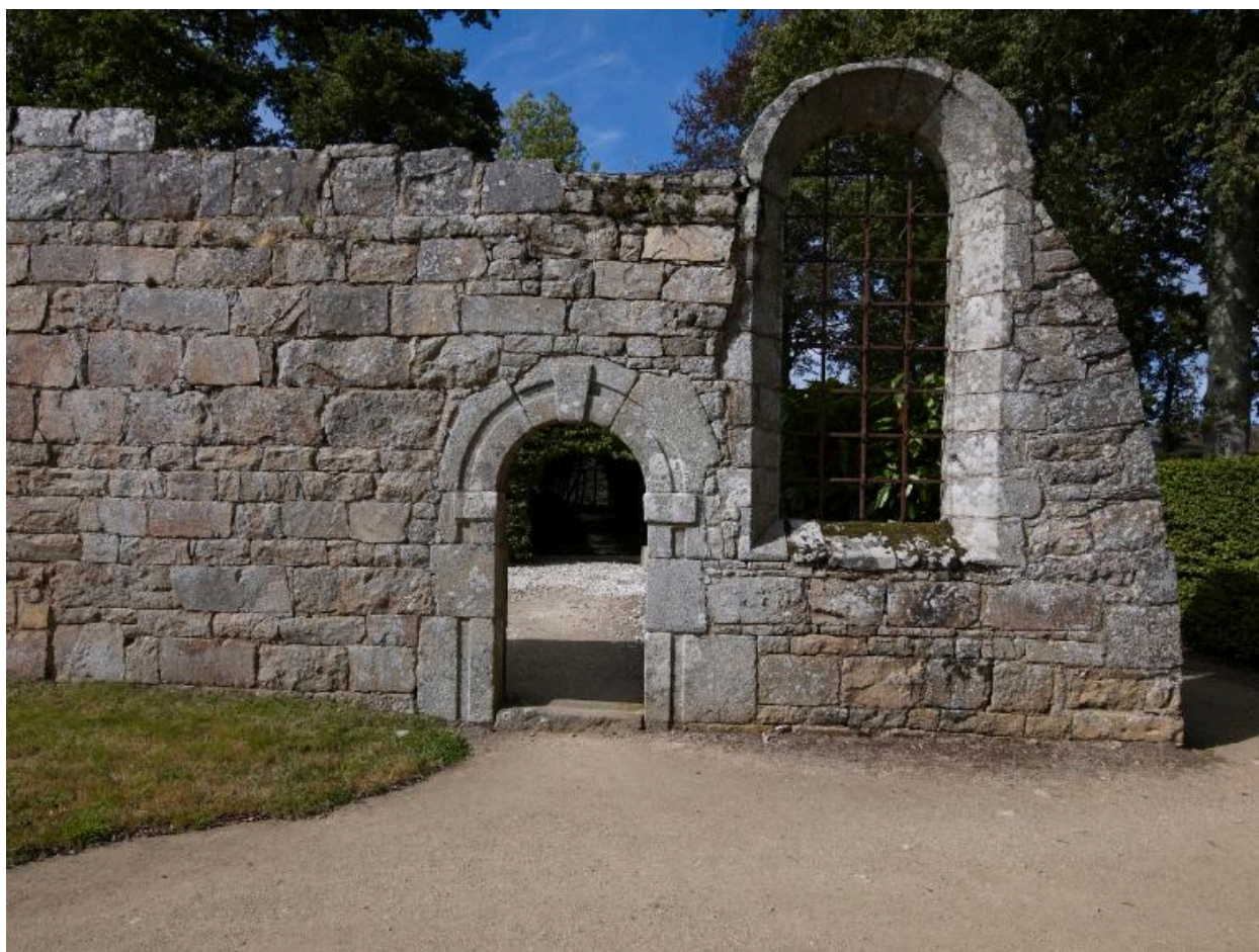
Vue des vestiges de la chapelle située au nord du château : porte sud et baie en arc plein cintre
