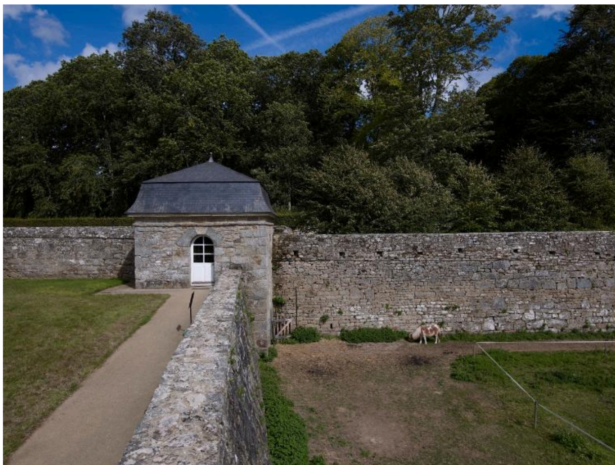
Vue du pavillon de jardin de l'angle sud-est aménagé sur le mur de clôture retenant également la terre des terrasses
