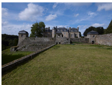
Vue de l'élévation orientée vers le sud-est depuis la terrasse inférieure. Les trois pavillons de jardin rythment le mur de clôture Phot. Bernard Bègne IVR53_20122201114NUCA
