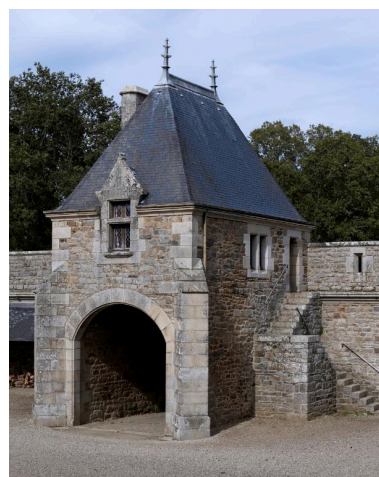
Vue du pavillon abritant la porte charretière (logis-porche) Phot. Bernard Bègne IVR53_20122201146NUCA
