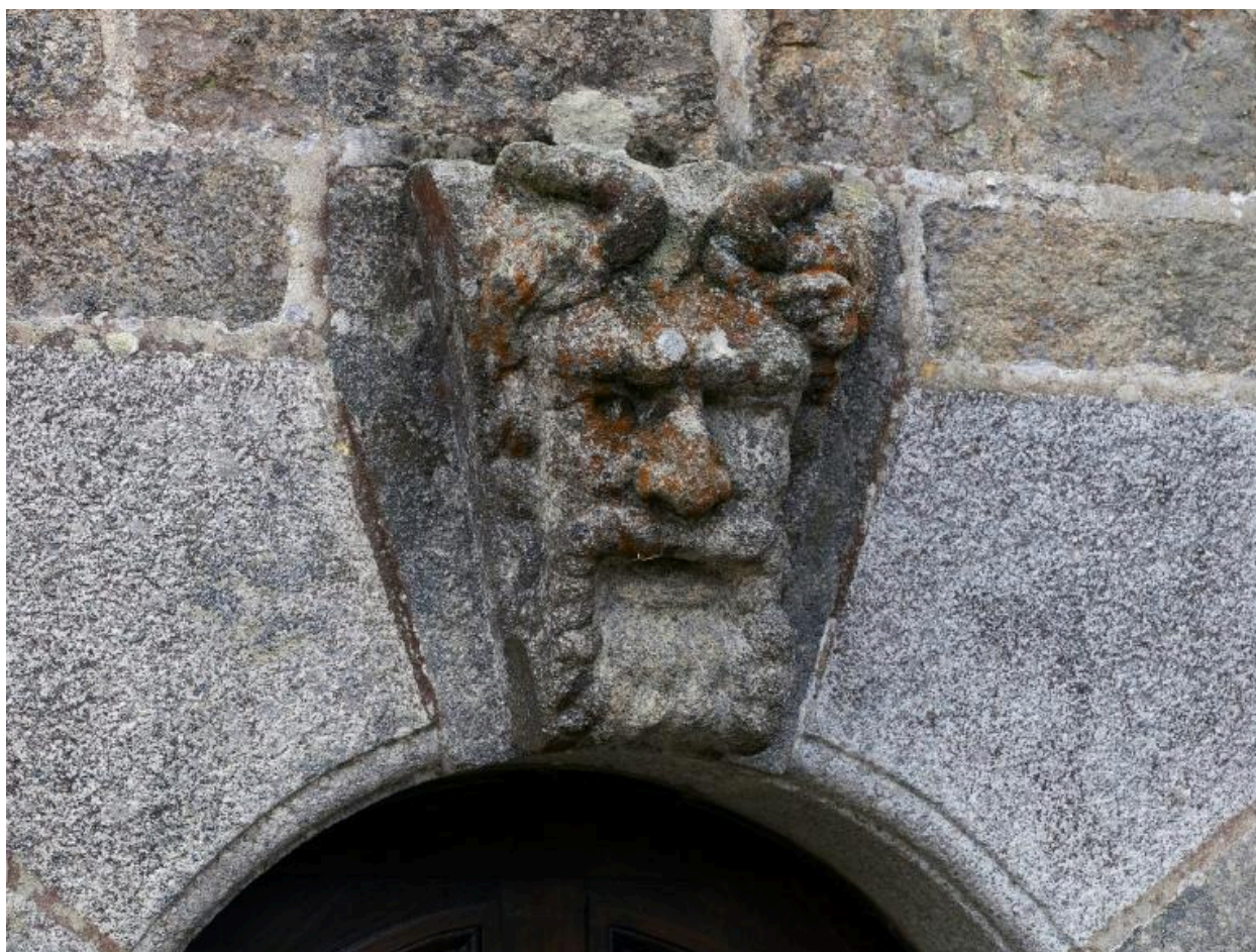
Vue de détail d'un mascaron sur l'élévation sud
