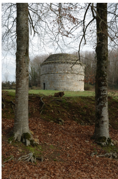
Vue de situation du colombier Phot. Guillaume Lécueillier IVR53_20112206519NUCA
