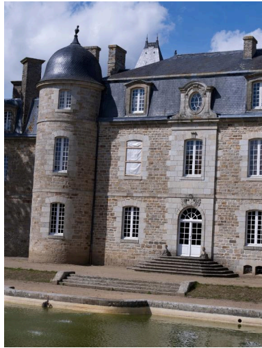
Vue de l'élévation orientée vers le sud-est. Au premier plan, le miroir d'eau Phot. Bernard Bègne IVR53_20122201102NUCA
