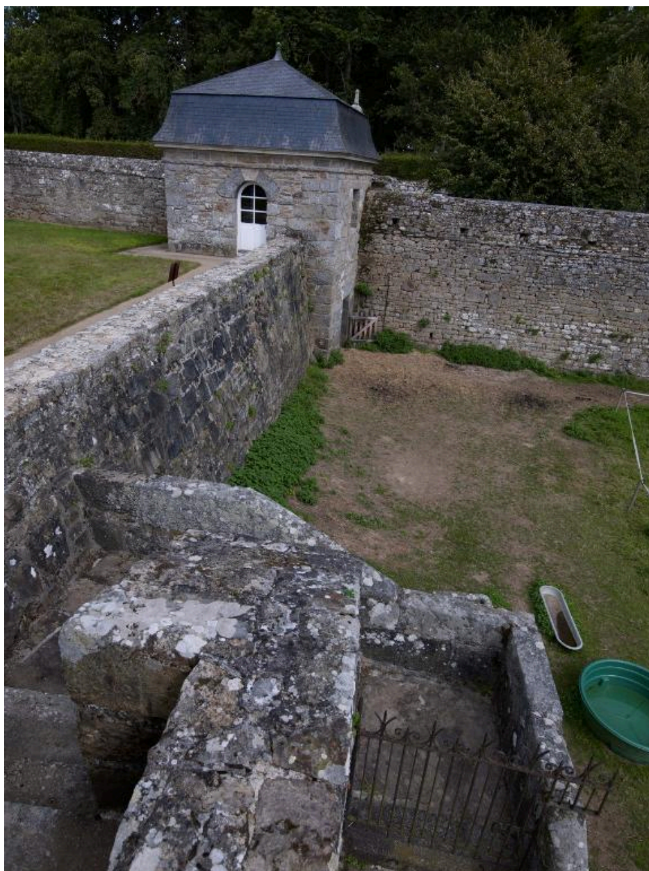
Vue du pavillon de jardin de l'angle sud-est aménagé sur le mur de clôture retenant également la terre des terrasses
