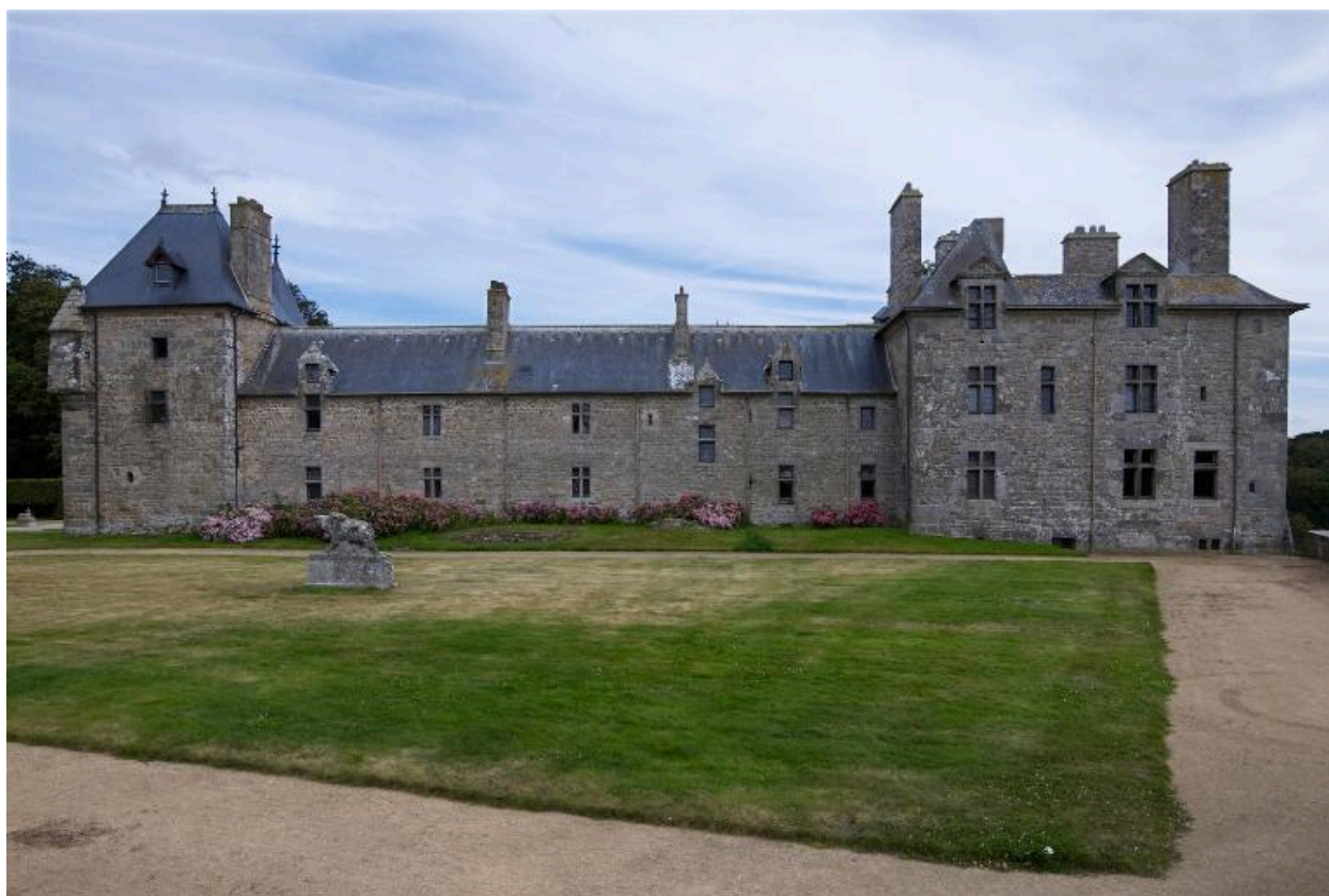
Vue générale de l'élévation orientée vers le nord-ouest
