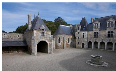
Vue de la cour intérieure Phot. Bernard Bègne IVR53_20122201142NUCA
