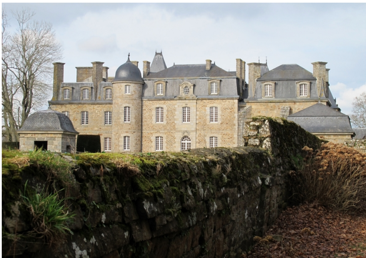
Vue générale de l'élévation orientée vers le sud-est
