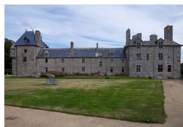
Vue générale de l'élévation orientée vers le nord-ouest Phot. Bernard Bègne IVR53_20122201152NUCA
