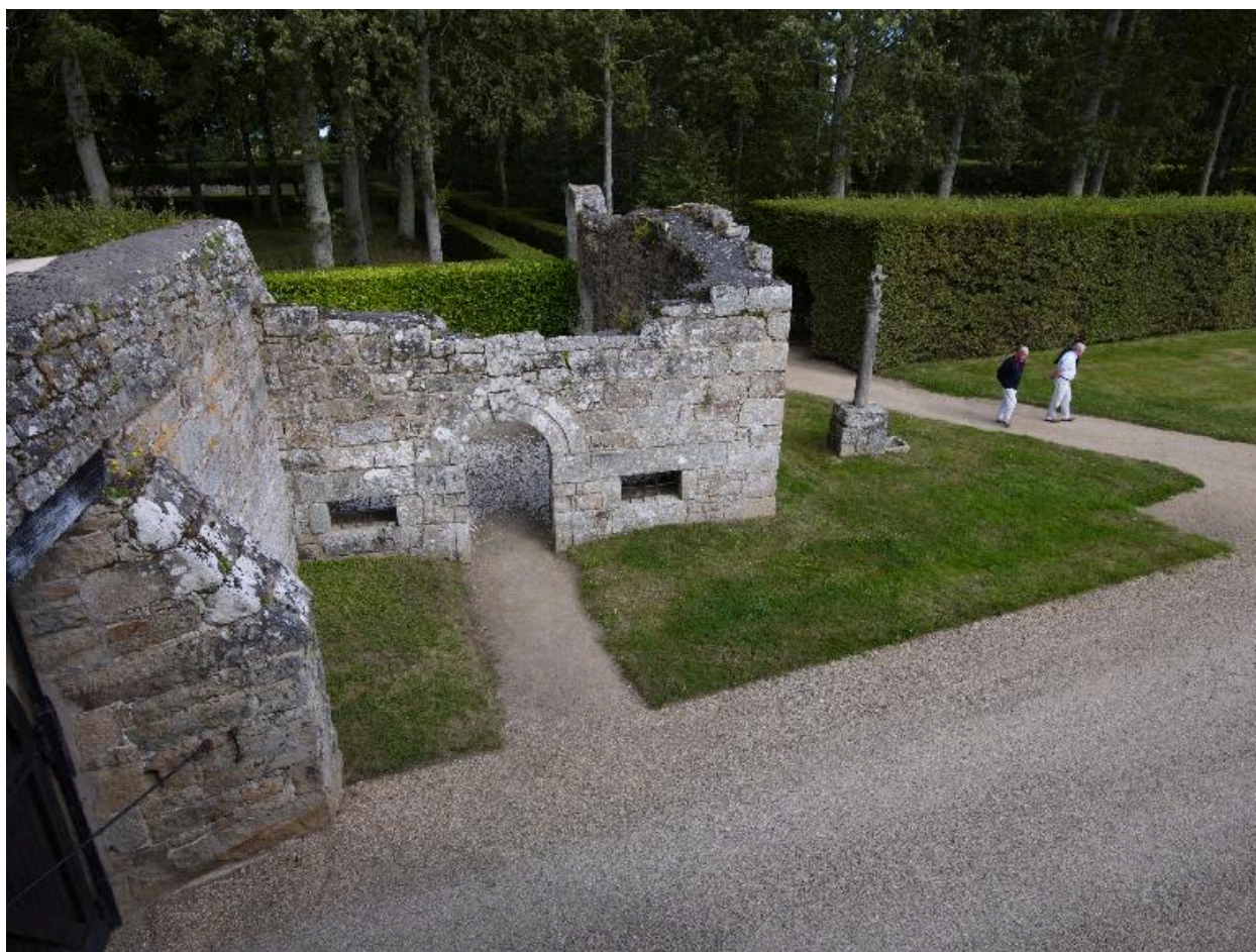
Vue des vestiges de la chapelle située au nord du château et son calvaire
