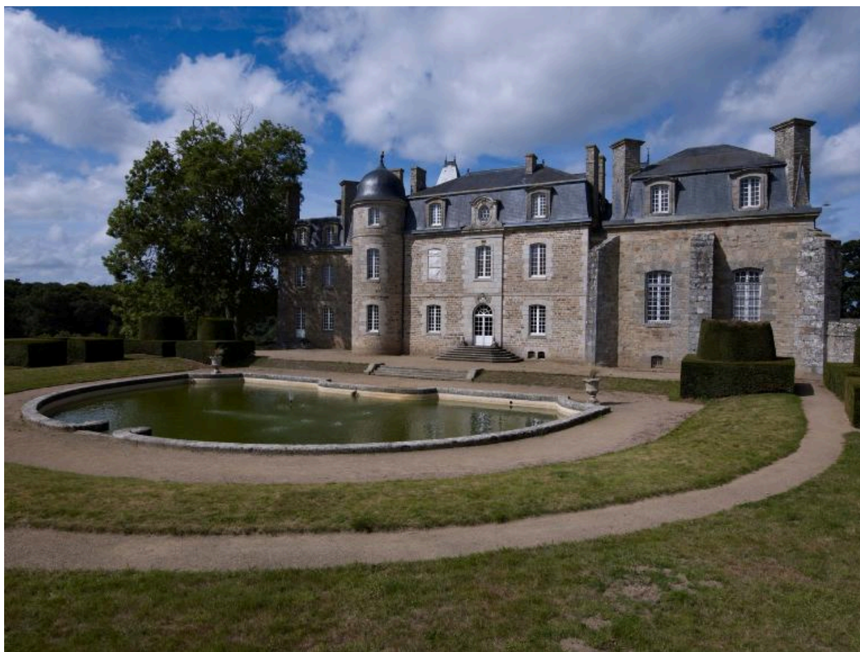
Vue générale de l'élévation orientée vers le sud-est. Au premier plan, le miroir d'eau. A droite, le chartrier encadré de contreforts
