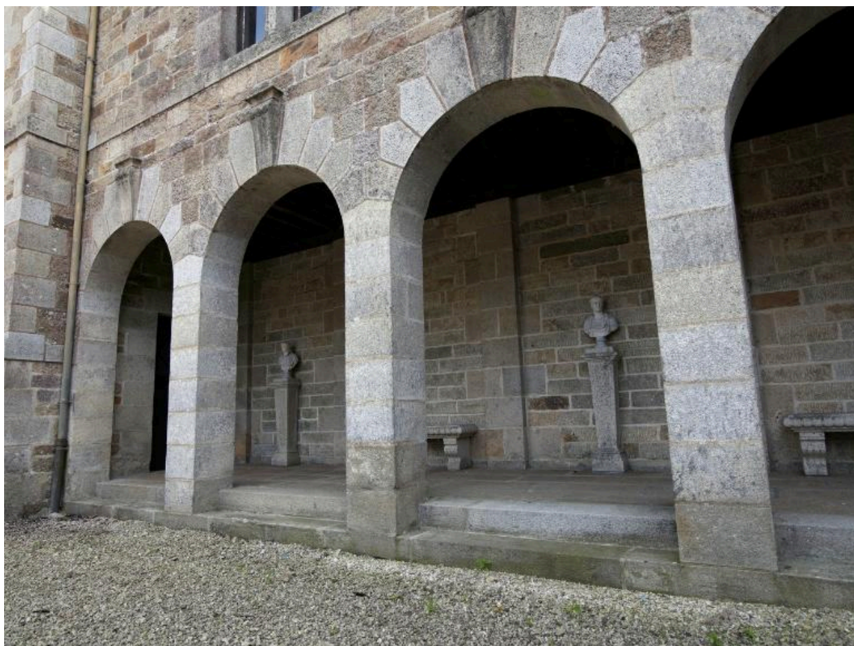
Vue de la galerie d'arcade située au sud de la cour
