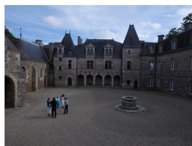
Vue de la cour intérieure Phot. Bernard Bègne IVR53_20122201134NUCA
