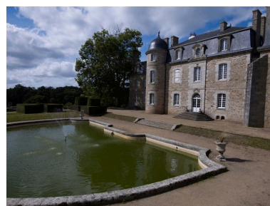
Vue de l'élévation orientée vers le sud-est. Au premier plan, le miroir d'eau Phot. Bernard Bègne IVR53_20122201098NUCA
