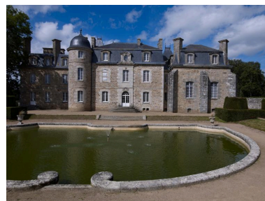
Vue générale de l'élévation orientée vers le sud-est. Au premier plan, le miroir d'eau. A droite, le chartrier encadré de contreforts Phot. Bernard Bègne IVR53_20122201097NUCA
