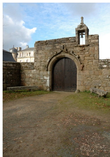
Vue de la porte charretière de style gothique surmontée d'un clocheton Phot. Guillaume Lécueillier IVR53_20112206518NUCA
