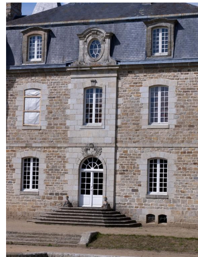
Vue de l'élévation orientée vers le sud-est : détail de la travée centrale Phot. Bernard Bègne IVR53_20122201101NUCA
