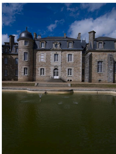
Vue de l'élévation orientée vers le sud-est. Au premier plan, le miroir d'eau Phot. Bernard Bègne IVR53_20122201096NUCA
