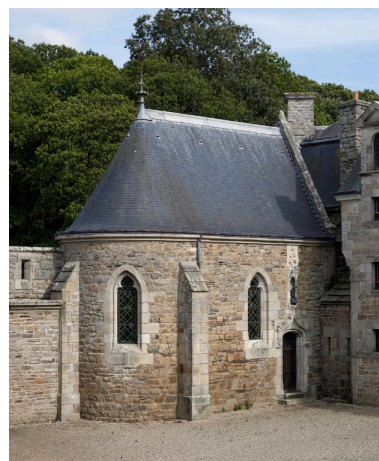
Vue de la chapelle du château Phot. Bernard Bègne IVR53_20122201144NUCA
