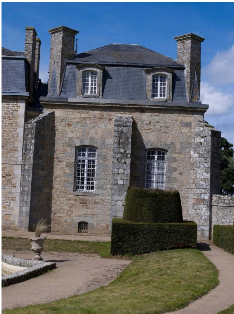
Vue de l'élévation orientée vers le sud-est : détail du chartrier encadré de contreforts
