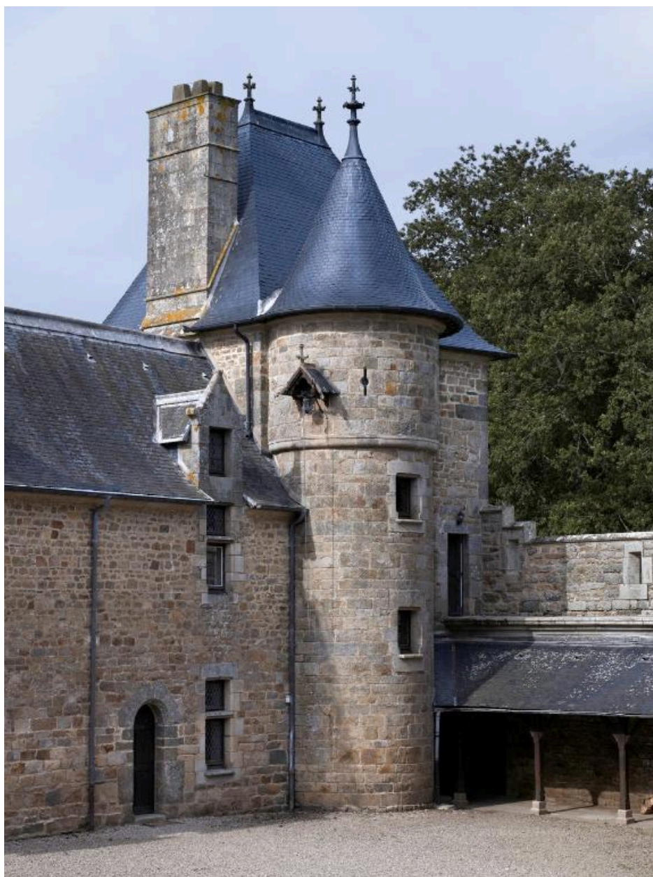
Vue du pavillon nord-est accosté d'une tour d'escalier
