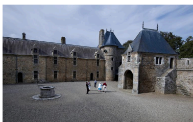
Vue de la cour. De gauche à droite : aile nord des communs, pavillon nord-est accosté d'une tour d'escalier et pavillon de la porte charretière (logis-proche) Phot. Bernard Bègne IVR53_20122201137NUCA
