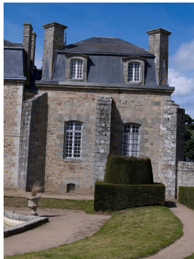
Vue de l'élévation orientée vers le sud-est : détail du chartrier encadré de contreforts Phot. Bernard Bègne IVR53_20122201100NUCA
