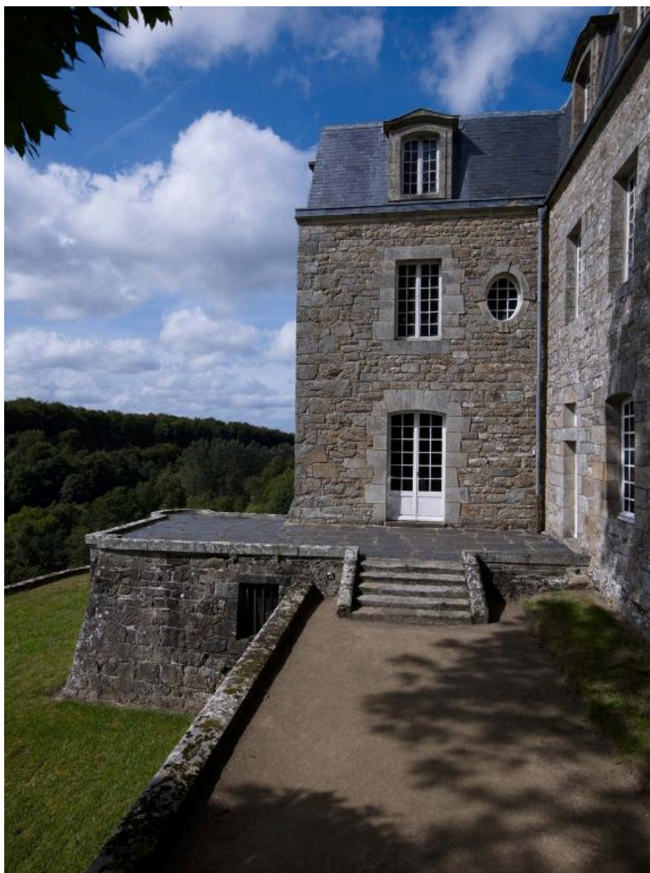
Vue de l'élévation orientée vers le sud-ouest
