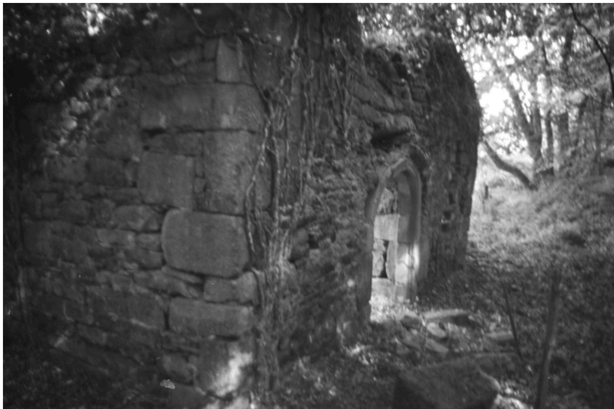
Vue des vestiges de la chapelle située au nord du château, photographie de 1974
