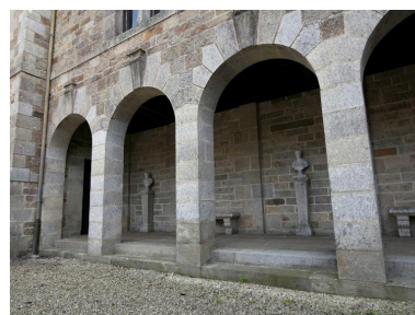
Vue de la galerie d'arcade située au sud de la cour Phot. Bernard Bègne IVR53_20122201138NUCA
