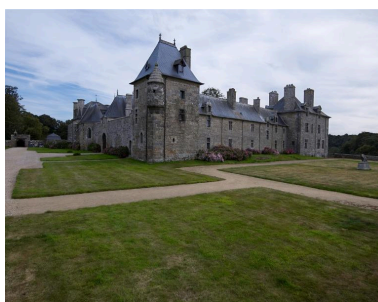
Vue générale depuis le nord Phot. Bernard Bègne IVR53_20122201154NUCA
