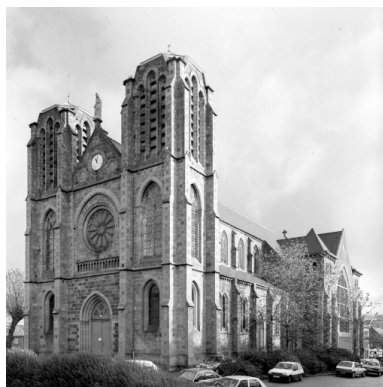
Elévation Sud-Ouest : vue générale Phot. Guy Artur, Phot. Norbert Lambart IVR53_19943502430V
