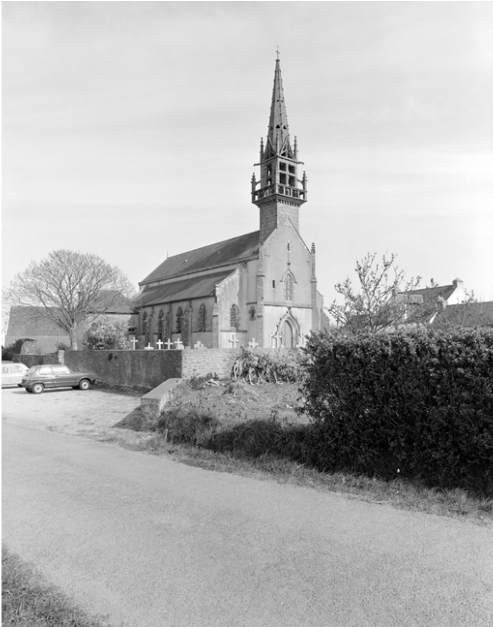
Guiler-sur-Goyen, église paroissiale Saint-Justin : vue générale nord-ouest, état en 1982
