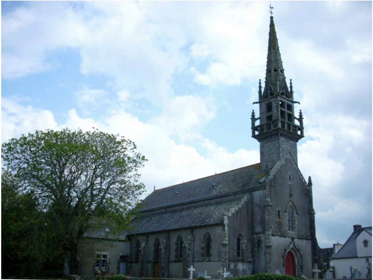
Guiler-sur-Goyen, église paroissiale Saint-Justin : vue générale nord-ouest
