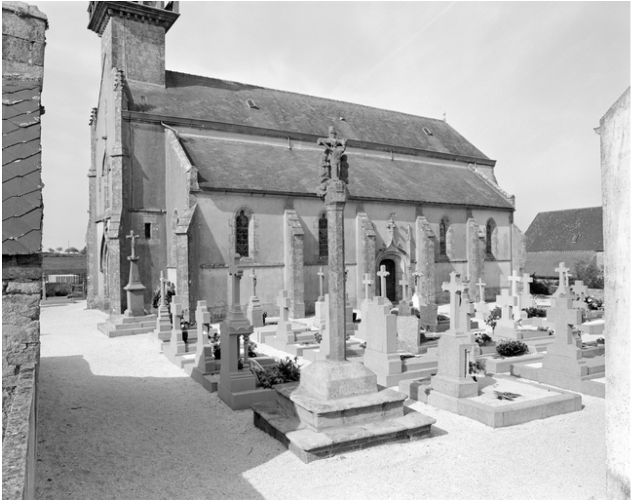
Guiler-sur-Goyen, église paroissiale Saint-Justin : élévation sud, vue générale, état en 1982
