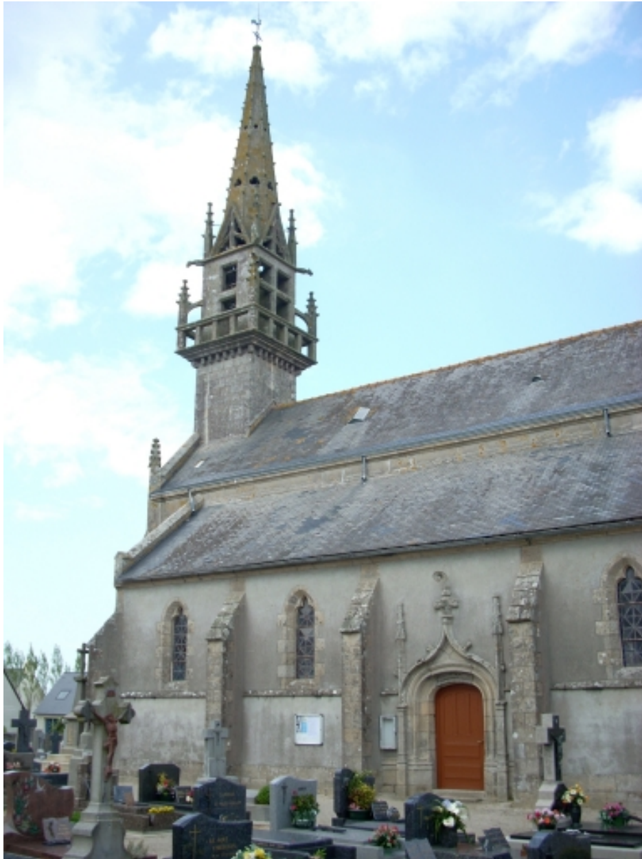
Guiler-sur-Goyen, église paroissiale Saint-Justin : vue générale sud-est
