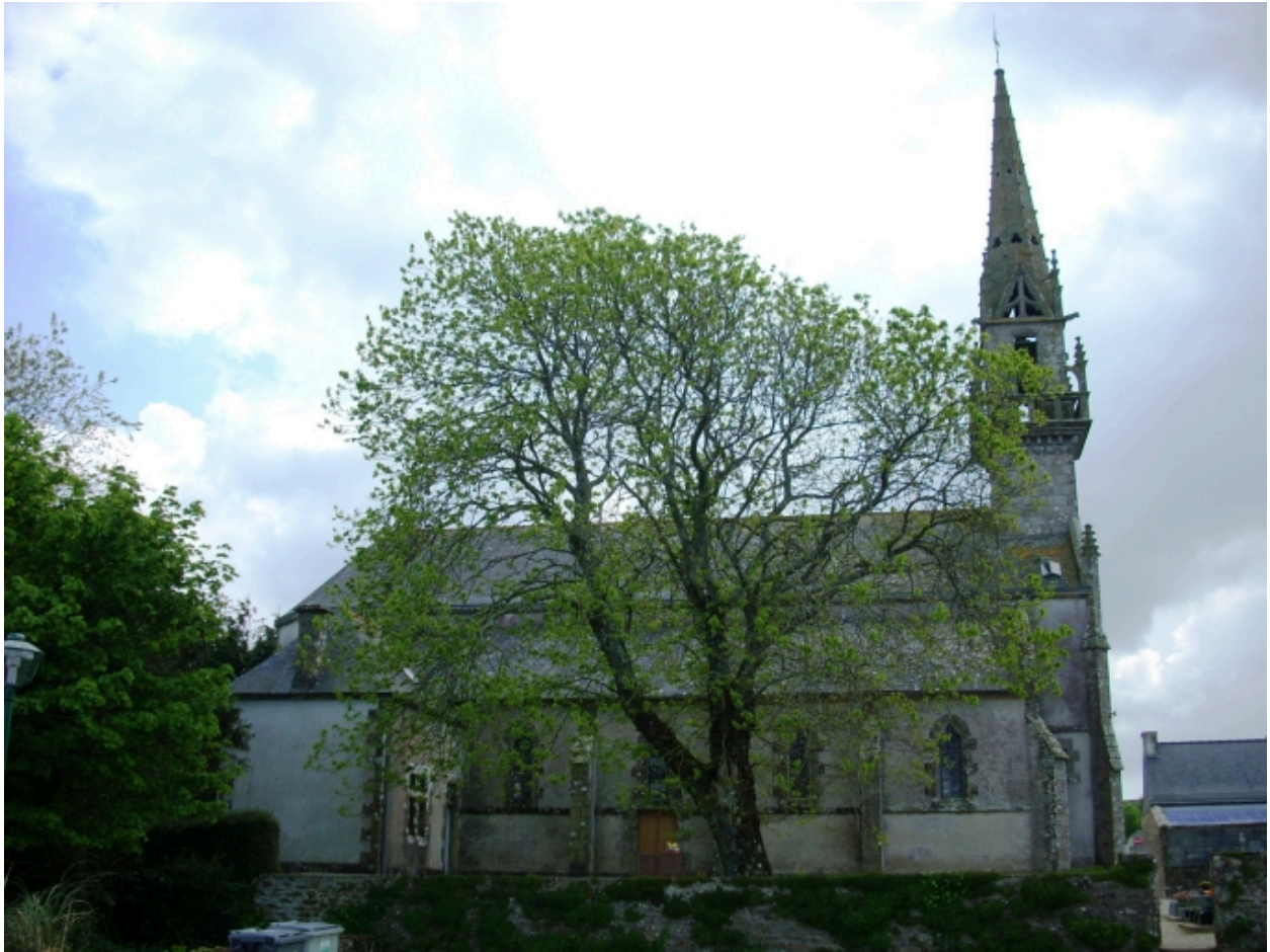
Guiler-sur-Goyen, église paroissiale Saint-Justin : élévation nord
