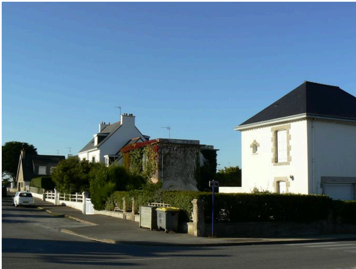
Vue générale des Villas Nestour
