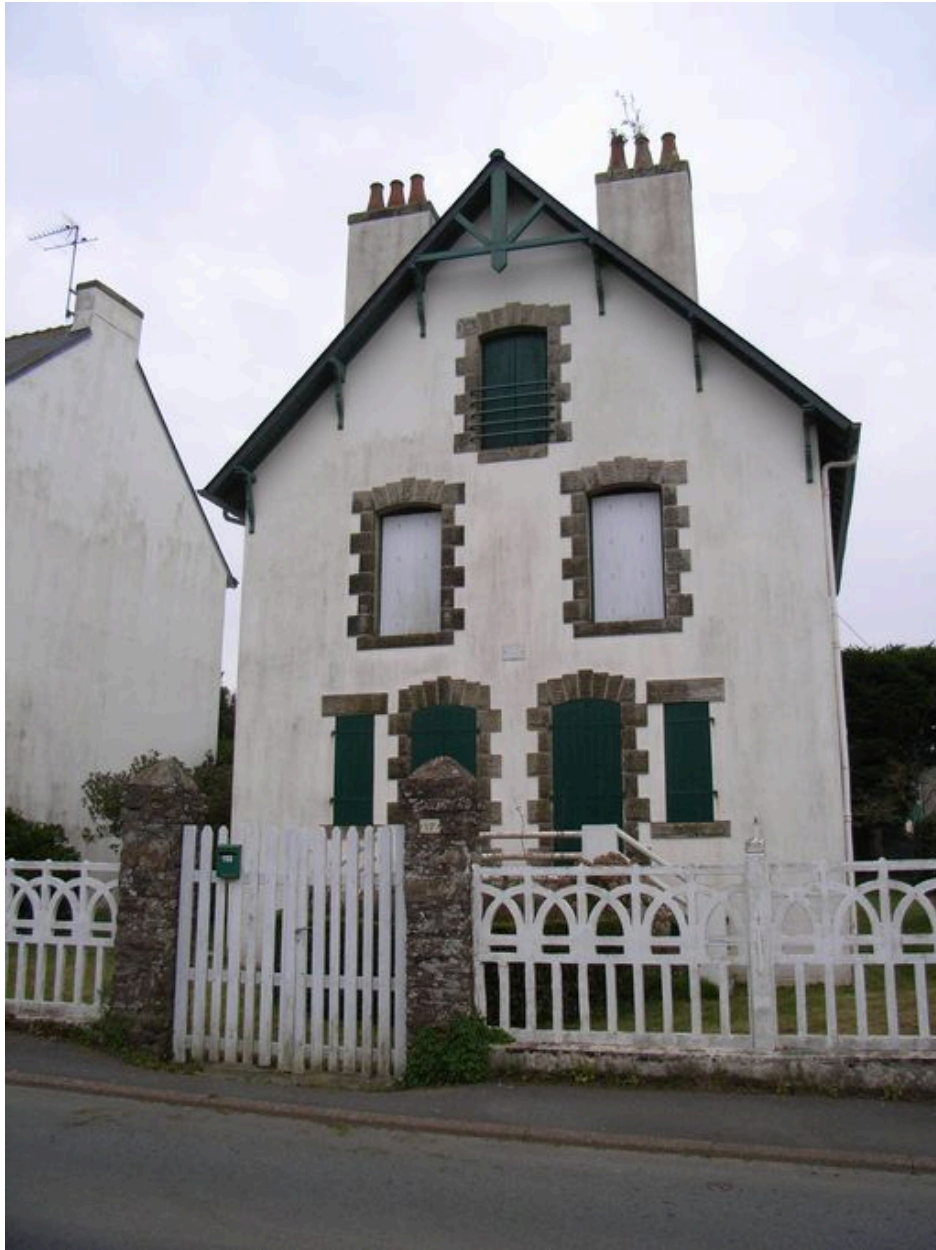
Villa Les Ajoncs, située dans le lotissement de 1910
