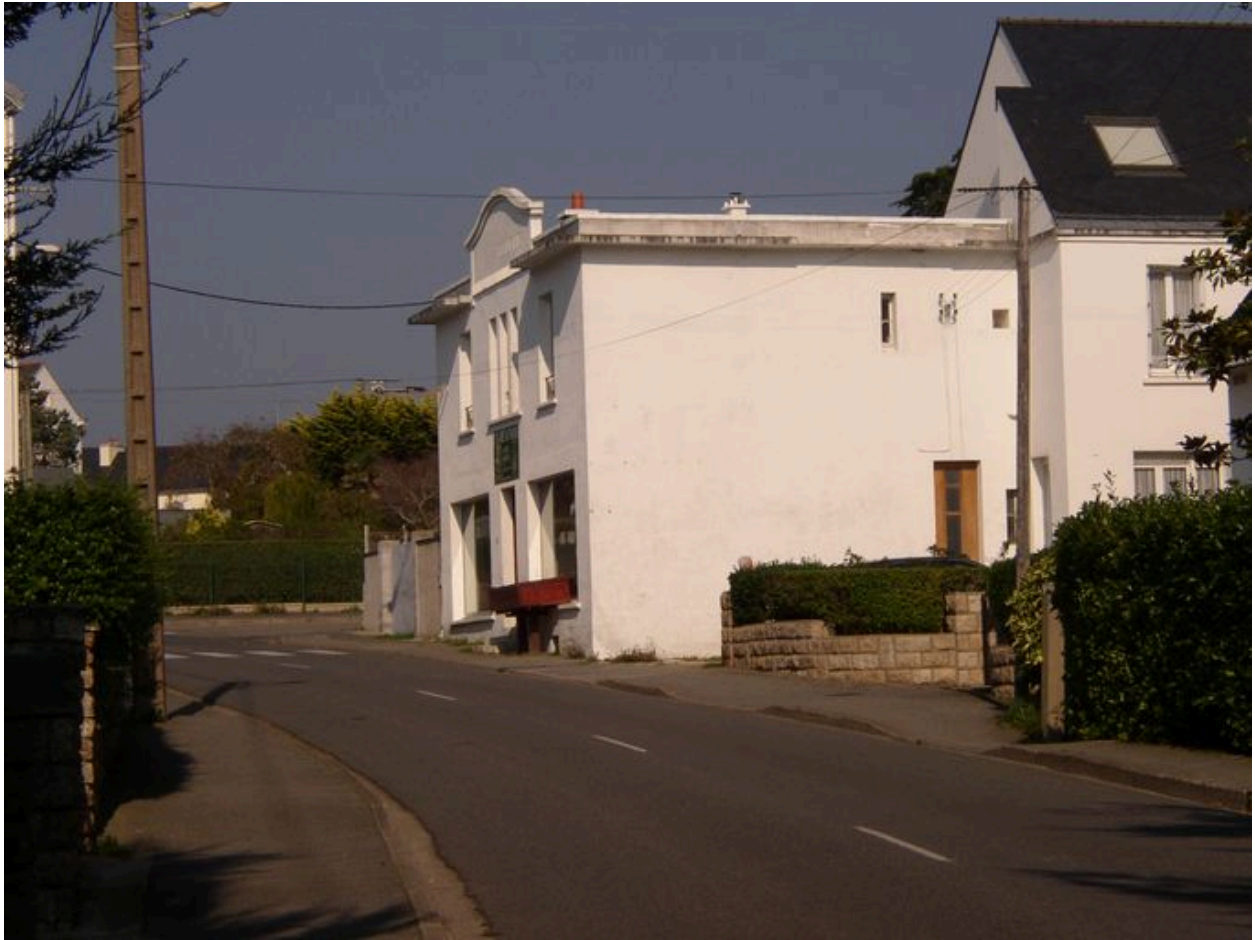
Ancien hôtel Bellevue, située à l'entrée de la station balnéaire sur la rue des Grands-Sables
