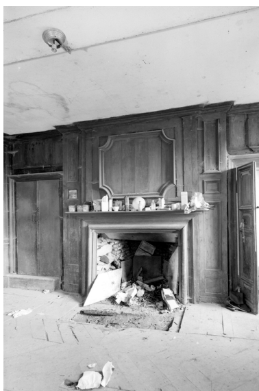
Vue de la cheminée de la pièce B du rez-de-chaussée Phot. Guy Artur IVR53_19682201446V
