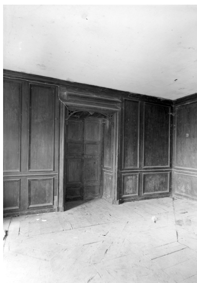
Mur ouest de la pièce B du rez-de-chaussée Phot. Guy Artur IVR53_19682201443V
