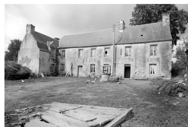
Vue de la face sud Phot. Guy Artur IVR53_19682201440V
