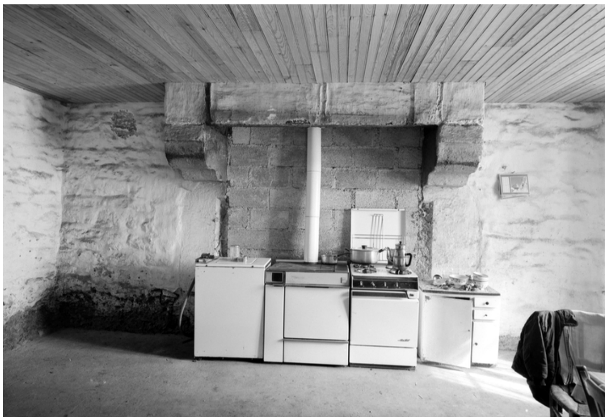
Vue de la cheminée de la pièce A du rez-de-chaussée
