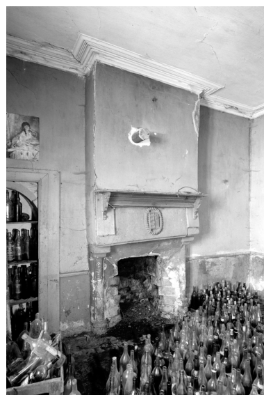
Aile ouest : cheminée du rez-de-chaussée Phot. Guy Artur IVR53_19682201445V
