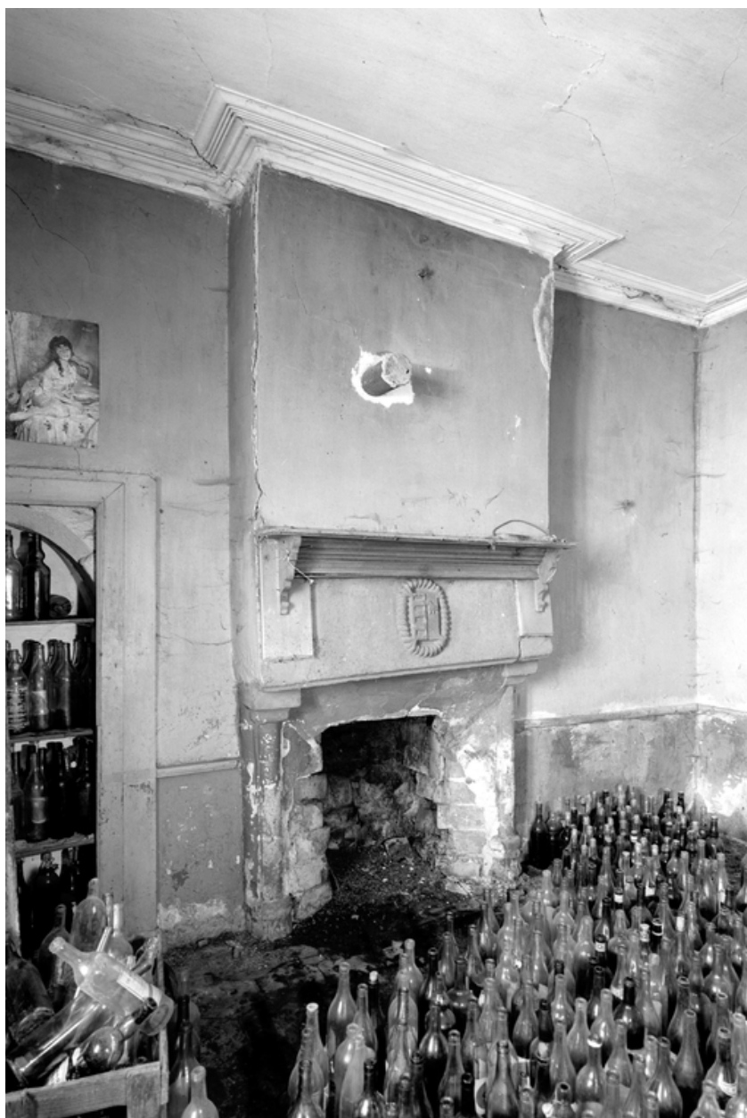
Aile ouest : cheminée du rez-de-chaussée
