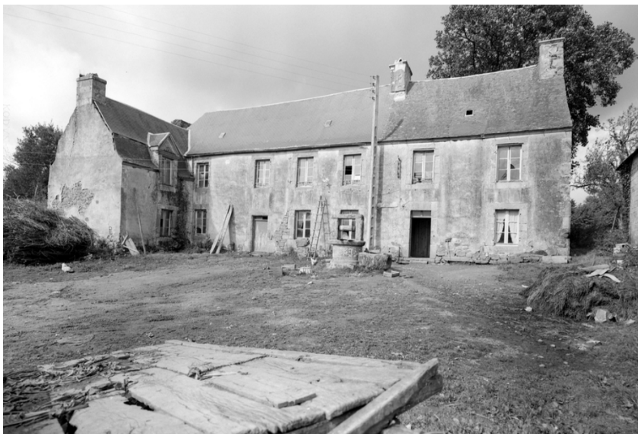
Vue de la face sud
