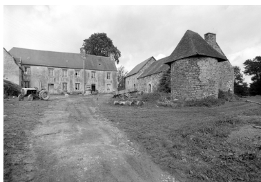
Vue générale Phot. Guy Artur IVR53_19682201439V
