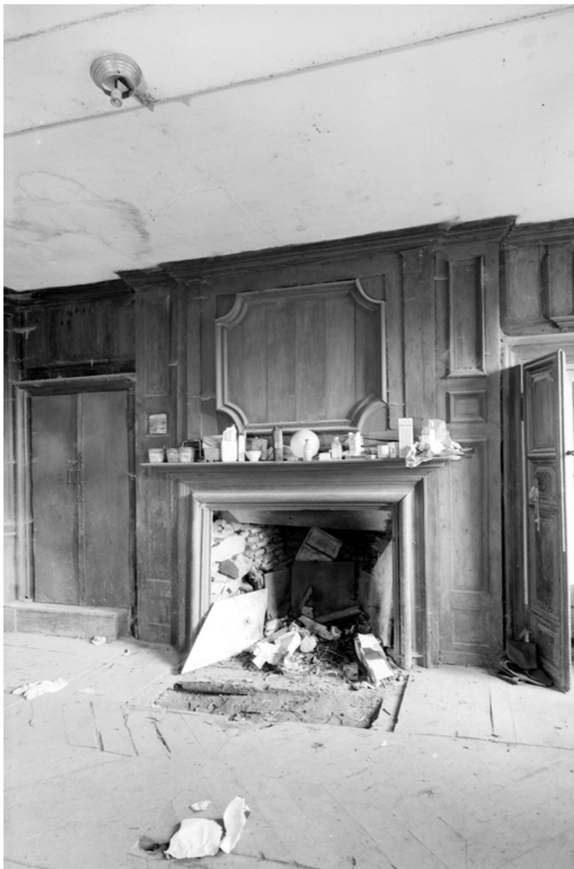
Vue de la cheminée de la pièce B du rez-de-chaussée
