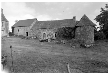
Vue de la face ouest du commun est Phot. Guy Artur IVR53_19682201441V
