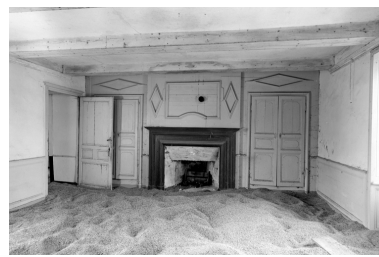
Cheminée de la pièce ouest de l'étage Phot. Guy Artur IVR53_19682201444V
