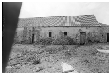
Vue de la face est du commun ouest Phot. Guy Artur IVR53_19682201442V
