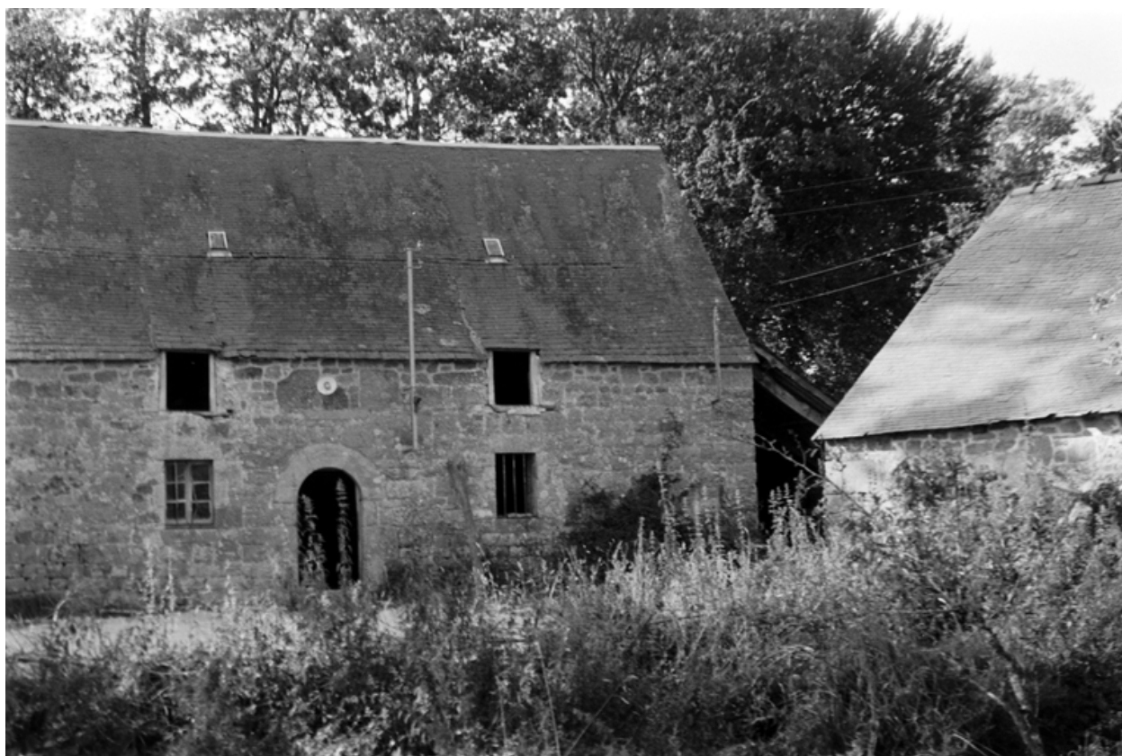
Vue de situation prise du sud
