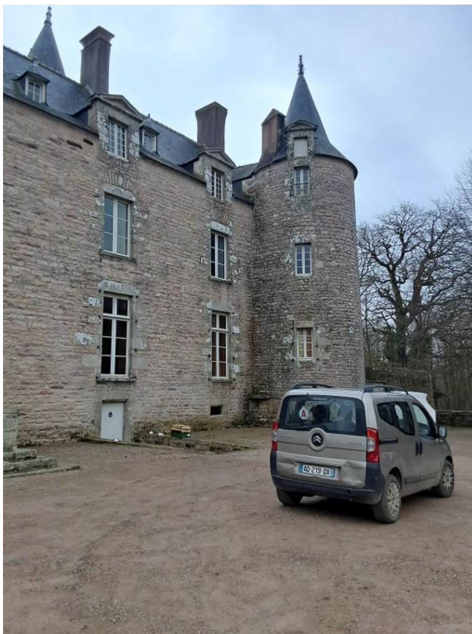
Château de Bienassis_façade ouest vue droite
