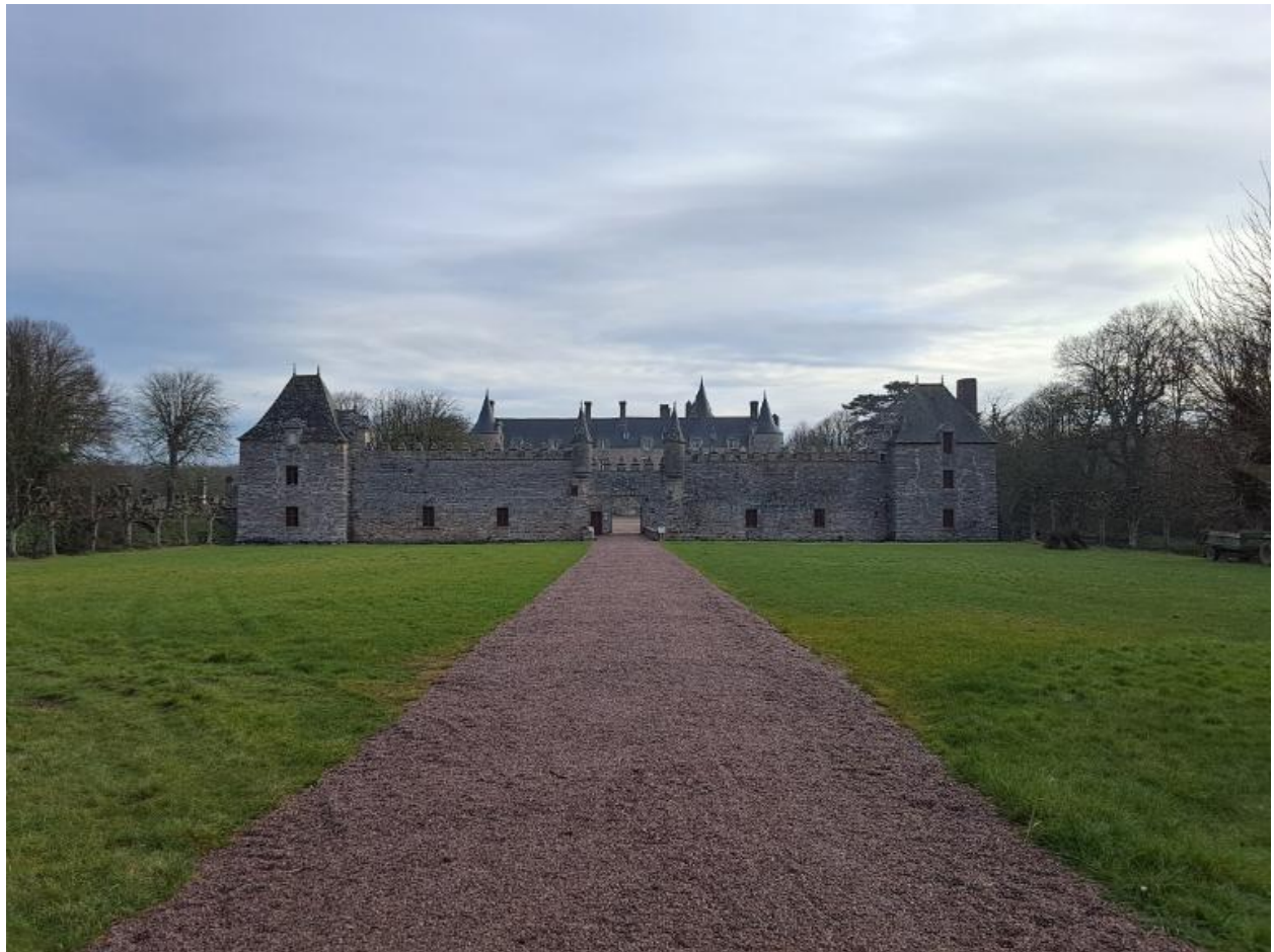
Château de Bienassis_vue générale
