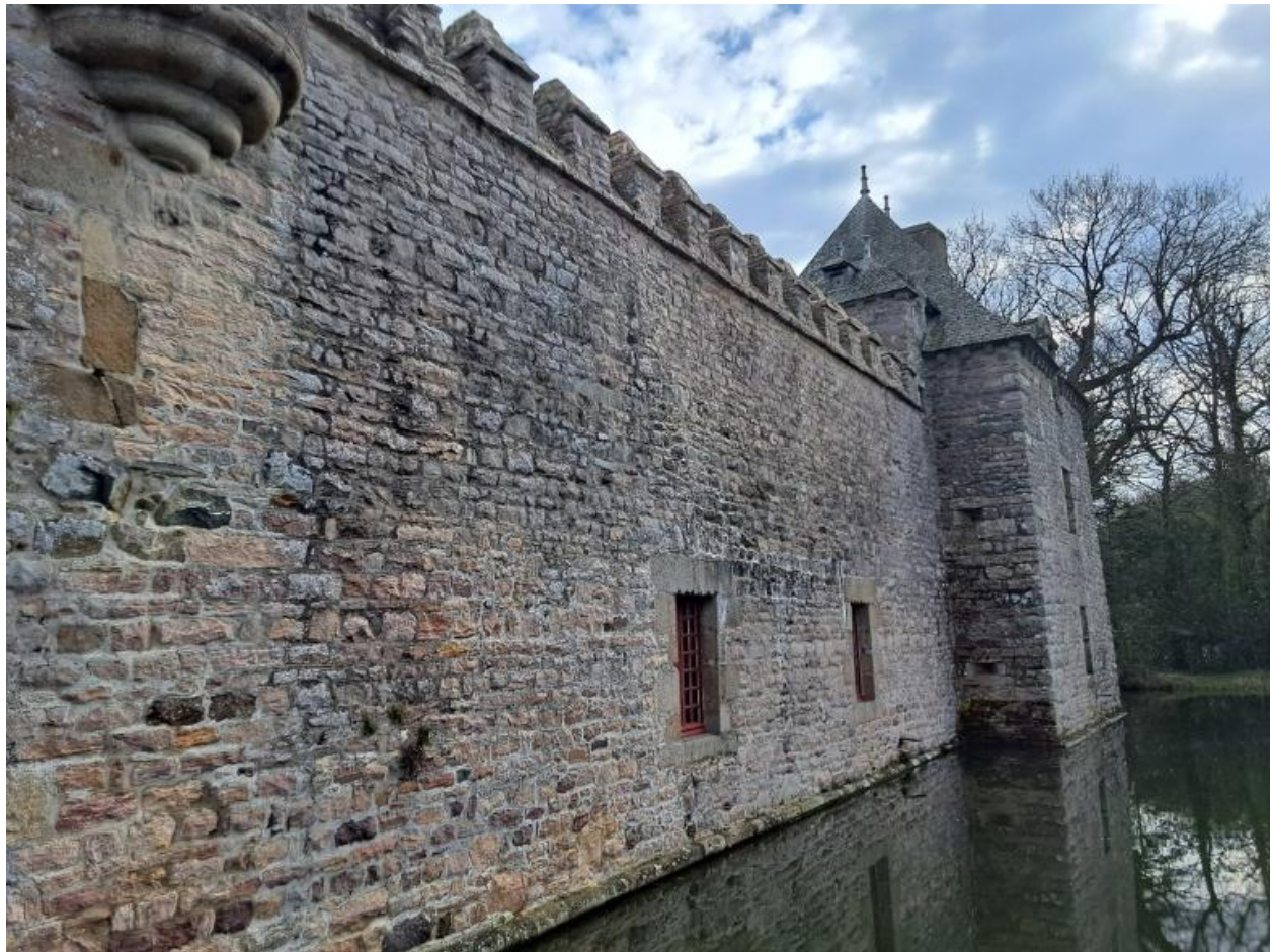
Château de Bienassis_pavillon d'angle ouest de l'enceinte
