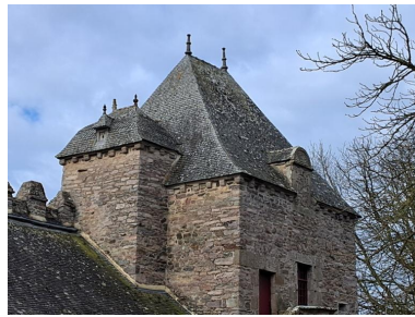
Château de Bienassis_pavillon d'angle Est de l'enceinte_vue toiture pavillon ; corniche ; épis de faîtages ; fronton curviligne orné Phot. Flavie Dupont IVR53_20252210125NUCA
