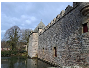
Château de Bienassis_pavillon d'angle Est de l'enceinte Phot. Flavie Dupont IVR53_20252210128NUCA
