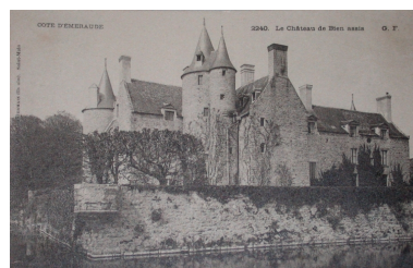
Château de Bienassis : façade postérieure du corps de logis, 1er quart du 20ème siècle (AD 22) Repro. Patrick Pichouron, Autr. Grégoire Germain IVR53_20042207655NUCB
