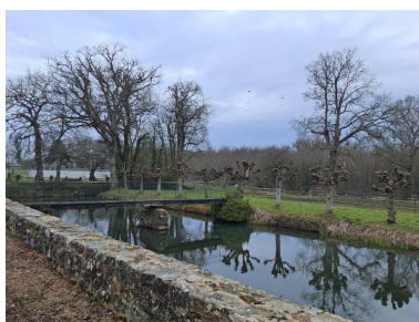
Douves_vue est Phot. Flavie Dupont IVR53_20252210115NUCA
