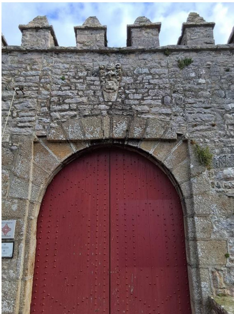
Château de Bienassis_porte du porche de l'enceinte_détail : armoiries
