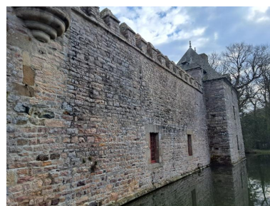
Château de Bienassis_pavillon d'angle ouest de l'enceinte Phot. Flavie Dupont IVR53_20252210127NUCA
