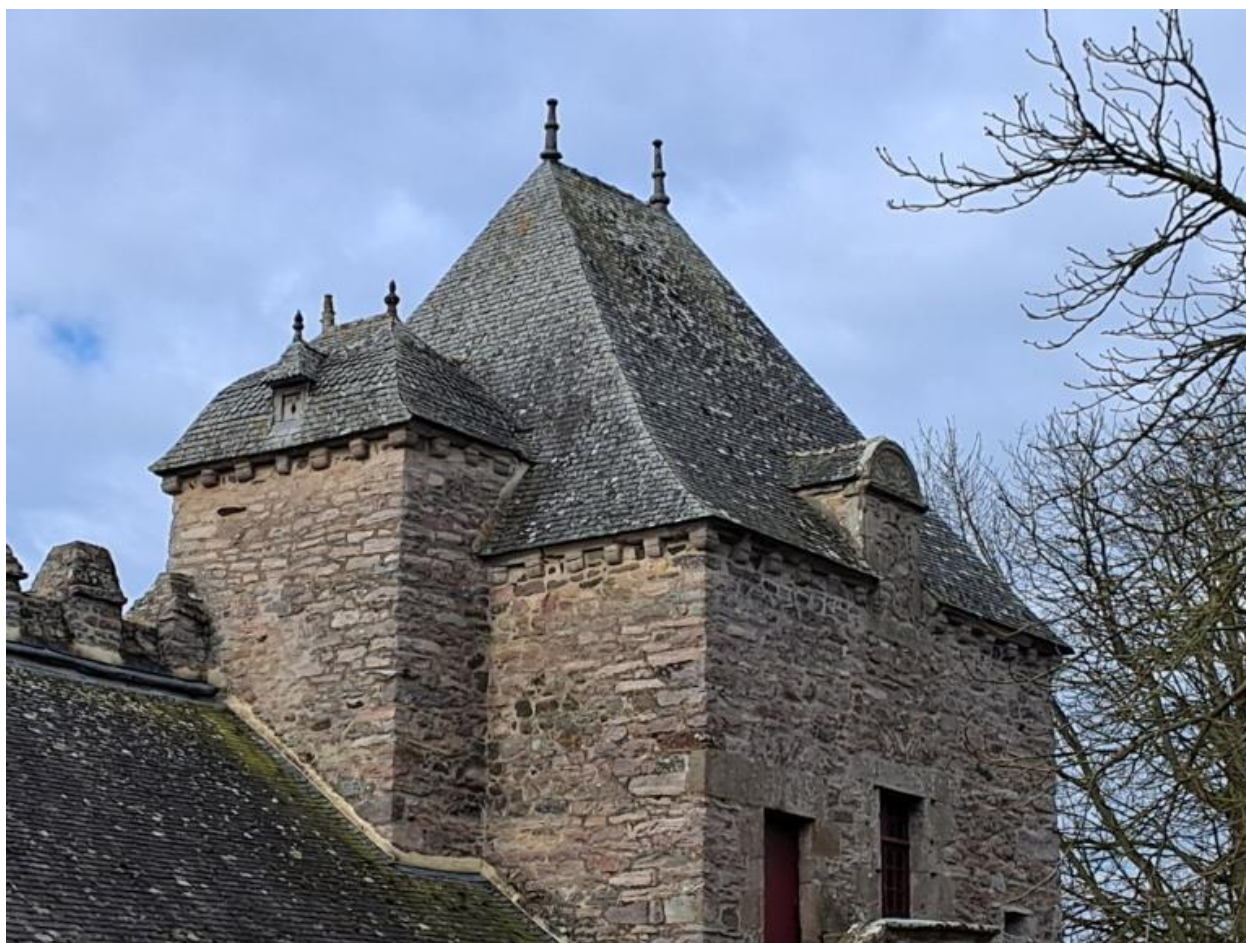
Château de Bienassis_pavillon d'angle Est de l'enceinte_vue toiture pavillon ; corniche ; épis de faîtages ; fronton curviligne orné
