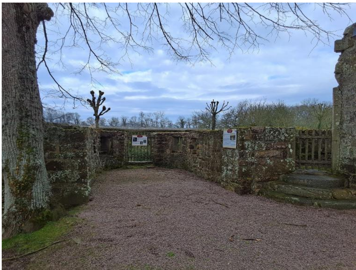
Ancien mur d'enceinte_ancienne tour
