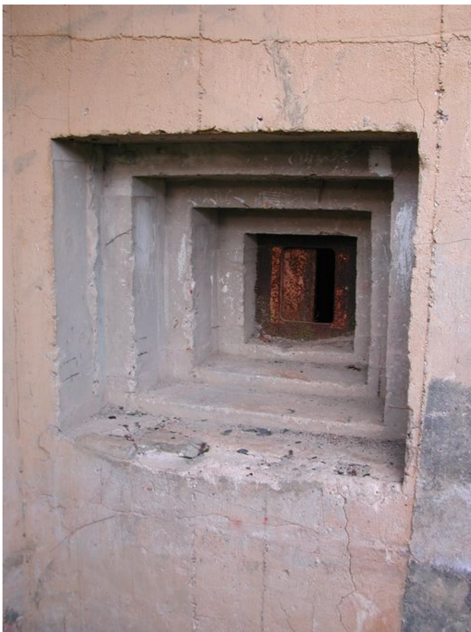
Vue du créneau de défense d'entrée (état en 2002). Il s'agit d'une embrasure en gradin : la peinture ocre est d'origine
