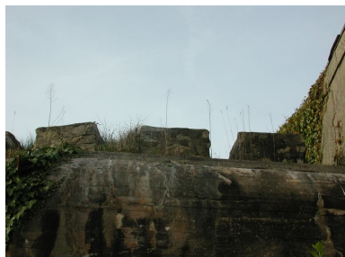
Vue des faux merlons et des créneaux de la dalle de couverture : le camouflage du bunker était particulièrement bien soigné (état en 2002) Phot. Guillaume Lécueillier IVR53_20022901553NUCA
