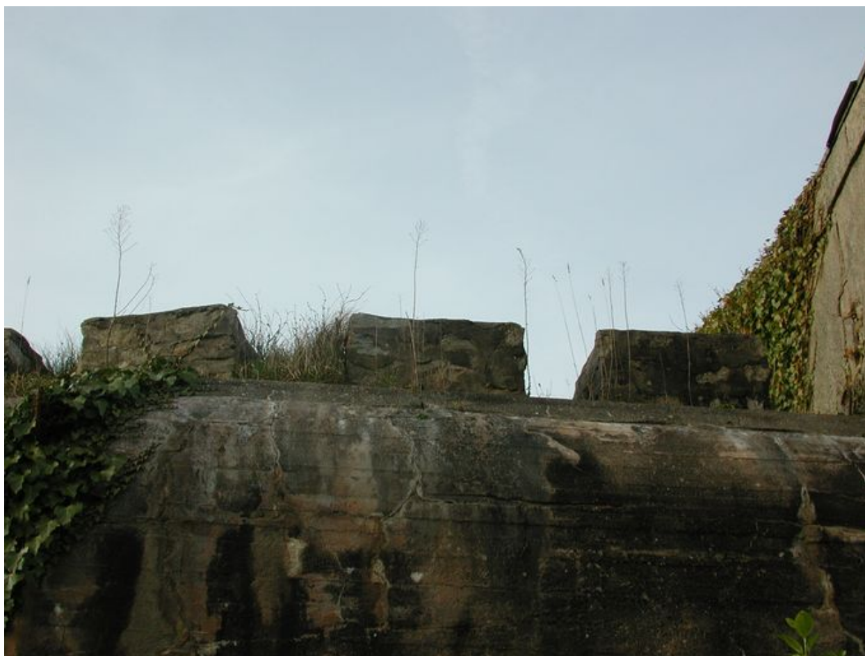
Vue des faux merlons et des créneaux de la dalle de couverture : le camouflage du bunker était particulièrement bien soigné (état en 2002)
