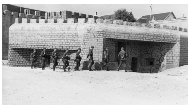
Vue d'une patrouille allemande devant le bunker - casemate (collection particulière). On notera le camouflage particulièrement bien soigné du bunker : merlons et créneaux de la dalle de couverture, faux appareillage et plantes grimpantes en peinture...
