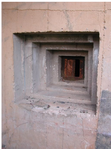
Vue du créneau de défense d'entrée (état en 2002). Il s'agit d'une embrasure en gradin : la peinture ocre est d'origine Phot. Guillaume Lécueillier IVR53_20022901536NUCA
