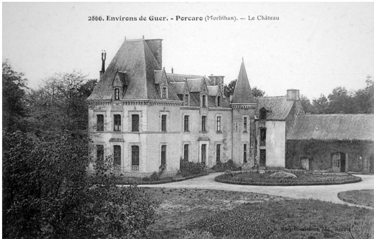
Vue générale (Archives départementales d'Ille-et-Vilaine, 6 Fi Porcaro)
