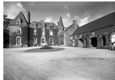
Vue générale sud-est : état en 1986 Phot. François Dagorn IVR53_19775600701V
