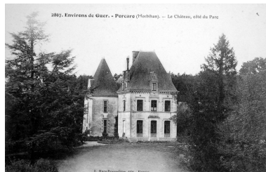
Vue latérale (Archives départementales d'Ille-et-Vilaine, 6 Fi Porcaro) Phot. Elise Lauranceau IVR53_20045606195NUCB
