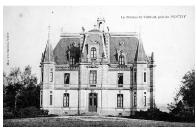
Vue générale Phot. Elise Lauranceau IVR53_20045606258NUCB
