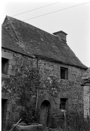
Ferme de Kerbouzard : façade sud Phot. Hermon IVR53_19682201987V
