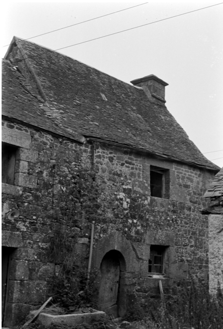
Ferme de Kerbouzard : façade sud
