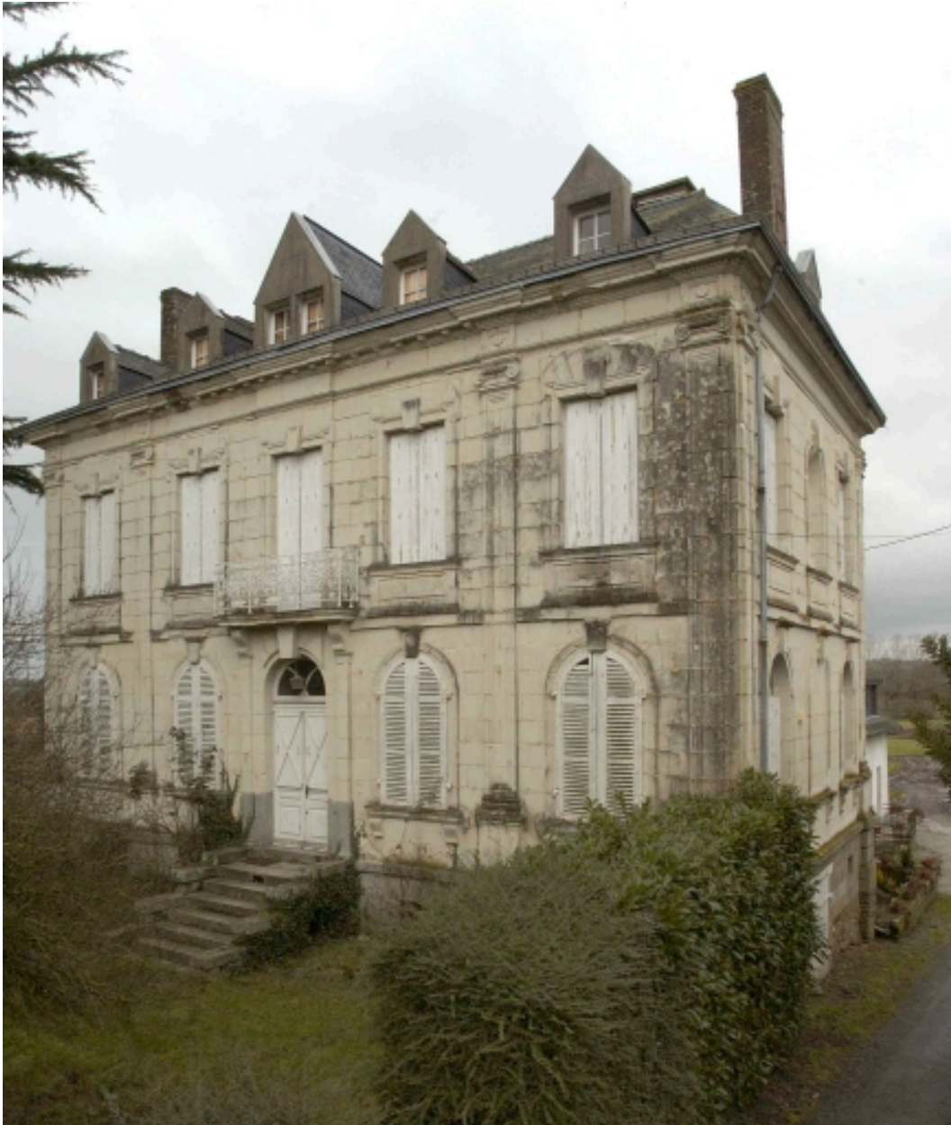
Vue générale sud-est
