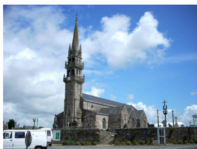
Plouneventer, église paroissiale Saint-Néventer : vue générale sud-ouest Phot. Gwénaél Fauchille IVR53_20082906457NUCA
