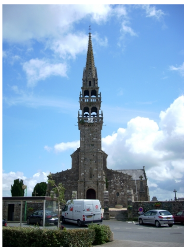
Plouneventer, église paroissiale Saint-Néventer : élévation ouest Phot. Gwénaél Fauchille IVR53_20082906458NUCA
