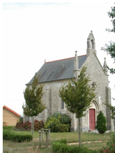
Vue générale nord ouest Phot. Claude Quillivic IVR53_20033517251NUCA
