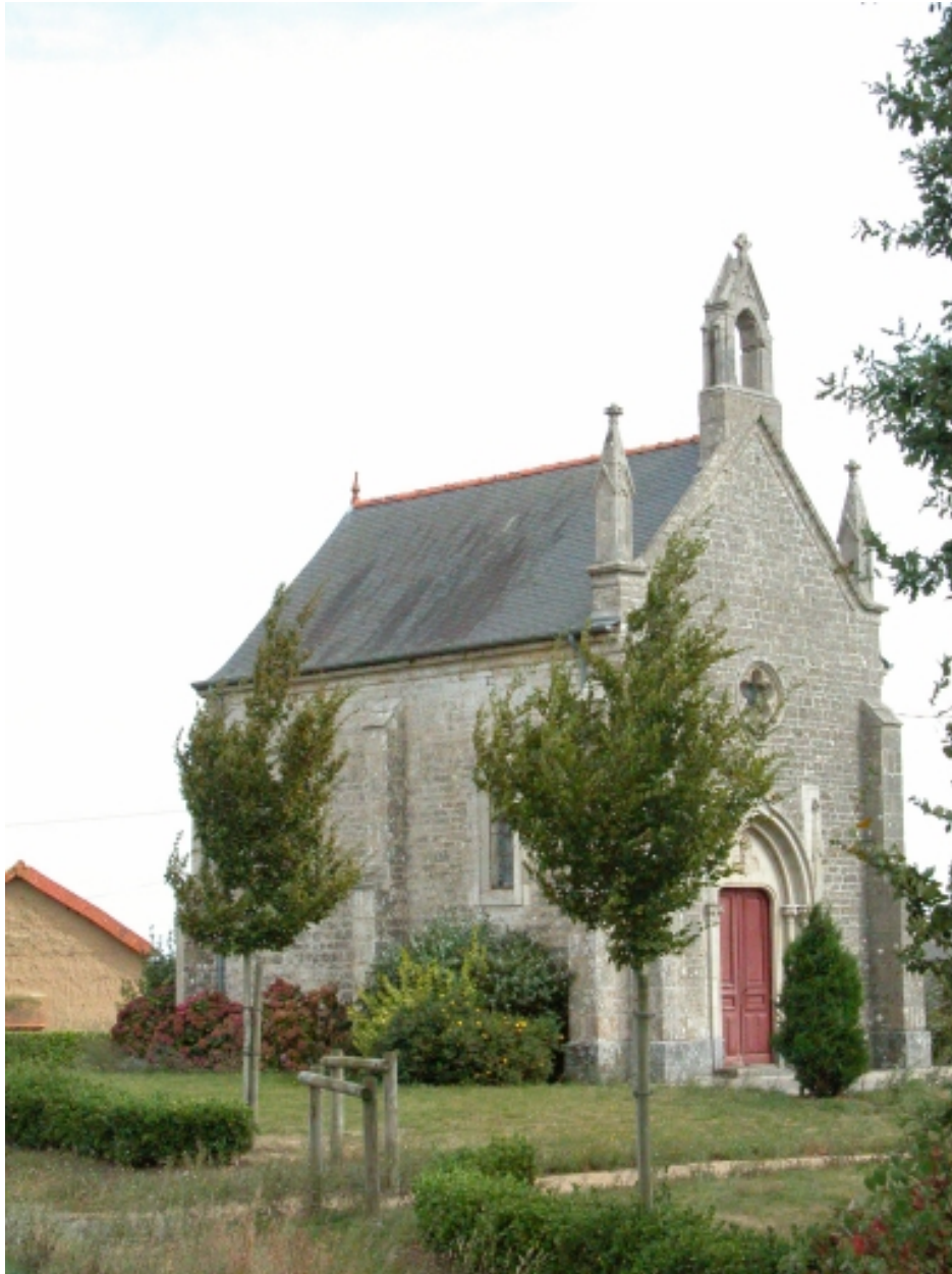
Vue générale nord ouest
