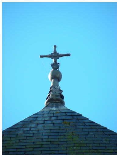
Epi de faitage Phot. Sabrina Dalibard IVR53_20073508608NUCA
