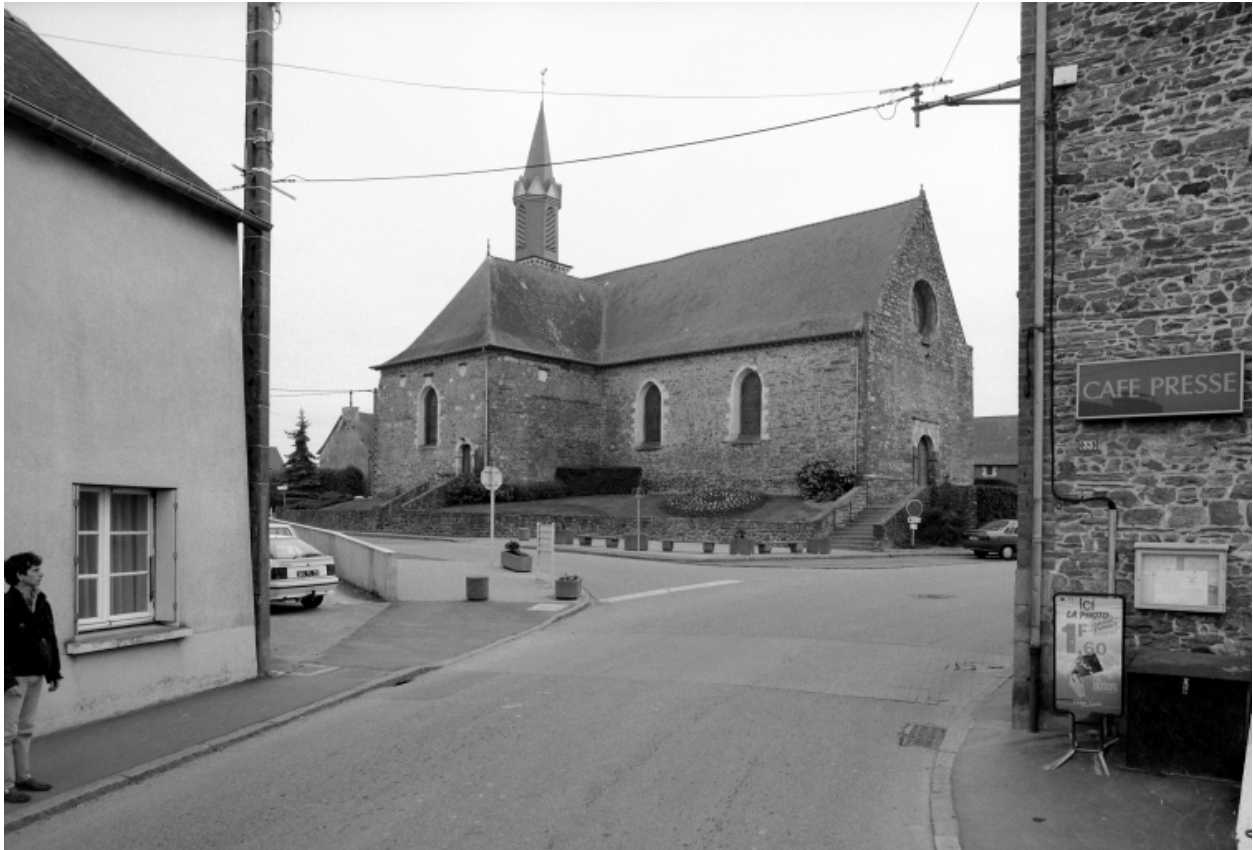
Elévation Nord-Ouest : vue générale
