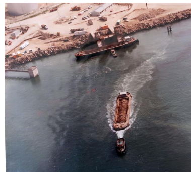
Chargement des chalands par camions à partir de l'appontement, remorqués jusqu'au site de versement (15/06/77) Repro. Erwana L'Haridon, Phot. Gernot IVR53_20212905839NUCA
