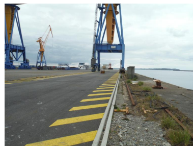
QR 4 : grues et voies de grues Phot. Région Bretagne IVR53_20212905890NUCA
