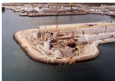
Travaux en cours : bajoyers bâbord et tribord, 3 têtes de forme, radier, QR4, QR5 (18/05/1979) Repro. Erwana L'Haridon IVR53_20212905852NUCA
