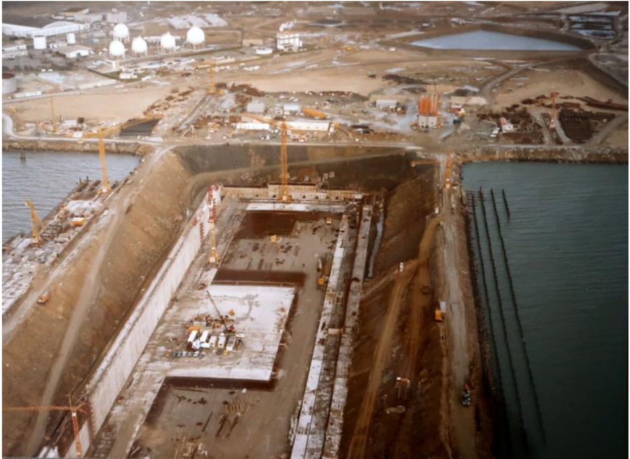
Forme 3 : bajoyer en cours de construction, radier, mis en place des pieux du QR5 (14/12/1978)
