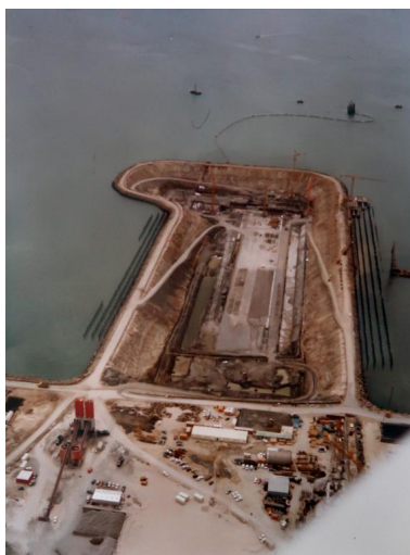
Travaux de la forme 3, batardeau, terrassement, radier (12 mai 1978) Repro. Erwana L'Haridon, Phot. Gernot IVR53_20212905833NUCA
