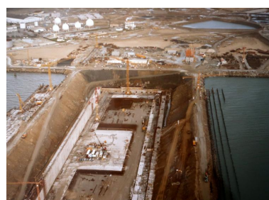
Forme 3 : bajoyer en cours de construction, radier, mis en place des pieux du QR5 (14/12/1978) Repro. Erwana L'Haridon, Phot. Gernot IVR53_20212905836NUCA
