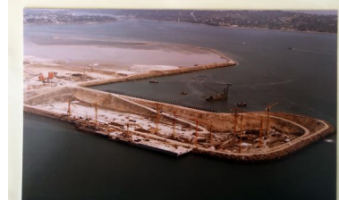
Forme 3 : batardeau, palplanches, radis, quai de réparation 4 (08/1978) Repro. Erwana L'Haridon, Phot. Gernot IVR53_20212905838NUCA
