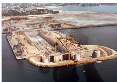
Installation des grues sur le QR4, radier et bajoyers de la forme, lignes de tins, têtes de forme avec emplacement du garage du bateau-porte, QR5 en cours de construction (septembre 1979) Repro. Erwana L'Haridon, Phot. Gernot IVR53_20212905840NUCA
