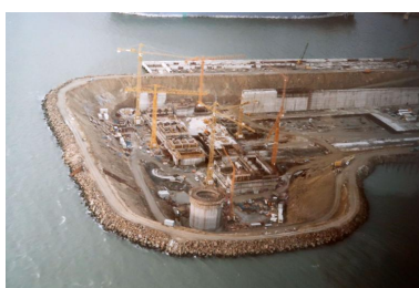
Forme 3 : bajoyer en cours de construction, QR4, gabion du bateau-porte (14/12/1978) Repro. Erwana L'Haridon, Phot. Gernot IVR53_20212905835NUCA
