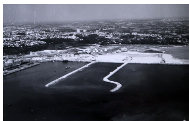
Travaux forme 3, cordons d'enrochements du batardeau (1977) Repro. Erwana L'Haridon IVR53_20212957813NUCA
