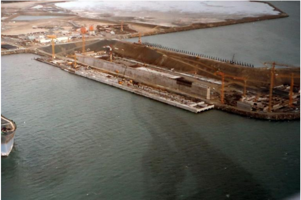
Forme 3 : QR4 et bajoyer bâbord en cours de construction (14/12/1978)
