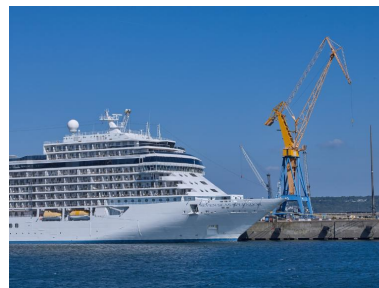
Paquebot à quai et grues de la forme n°3 Phot. Bernard Bègne IVR53_20232900366NUCA
