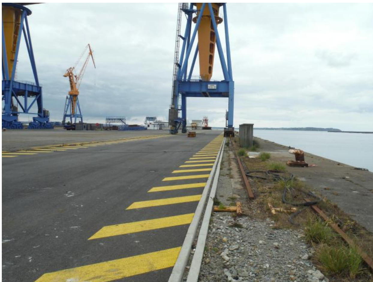
QR 4 : grues et voies de grues
