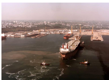
Le Licorne Pacifique, pétrolier de 269 000 tonnes en février 1980 Repro. Erwana L'Haridon, Phot. Gernot IVR53_20212905831NUCA
