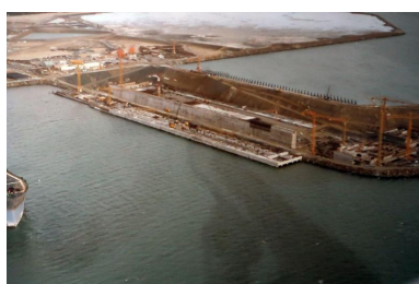
Forme 3 : QR4 et bajoyer bâbord en cours de construction (14/12/1978) Repro. Erwana L'Haridon, Phot. Gernot IVR53_20212905834NUCA
