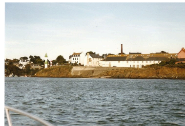
Ancienne conserverie Capitaine Cook, vue du large Phot. Evelyne Dumont IVR53_20082908684NUCA
