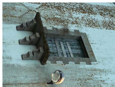
Balcon d'un des bâtiments nord de l'ancienne conserverie Capitaine Cook, donnant sur la ria Phot. Johan Vincent IVR53_20072909029NUCA
