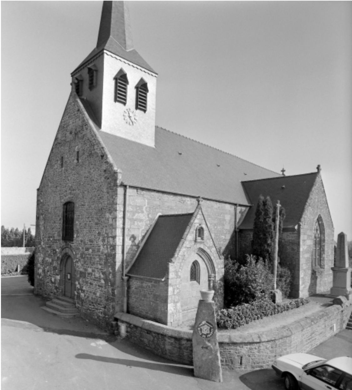
Elévation Sud-Ouest : vue générale
