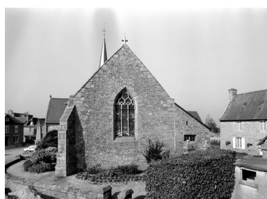
Elévation Sud-Est : vue générale Phot. Guy Artur, Phot. Norbert Lambart IVR53_19943502154X
