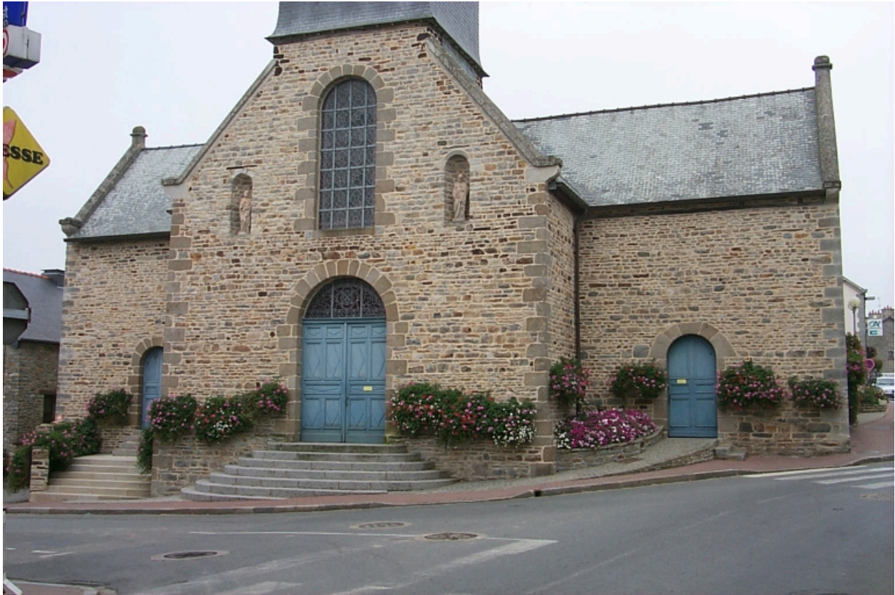
Vue générale ouest
