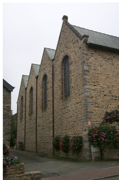
Vue partielle nord-ouest Phot. Xavier Gilbert IVR53_20013509925NUCA
