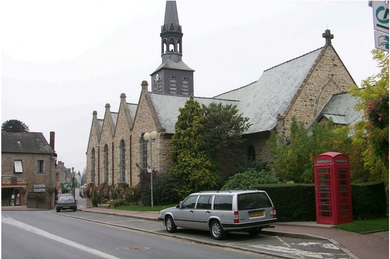
Vue générale sud-est
