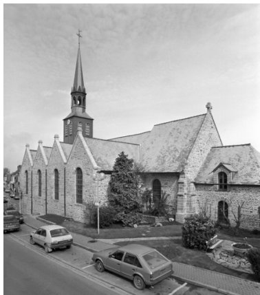
Vue générale sud-est Phot. Guy Artur, Phot. Norbert Lambart IVR53_19943500778X
