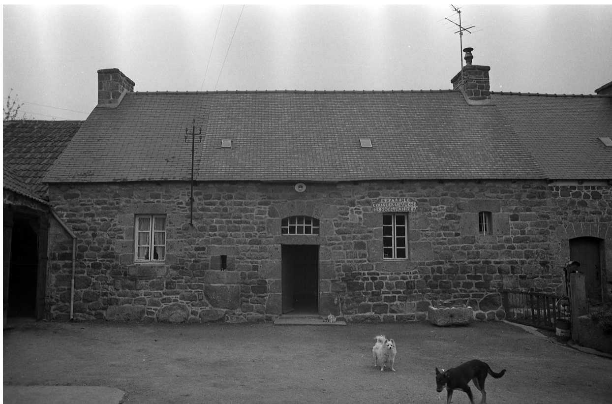
Vue générale de la façade sud.
