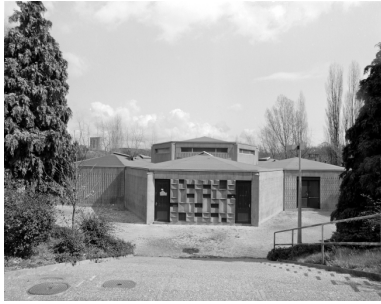
Elévation Ouest : vue générale
