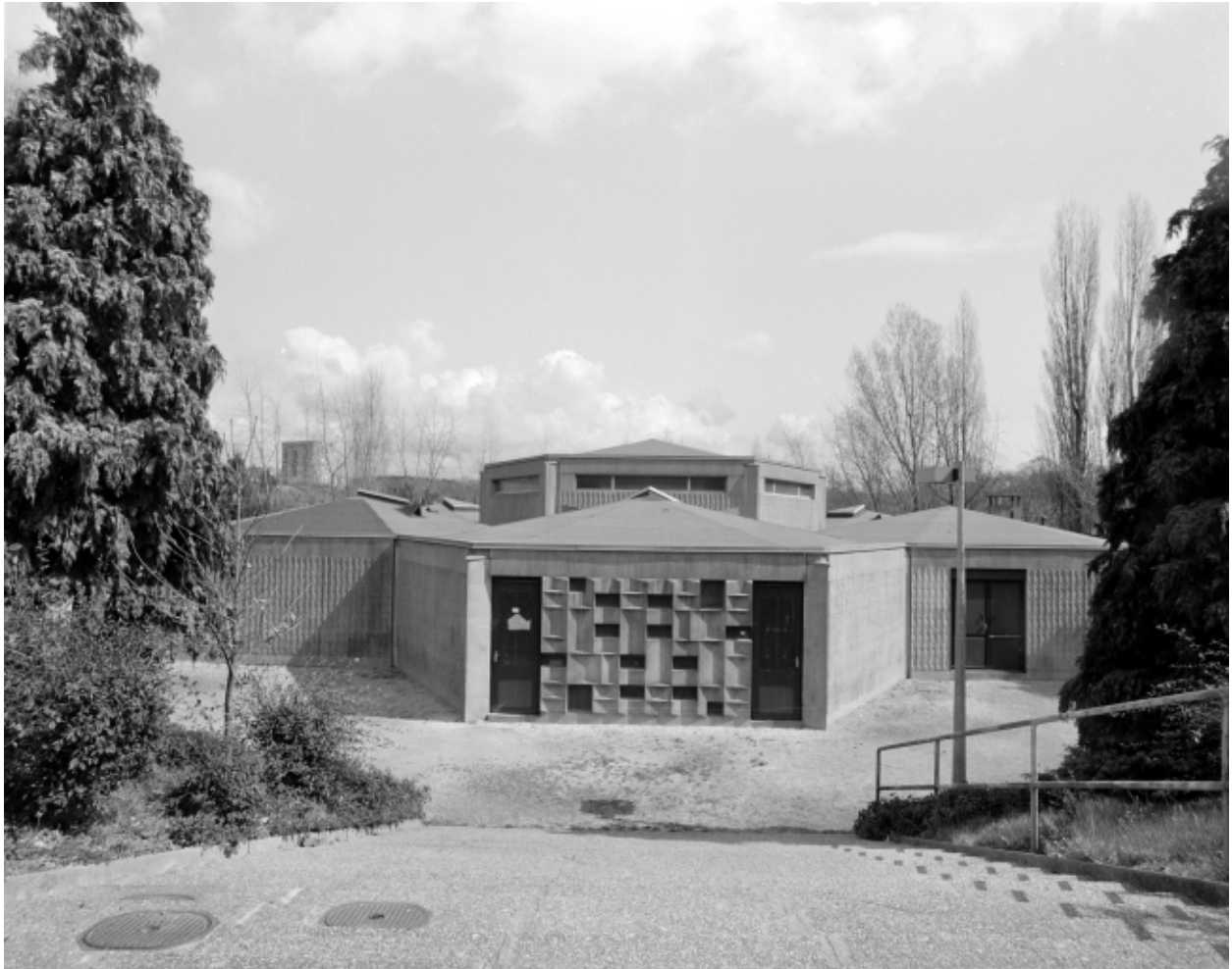
Elévation Ouest : vue générale
